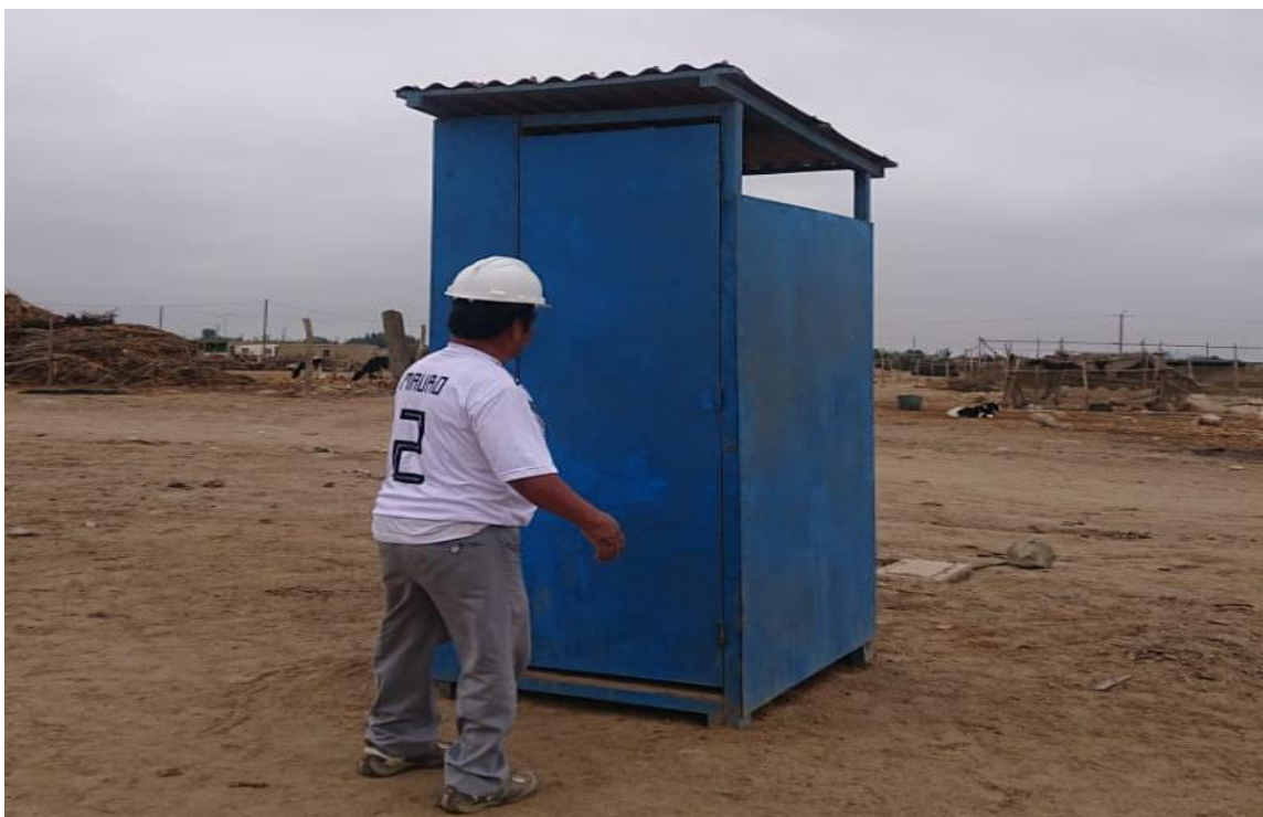
Fotografía 04: Letrinas mejoradas con arrastre hidráulico.
