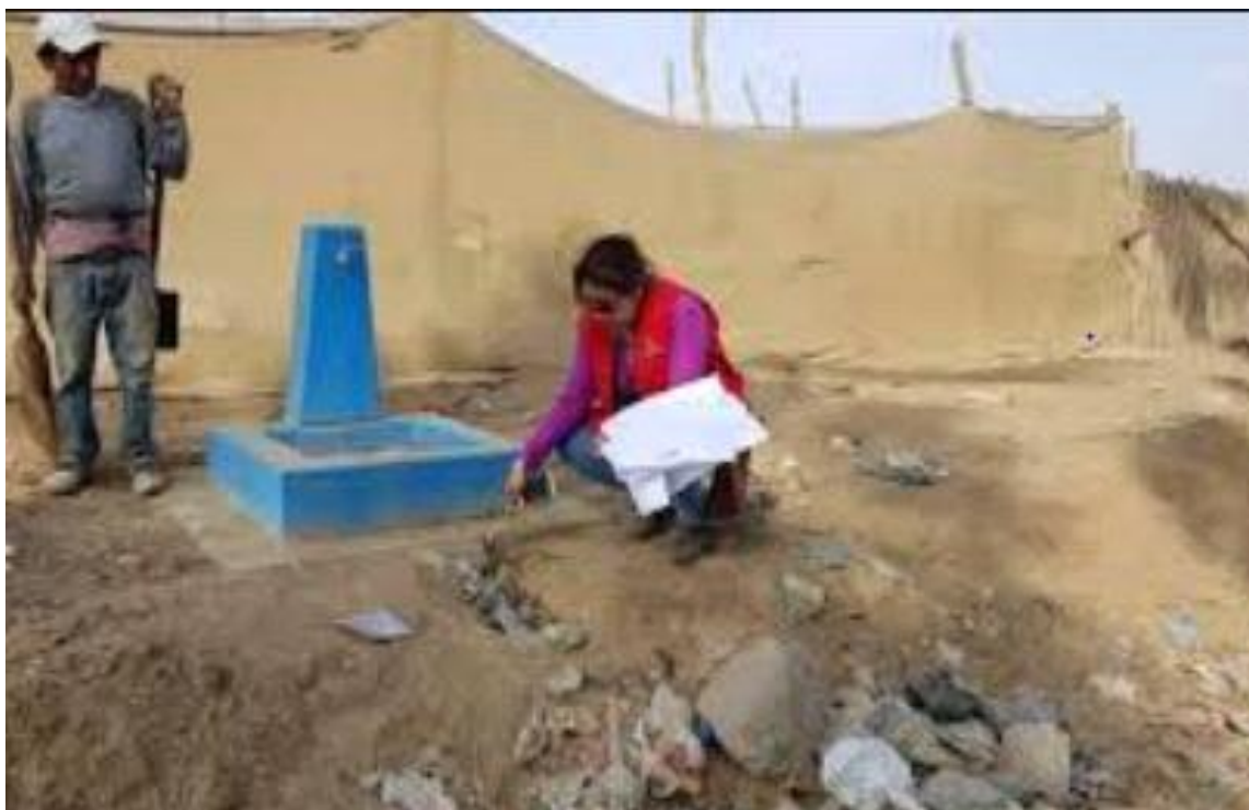
Fotografía 16: Evaluación de la obra en la comunidad de Villa Sol.
