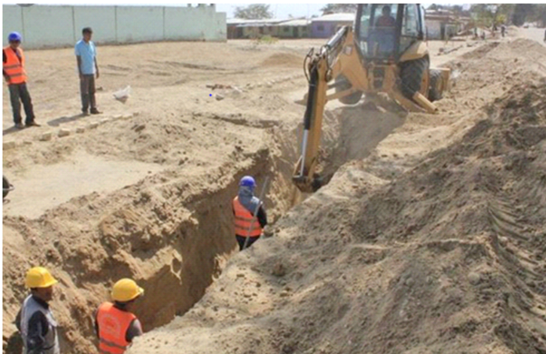
Figura 2.3: Contrucción de la línea de aducción. Fuente:(Municipalidad Distrital de Grocio Prado, 2019).
