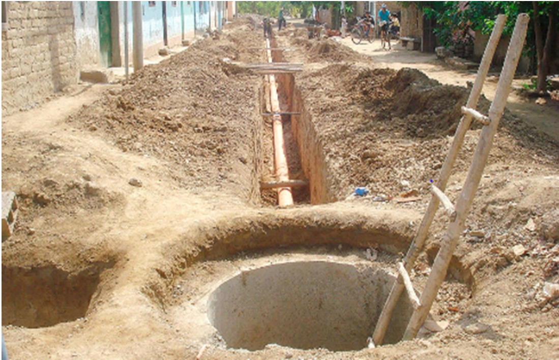
Figura 2.11: Construcción de una instalación sanitaria de desagüe.
