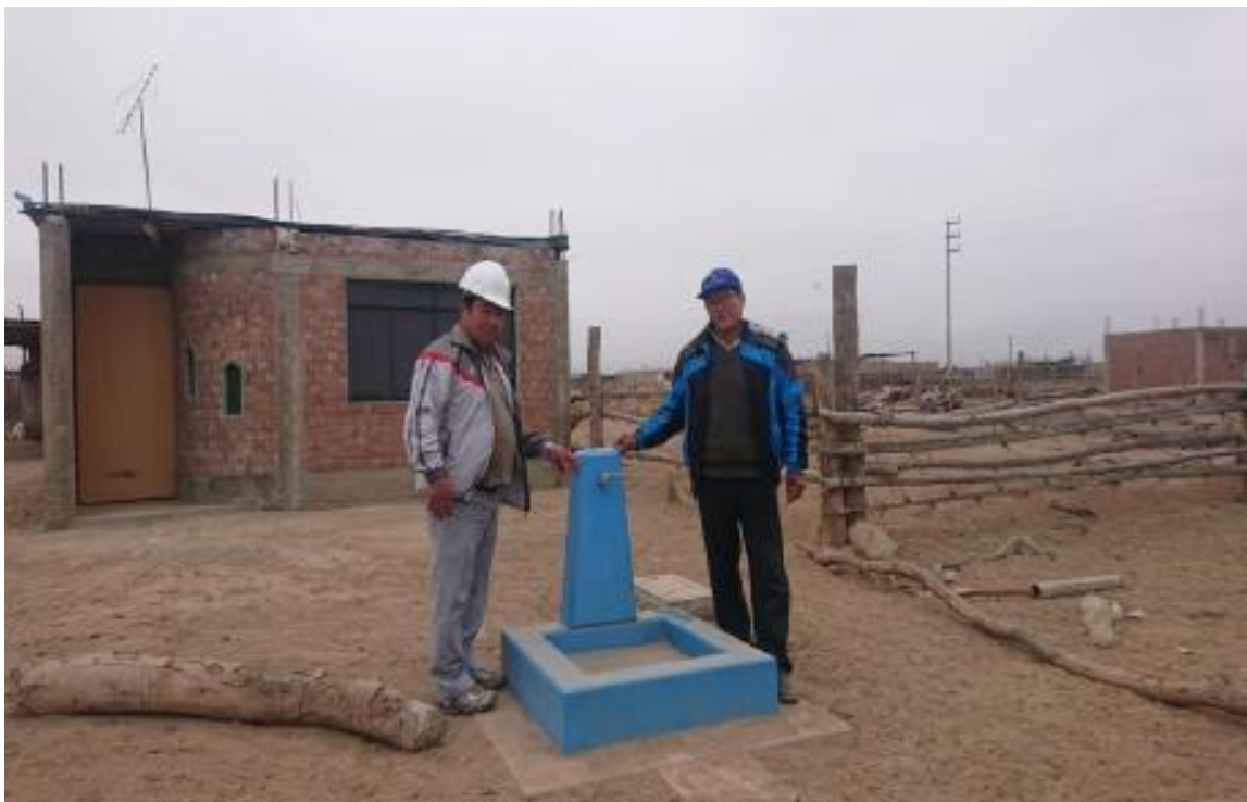
Fotografía 02: Comprobación del funcionamiento del agua en cada pilón.
