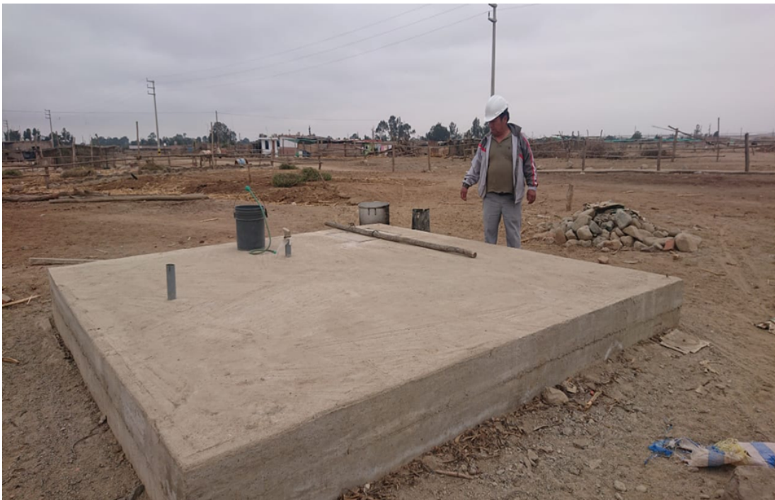
Figura 2.4: Cámara de cloración. Fuente:(Municipalidad Distrital de Grocio Prado, 2019).
