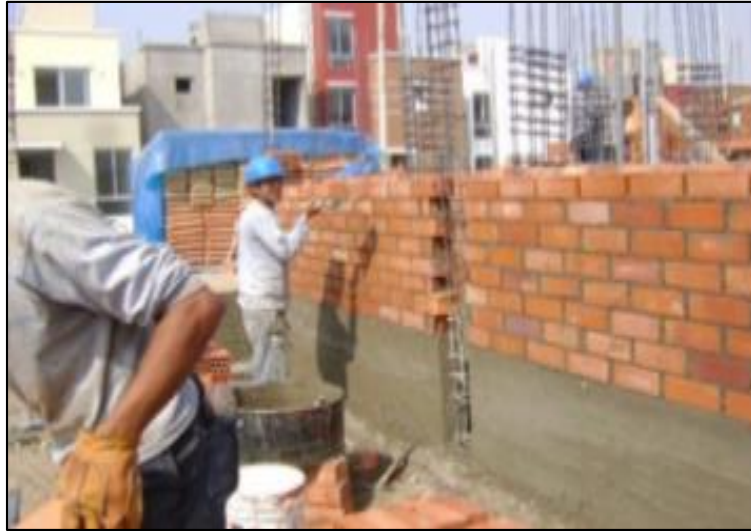
Figura 03. Construcción de una vivienda de albañilería. Nota. Fuente: ICIC (2018).
