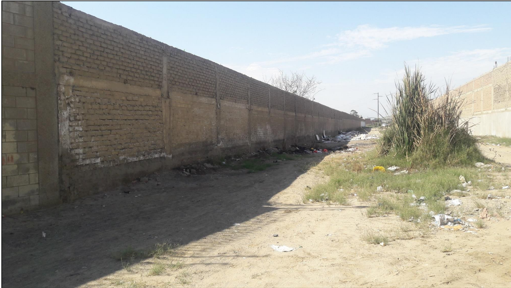
Fotografía 02. Vista del cerco de albañilería del tramo 1-2 del C.E.B.E Fé y alegría 42 del distrito de Chimbote, provincia del Santa, región Áncash.
