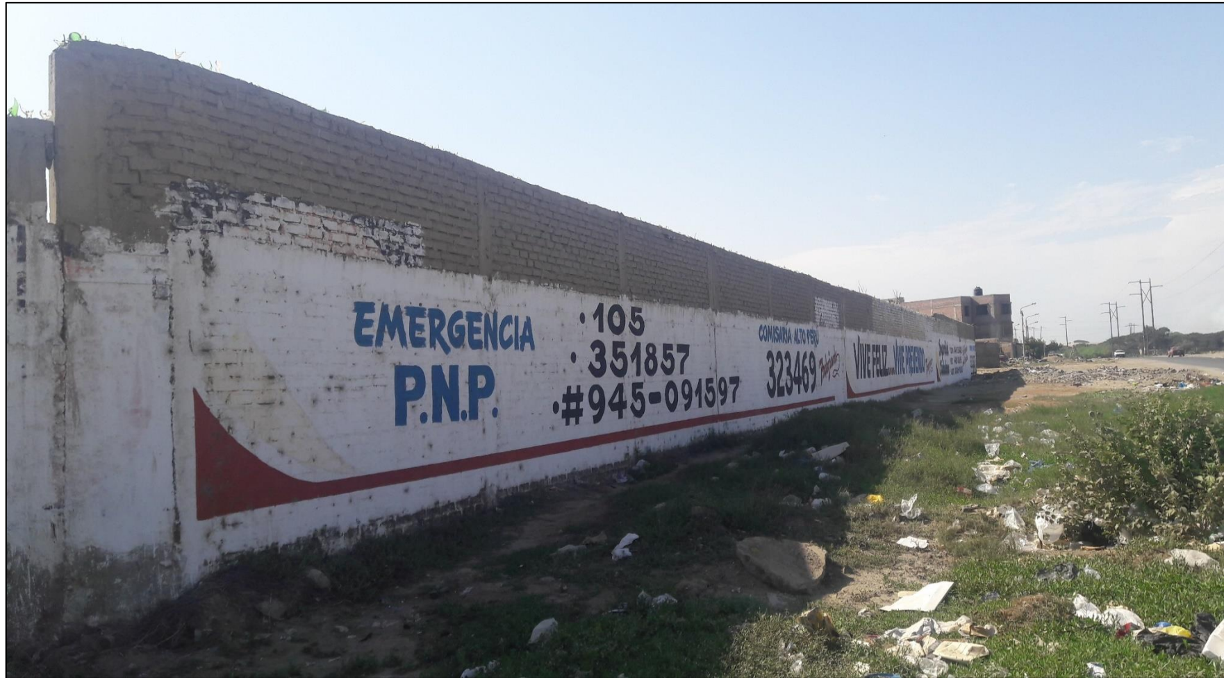
Fotografía 03. Vista del cerco de albañilería del tramo 2-3 del C.E.B.E Fé y alegría 42 del distrito de Chimbote, provincia del Santa, región Áncash.
