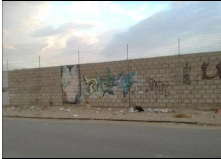
Figura 07. Albañilería armada de un cerco perimétrico. Nota. Fuente: Silva, L. (2016).
