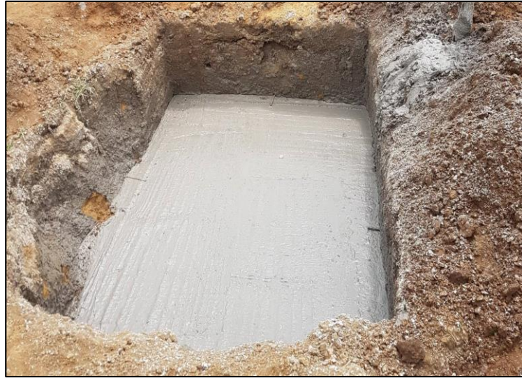
Figura 18. Concreto simple. Nota. Fuente: Elaboración propia (2019).
