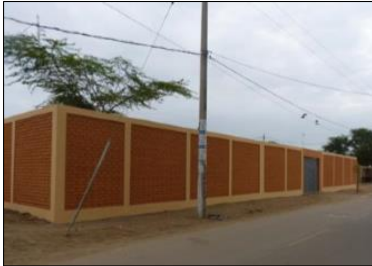
Figura 02. Vista Panorámica de Cerco perimétrico de albañilería confinada.
