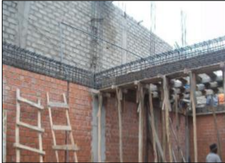
Figura 10. Viga de concreto armado en albañilería confinada.
