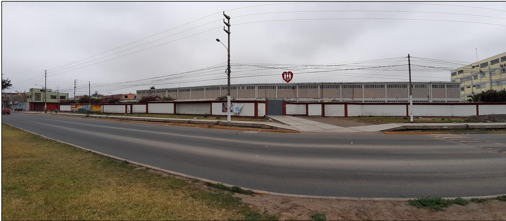
Fotografía 01. Vista de fachada del cerco de albañilería del C.E.B.E Fé y alegría 42 del distrito de Chimbote, provincia del Santa, región Áncash.
