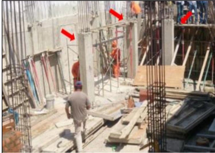
Figura 09. Columnas de concreto armado. Nota. Fuente: Marchena, J. (2018).
