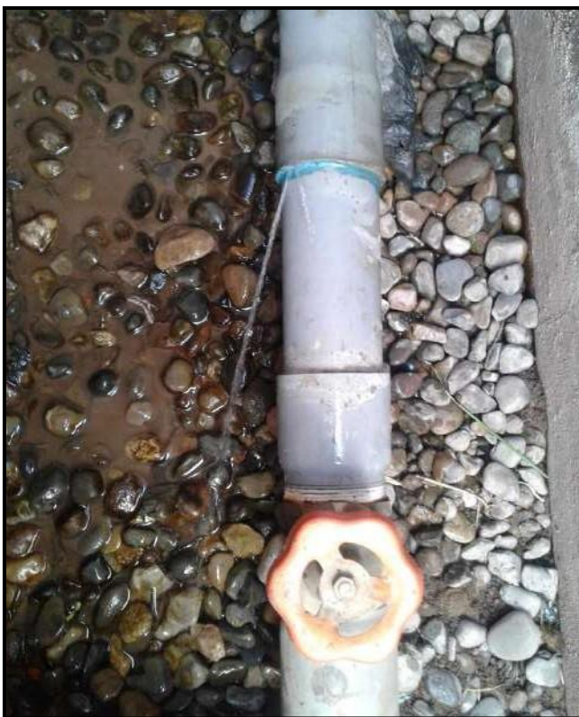
Figura 30: Fuga en válvulas de reservorio de almacenamiento
