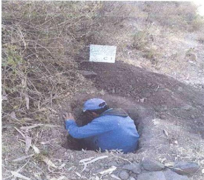
Foto N° 01.- En la toma se aprecia una vista panorámica del lugar donde se excavo la Calicata C-01.
