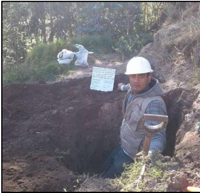
Figura 29: Excavación de calicata diseño de reservorio
