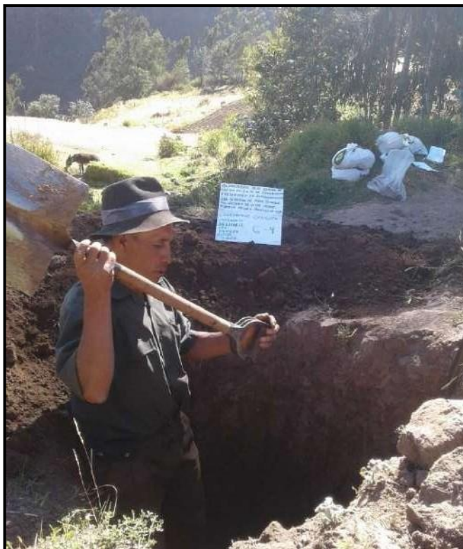
Figura 28: excavación de calicata línea de conducción
