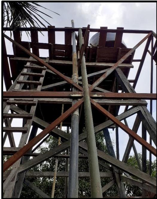
Se muestra la caseta de seguridad en precarias condiciones y no existe una tubería de limpieza adecuada ni tiene caja de válvula de control
