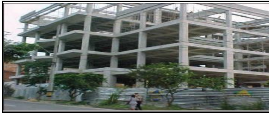
Figura 6: Sistema de construcción de albañilería aporticada.
