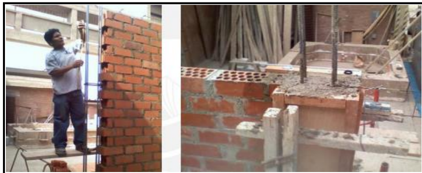
Figura 5: Sistema de construcción de albañilería confinada.
