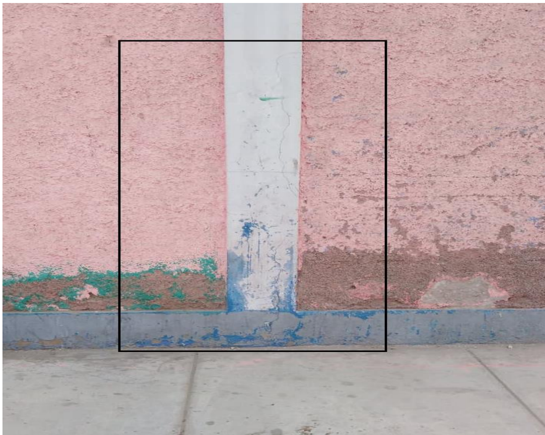
Fotografía 9: Patología Grieta en columna en la Unidad de Muestra 13
