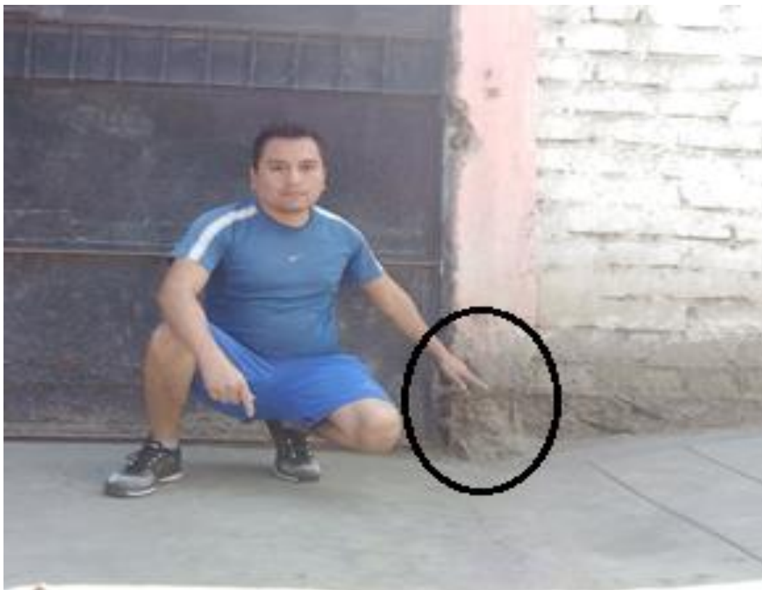
Fotografía 13: Patología Eflorescencia en columnas, muros y sobrecimientos en la Unidad de Muestra 4
