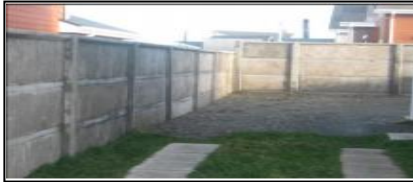
Figura 1: Cerco perimétrico de albañilería.
