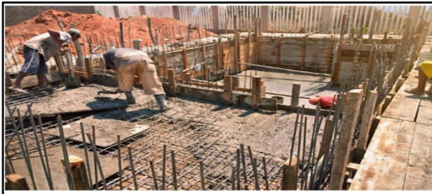
Figura 3: Vaciado de concreto armado en losa aligerada.
