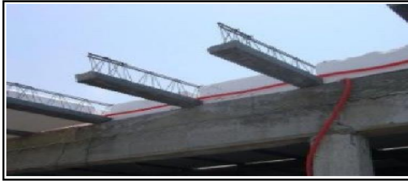
Figura 9: Viga de confinamiento
