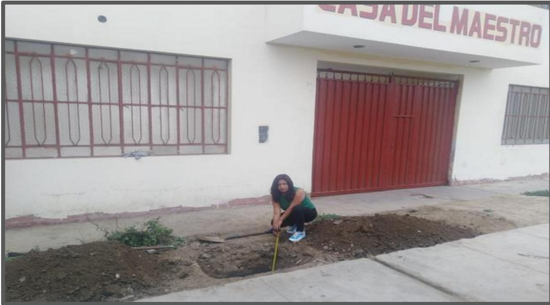
**Foto 17:** Excavación de calicata 1.50m x 1.50m.
