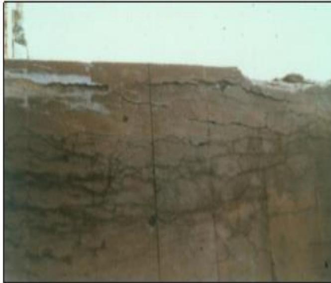
**Gráfico 13:** Delaminación en muro.
