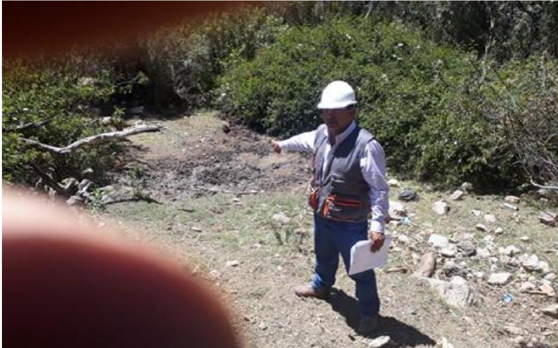
Fotografía 03: Tanque del UBS “colapsado” por inadecuada instalación (3570 msnm).
