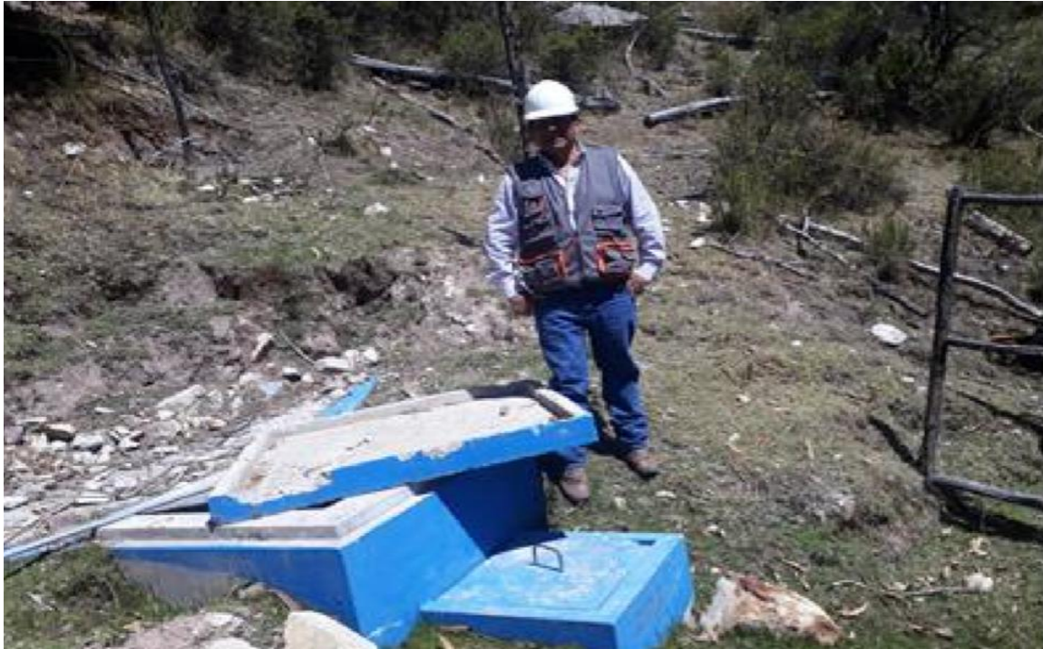
Fotografía 01: Vista de la captación N° 02 (3794 msnm).
