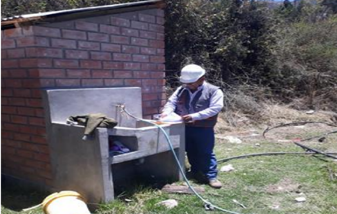
Figura 2.8: Conexiones domiciliarias de agua potable.
