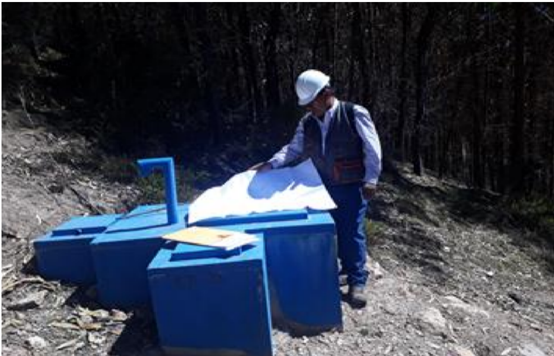
Figura 2.6: Cámara rompe presión tipo 6.
