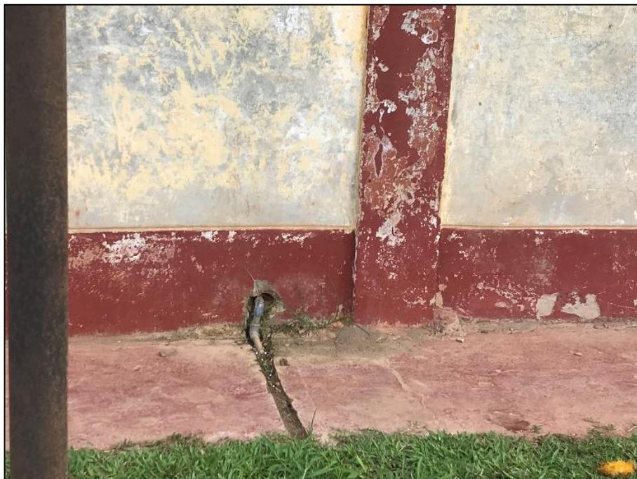
**Imagen N° 04:** Se puede observar el estado actual de las conexiones domiciliarias.
