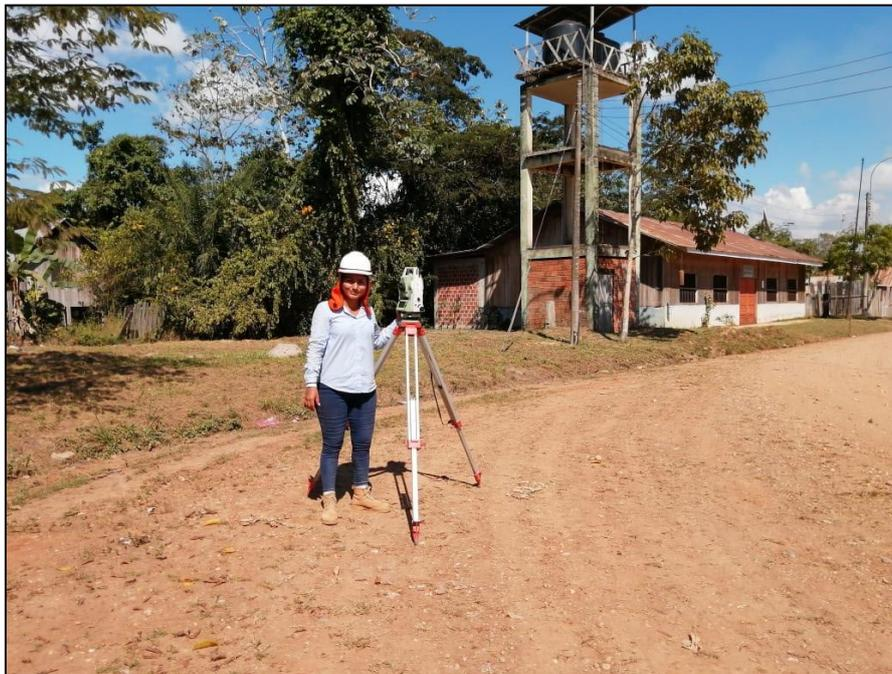
**Imagen N° 02:** Se ve en esta imagen que realizo el levantamiento topográfico para verificar los niveles y cotas de terreno de la ubicación de las redes de agua potable existentes.
