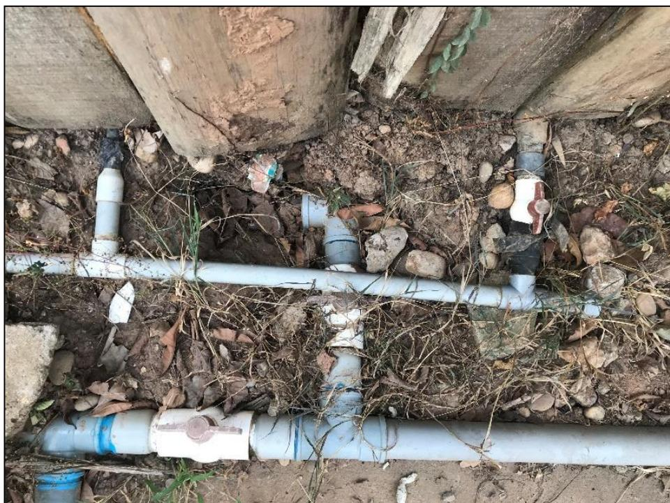
**Imagen N° 09:** Como se puede ver las redes domiciliarias se encuentran en desorden por los cruces de tuberías y la intemperie de las redes ocasionando problemas de filtración y otros problemas futuros.
