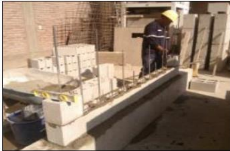
Gráfico 10: Imagen Construcción Albañilería Armada.
