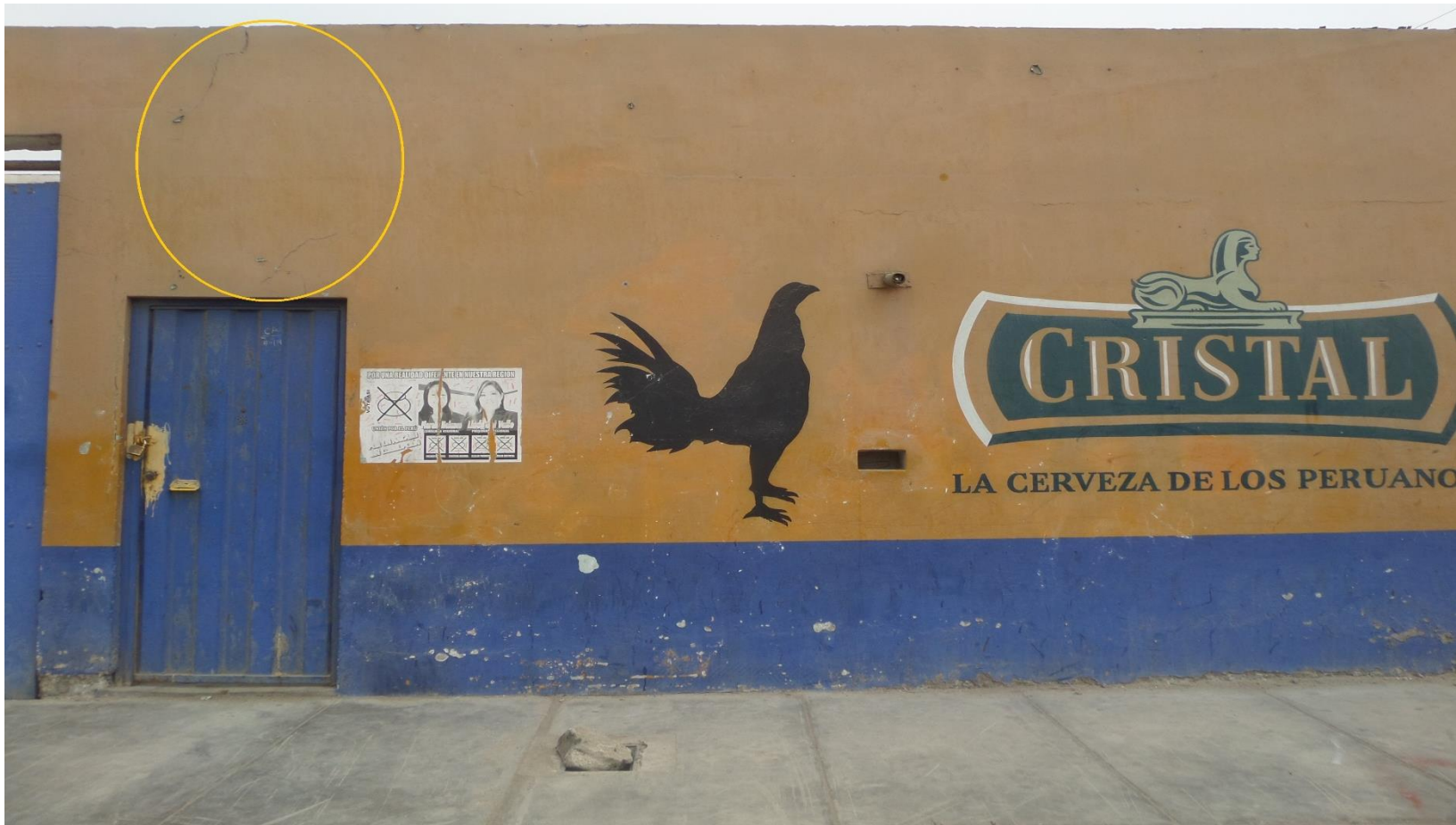
Fotografía 04: Patología Fisuras en Columnas.
