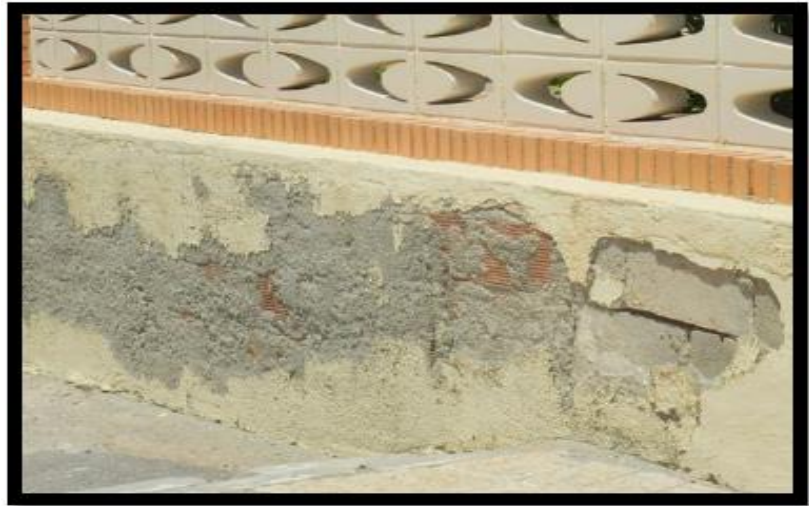
Gráfico 24: Imagen de erosión mecánica
