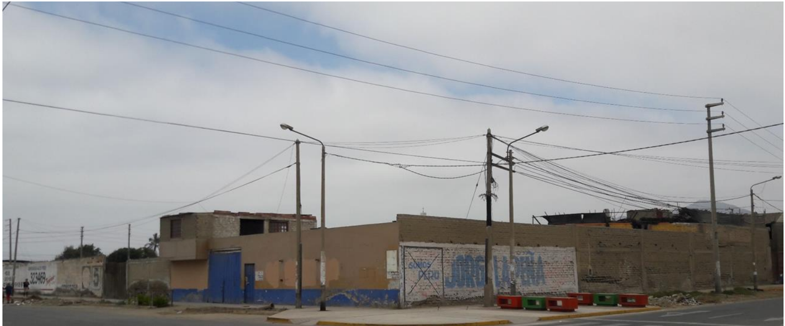
Fotografía 01: Vista Panorámica exterior del cerco del coliseo de Gallos el Portón.
