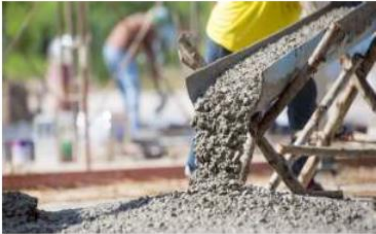
Gráfico 16: Imagen Puesta del Concreto de Mixer en una Construcción.
