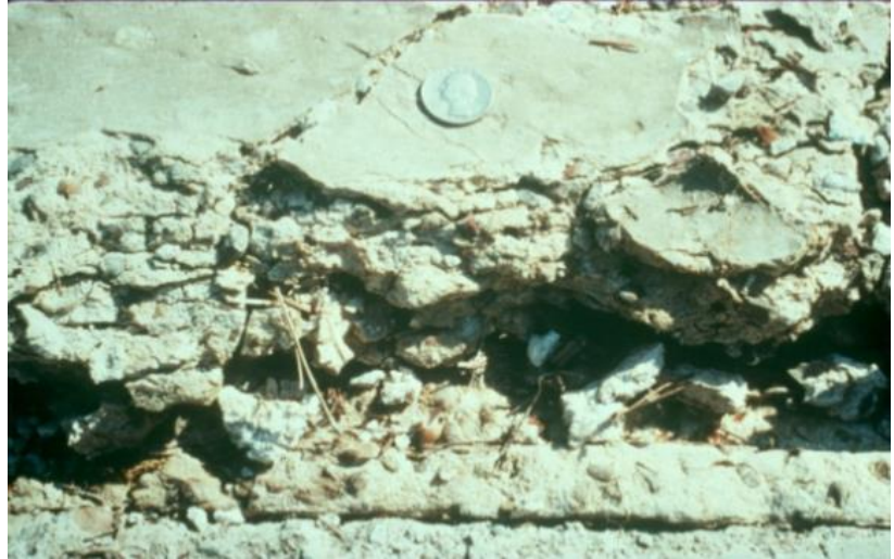
Gráfico 25: Imagen de desintegración.
