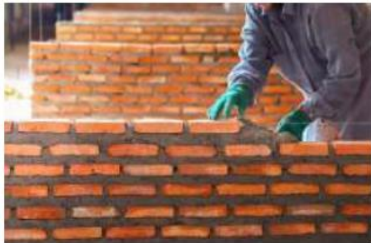
Gráfico 9: Imagen Construcción de Muro de Albañilería Simple.
