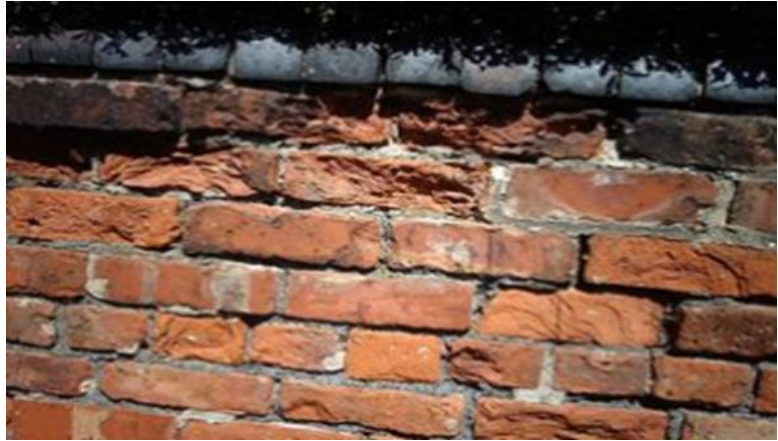
Gráfico 20: Imagen Erosión en muro.
