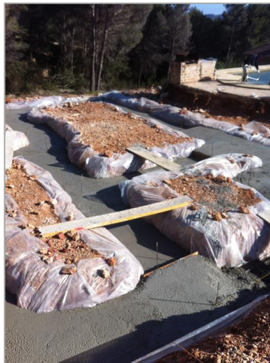
Gráfico 21. Fotografía de vaciado de cimentación con aislamiento Fuente: CHOLBI contruccions (2015)
