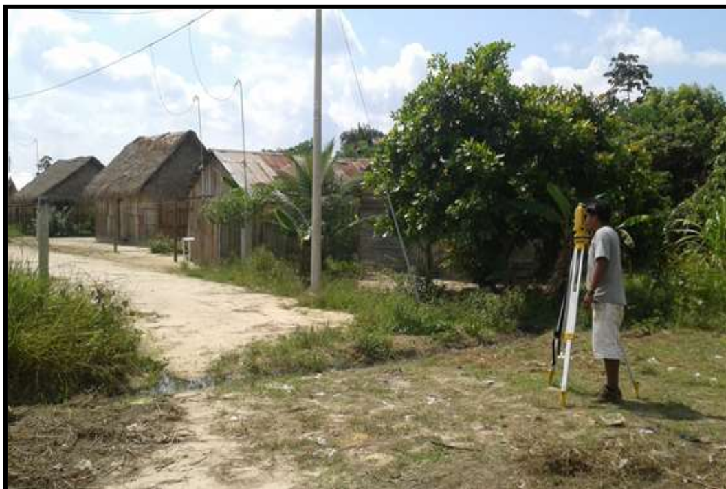
Figura N°30: Fotos Realizando la Topografía.
