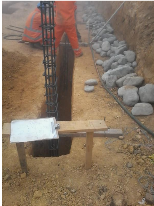
Gráfico 12: Concreto ciclópeo. Fuente: Elaboración propia.
