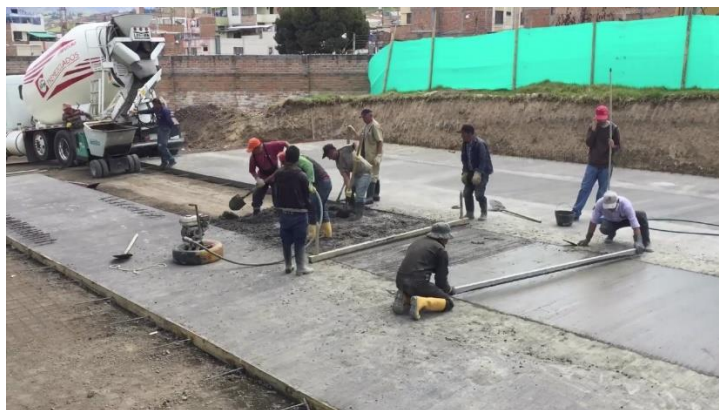
Gráfico 13: Pavimento en concreto simple. Fuente: Elaboración propia.
