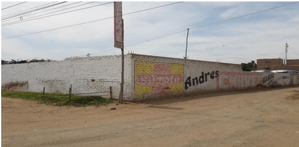
Foto 02: Esquina del lado derecho del cerco perimétrico de la estación de vehículos de transporte interprovincial.
