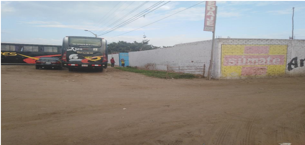
Foto 01: Vista panorámica de la fachada del cerco perimétrico del centro de salud Puente Chao.
