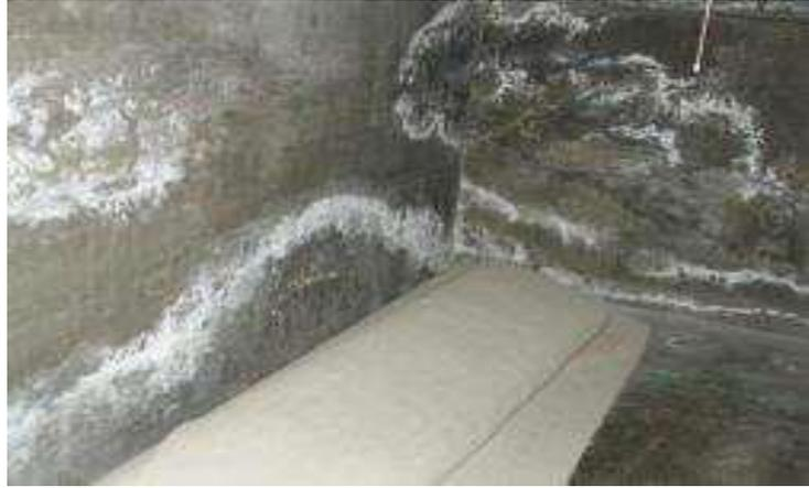
Figura 16. Eflorescencia en las paredes.
