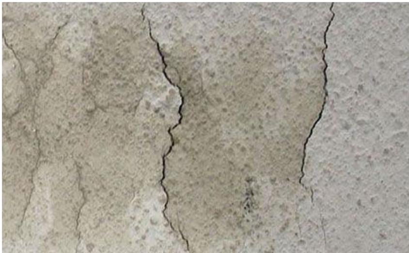
Figura 09. Fisuras en muros
