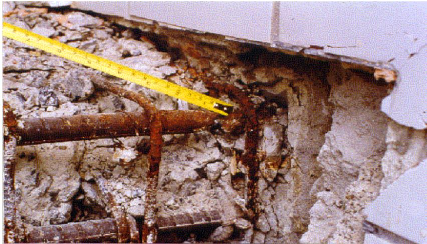
Figura 14. Corrosión
