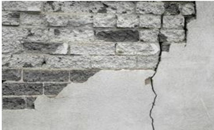
Figura 10. Grieta en muros
