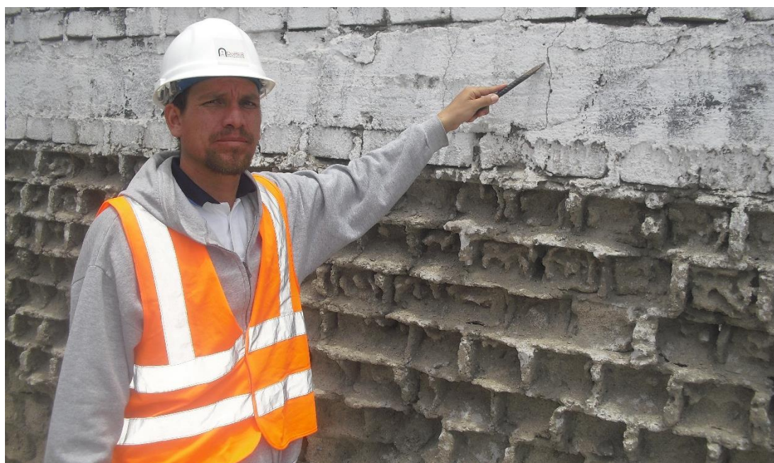
Figura 19: Se aprecia la patología de fisura en el elemento de viga de la unidad de muestra 06
