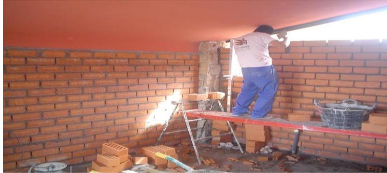
Figura 1. Estructura de Albañilería Confinada
