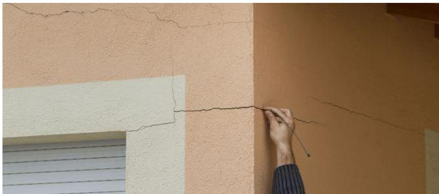
Figura 19. Fisura en muro de albañilería
