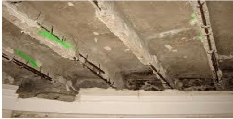
Figura 16. Viguetas con corrosión
