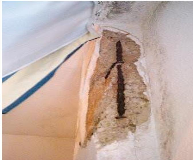
Figura 15. Corrosión en columna
