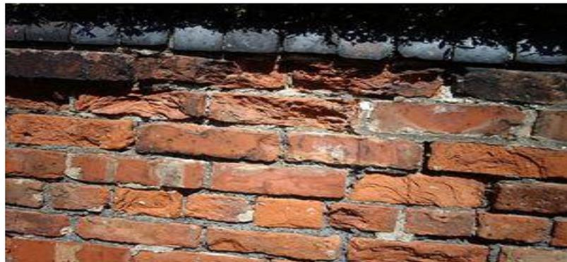
Figura 18. Erosión en muros de albañilería
