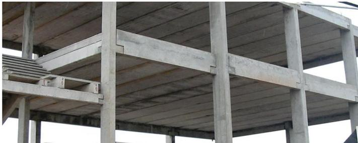
Figura 6. Columnas de concreto armado
