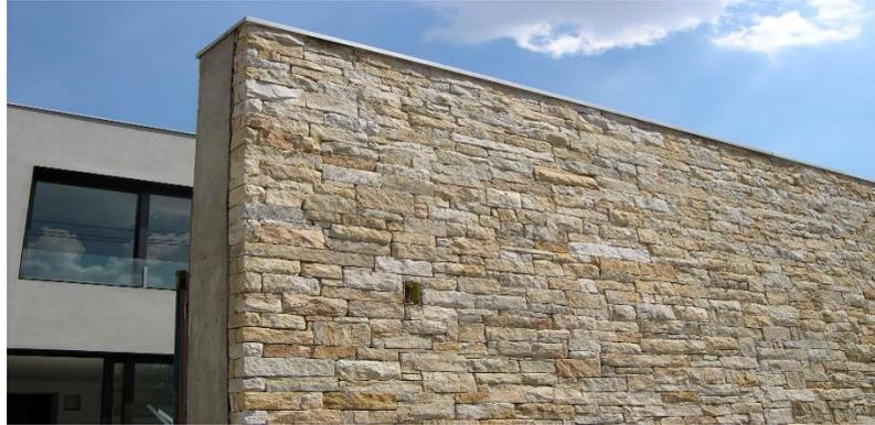
Figura 11. Muro no portante
