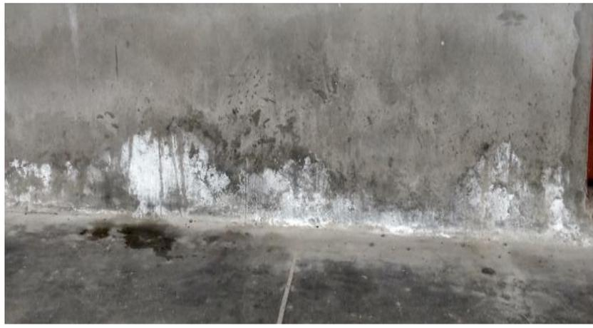
Figura 20. Eflorescencia en muros
