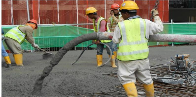
Figura 14. Vaciado de concreto
