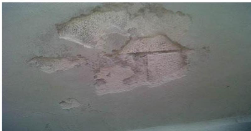
Figura 22. Desprendimiento en muro confinado
