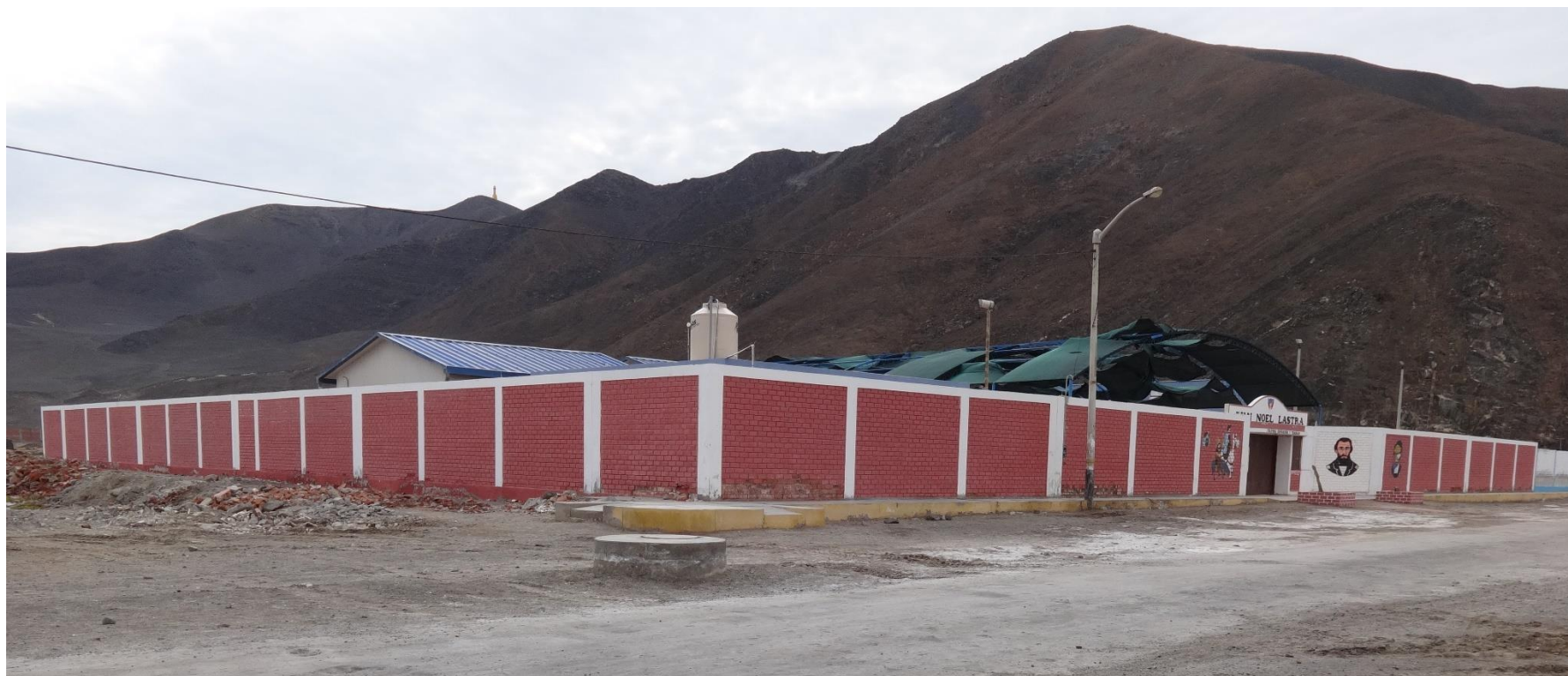
Figura 25. Fotografía del tramo 1 y 2 del cerco de la institución educativa Juan Noel Lastra.
