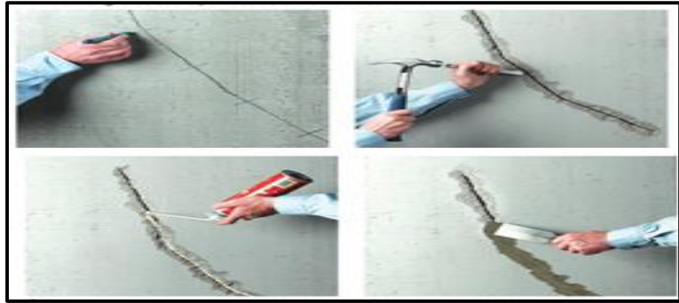
Figura 15. Imagen de reparación de fisuras en muros.
