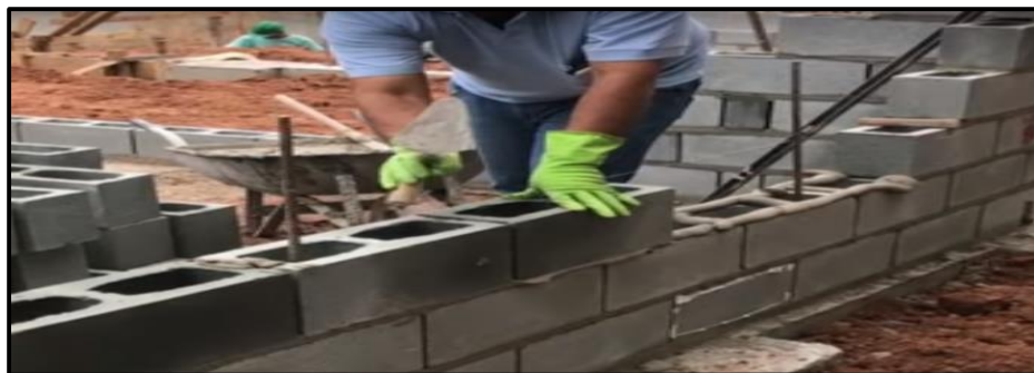
Figura 2. Imagen de muro de albañilería armada.
