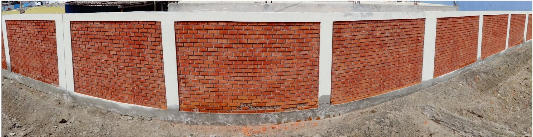
Figura 26. Fotografía del tramo 3 del cerco de la institución educativa Juan Noel Lastra.
