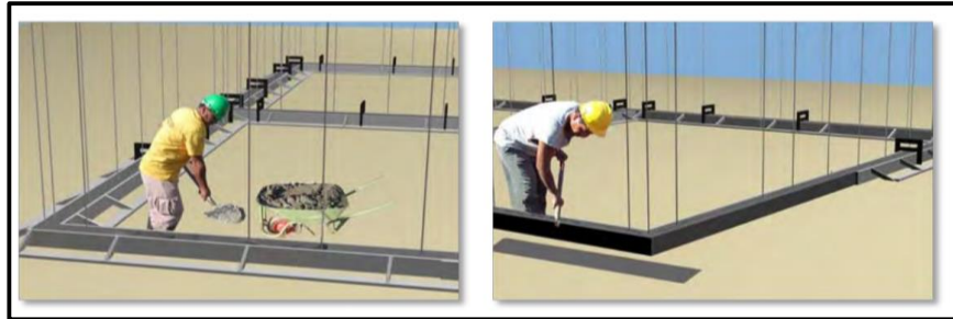
Figura 8. Imagen de sobrecimiento para construcción de albañilería armada.
