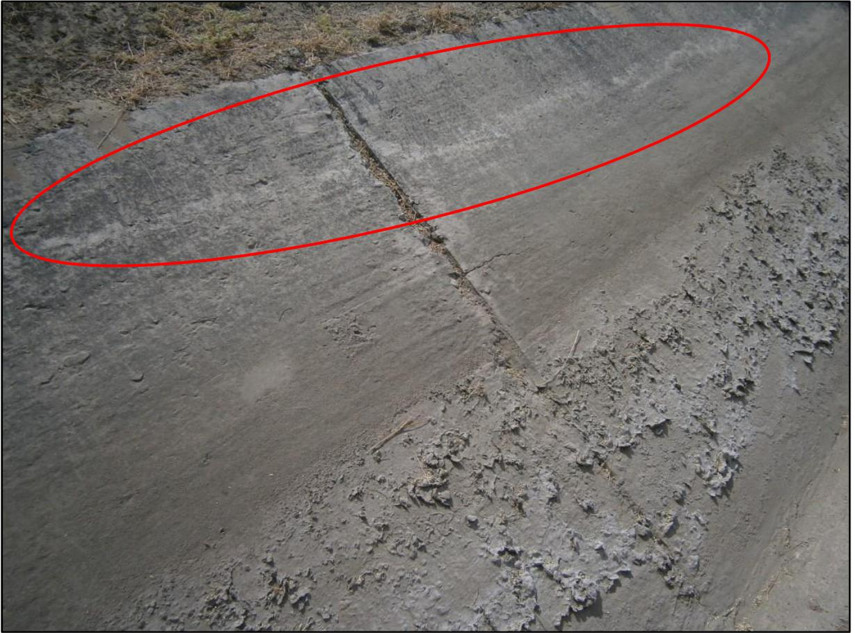
Para solucionar problemas de eflorescencia, se debe picar la zona afectada retirando los residuos, erradicando el polvo, finos y grasas, a fin de tener limpio y listo para aplicar lechada de cemento agua, para luego sellar con mortero fresco y darle el acabado, y finalmente realizar el curado respectivo
