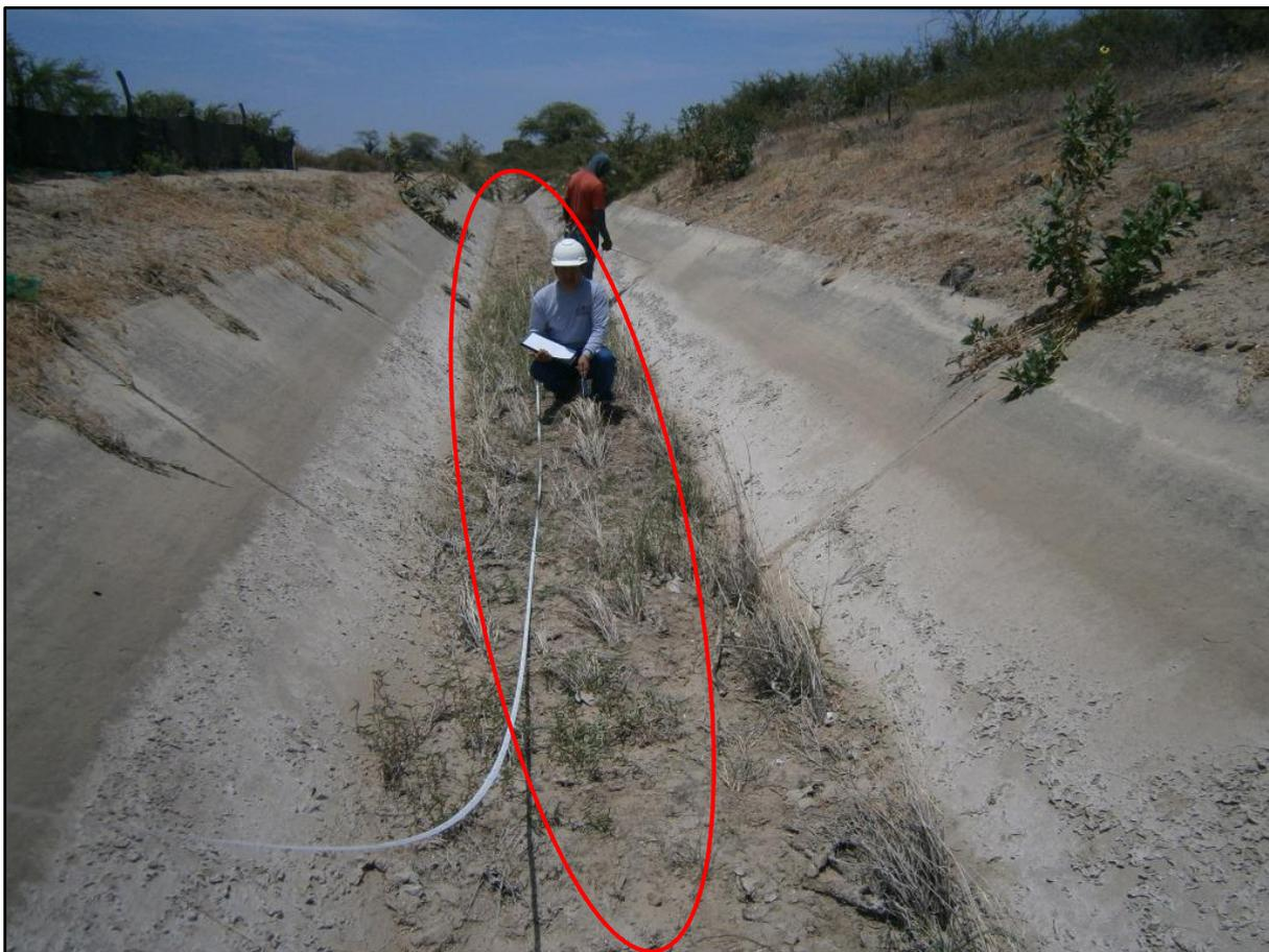
Los sedimentos son la patología con mayor presencia en el área analizada del canal, como alternativa de solución, se debe limpiar y erradicar con palanas, y su mantenimiento se debe realizar durante los periodos de corte de agua, se recomienda realizar este trabajo de limpieza cada vez que sea necesario para asegurar la óptima eficiencia del canal de riego.
