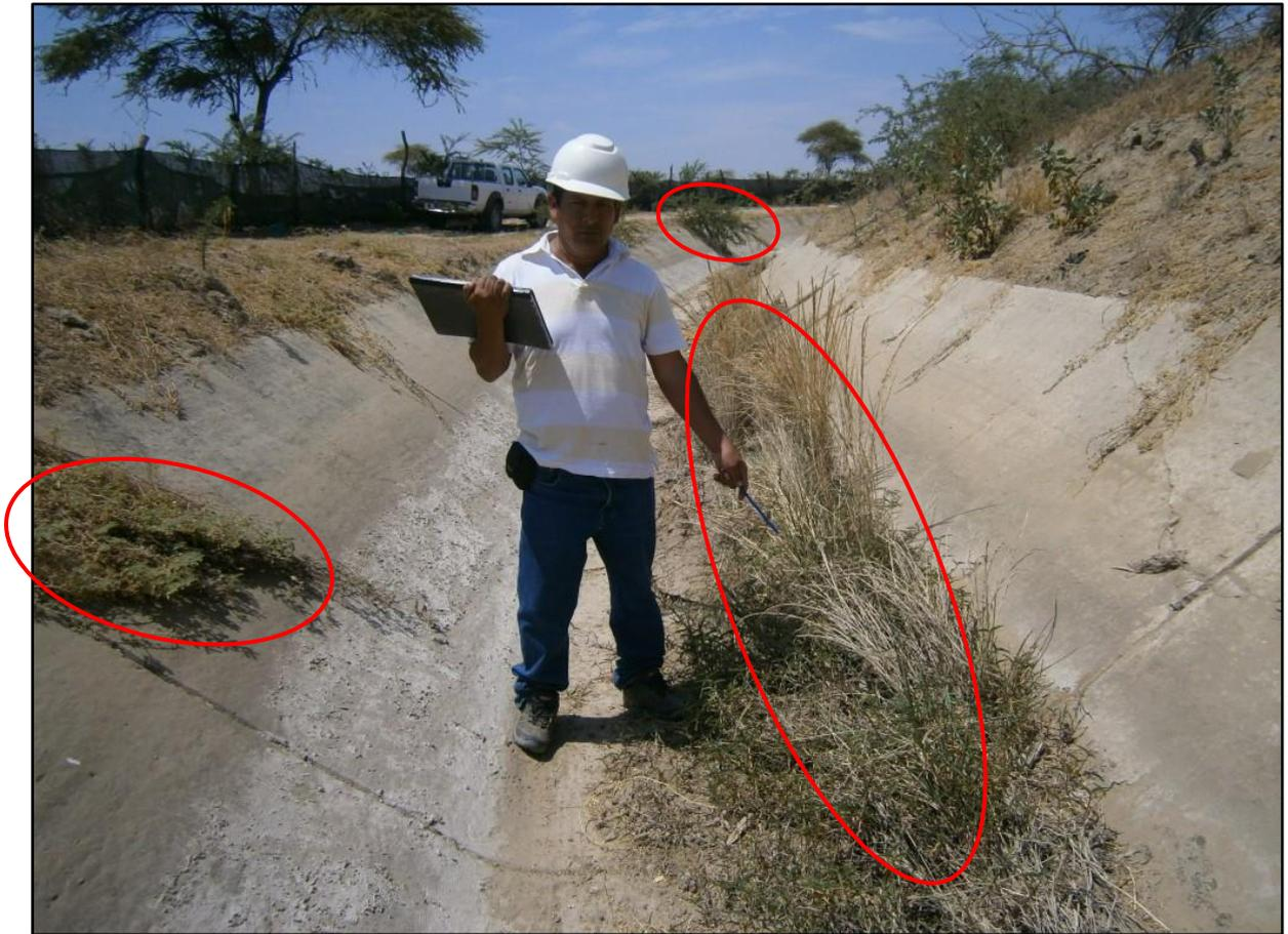
La vegetación encontrada en el canal, es de raíz corta, por lo tanto, se debe erradicar utilizando machetes y palanas, se recomienda realizar esta labor conjuntamente con la erradicación de los sedimentos.
