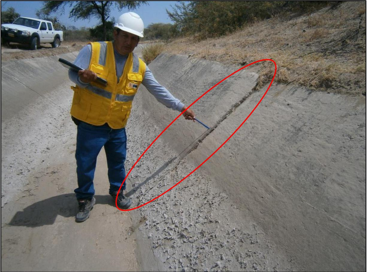
Para reparar el sello de junta se debe limpiar bien el área afectada, eliminando el polvo y la suciedad, luego se procede a sellar con mortero asfáltico (emulsión asfáltica y arena) preparado in situ, siendo de fácil aplicación, bajo costo y óptimos resultados, a comparación del sellado con productos elastoméricos que tienen muy buenos resultados, fácil aplicación, pero costo más elevado.
