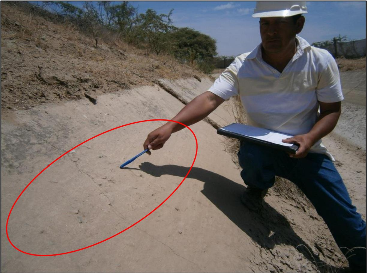
Para solucionar problemas de descascaramiento de concreto, se procede a reparar picando, limpiando y humedeciendo la zona afectada, luego se aplica la lechada de cemento – agua, se aplica el mortero, se da el acabado y finalmente se aplica el curado químico.
