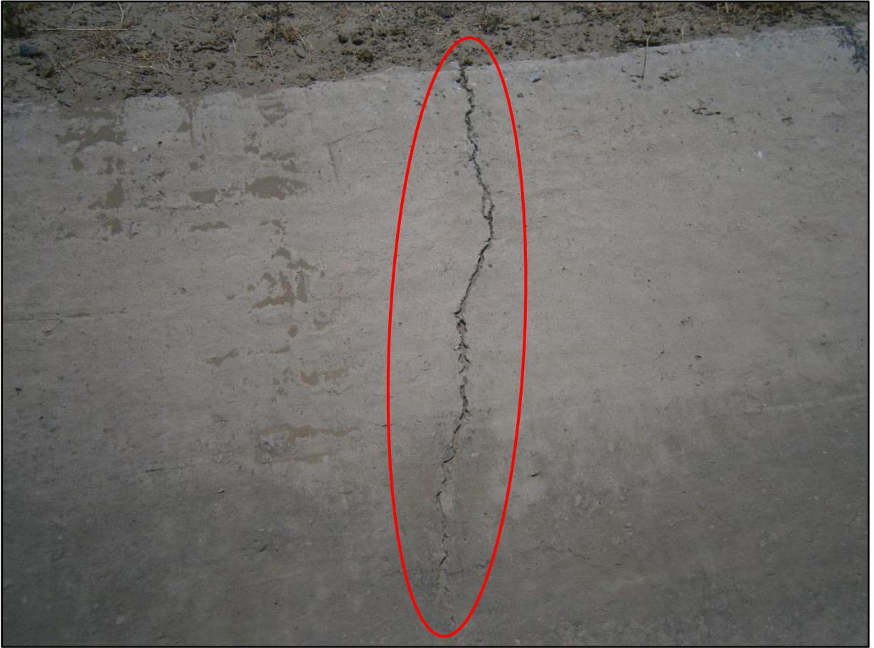
Como alternativa de solución de las fisuras en concreto, se limpia la zona de impurezas, polvo y finos, lavando con agua o soplando con aire a compresión, para luego aplicar una inyección de poliuretano reactivo impermeabilizante, para finalmente sellar con mortero cemento - arena, de esta manera se evitará que el agua ingrese por la fisura provocando efecto de sub-presión.
