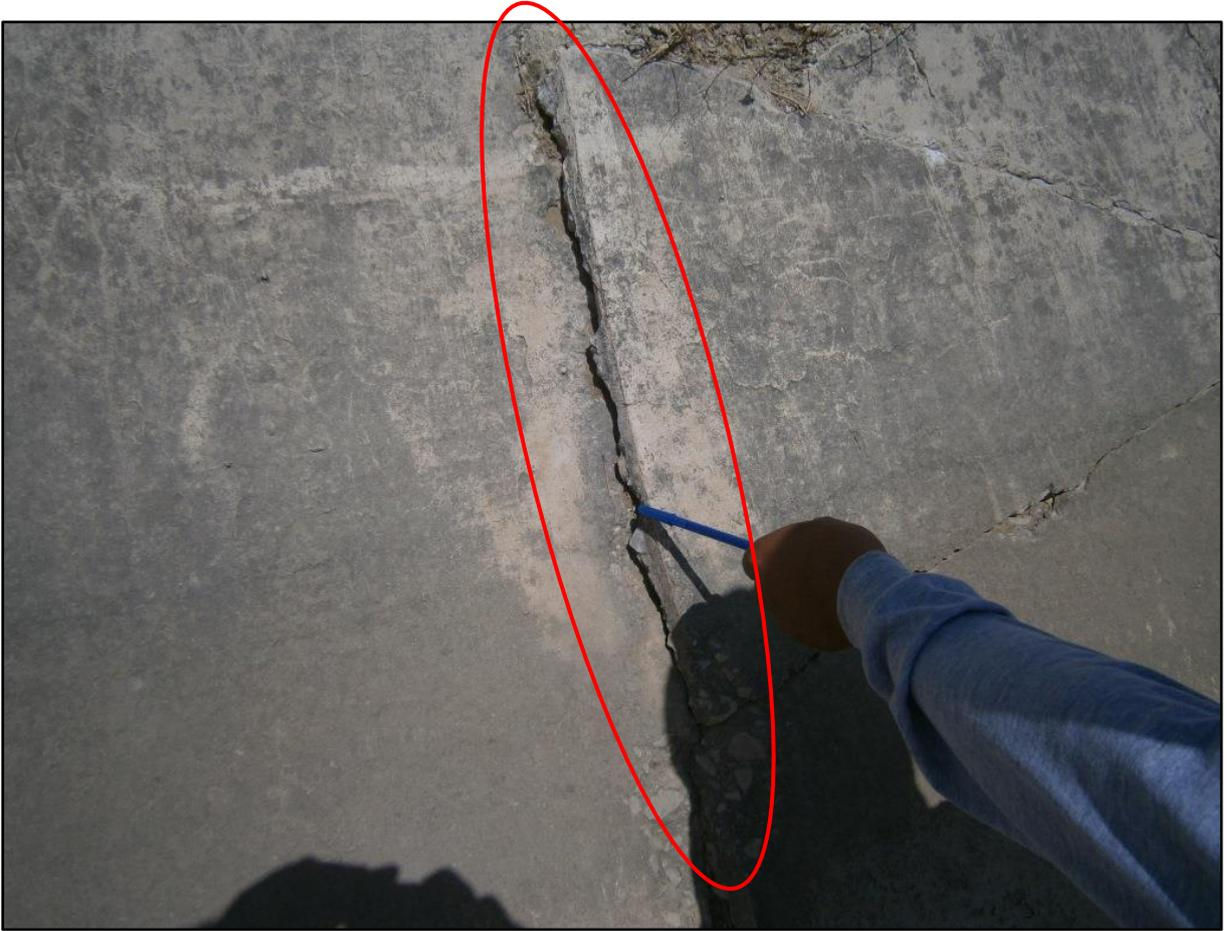
Como alternativa de solución del agrietamiento del concreto, se limpia la zona de impurezas, polvo y finos, lavando con agua o soplando con aire a compresión, para luego aplicar una inyección de poliuretano reactivo impermeabilizante, para finalmente sellar con mortero cemento - arena.
