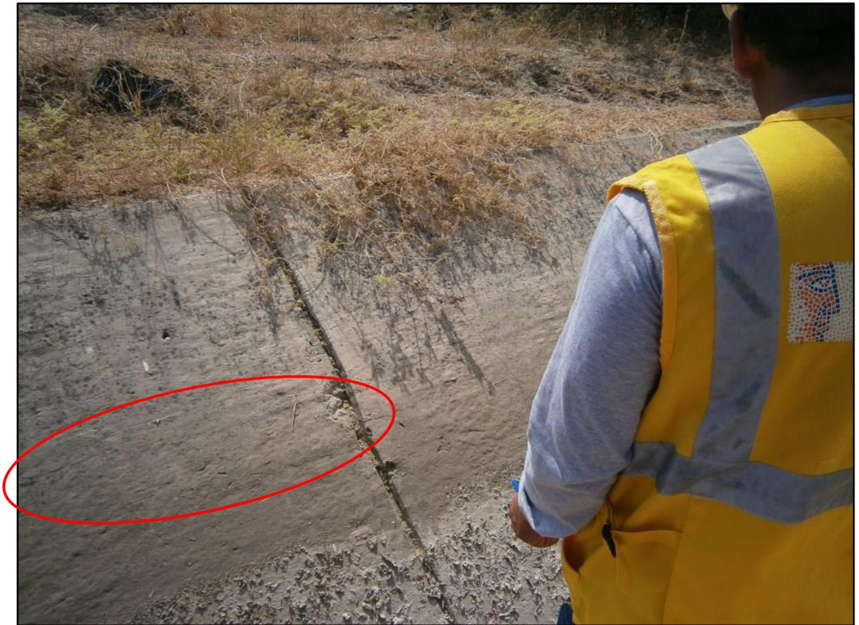
Para solucionar problemas de delaminación del concreto, se procede a reparar picando, limpiando y humedeciendo la zona afectada, luego se aplica la lechada de cemento – agua, se aplica el mortero, se da el acabado y finalmente se aplica el curado.
