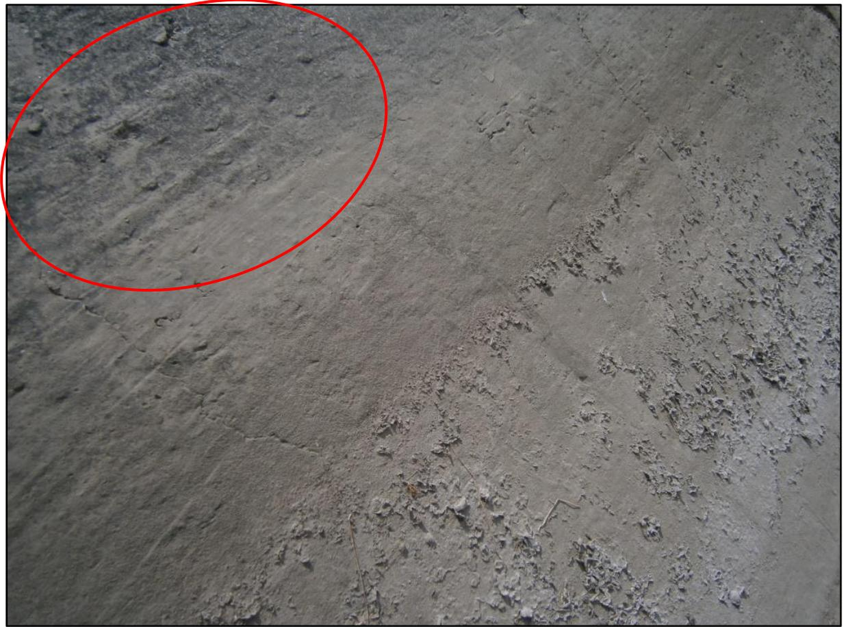
Para solucionar problemas de erosión, se procede a reparar picando, limpiando y humedeciendo la zona afectada, luego se aplica la lechada de cemento – agua, se aplica el mortero, se da el acabado y finalmente se aplica el curado químico.
