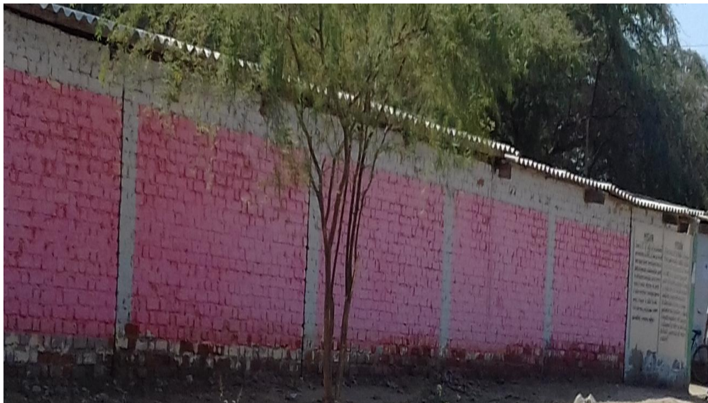
Gráfico 103: Patología de la erosión Física en unidad de muestra 17- Fuente: Elaboración propia 2016
