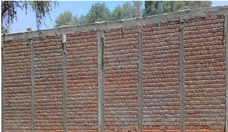
Gráfico 104: Patología de la eflorescencia en la muestra 7- Fuente: Elaboración propia 2016
