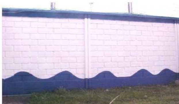
Gráfico 1: Cerco perimétrico – Fuente: Seguridad perimétrica 2
