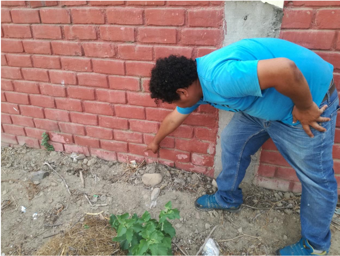
Imagen 14: Eflorescencia ubicada en la unidad de muestra 01.
