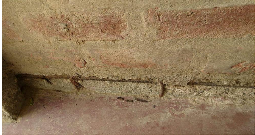
Imagen 8: Corrosión
