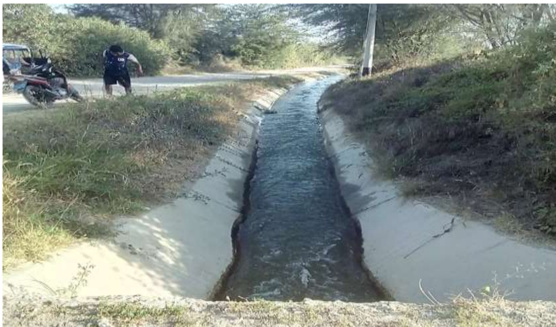
Imagen 20. Vista panorámica del Canal sub lateral 9+265.
