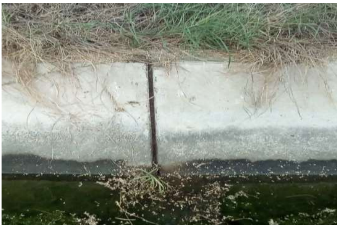
Imagen 27. Sello de juntas en canal sub lateral 9+265.
