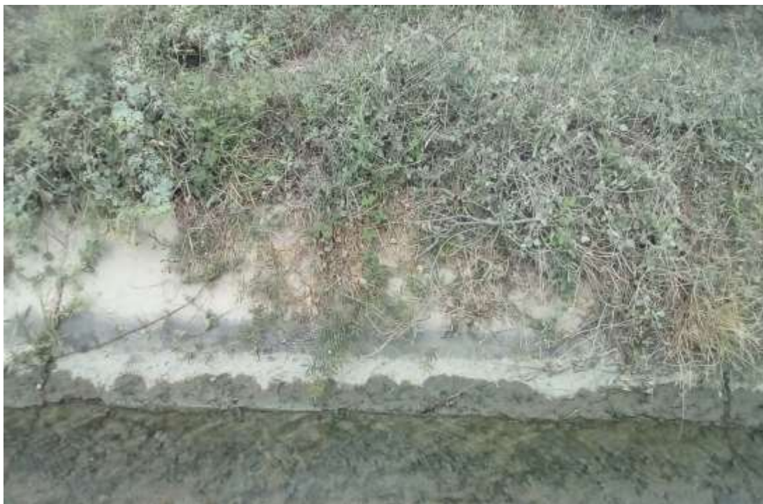
Imagen 26. Vegetación en margen derecho del canal sub lateral 9+265.
