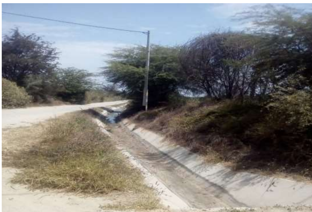
Imagen 21. Vista panorámica del Canal sub lateral 9+265.
