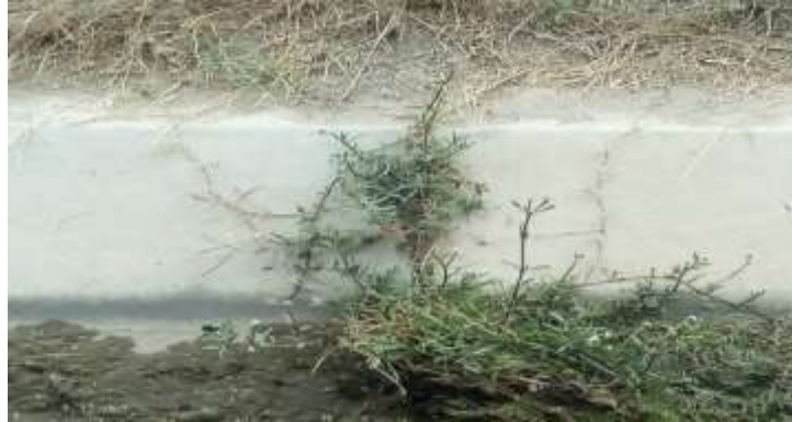
Imagen 12: Vegetación en canal de concreto.
