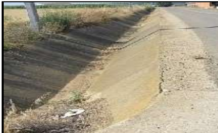
Imagen 08: Canal de sección triangular.
