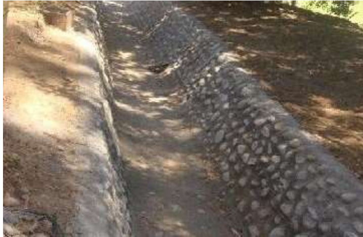
Imagen 02: Canal revestido con mampostería de piedra.
