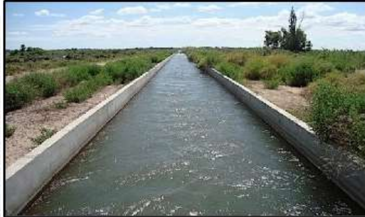
Imagen 07: Canal de sección rectangular.
