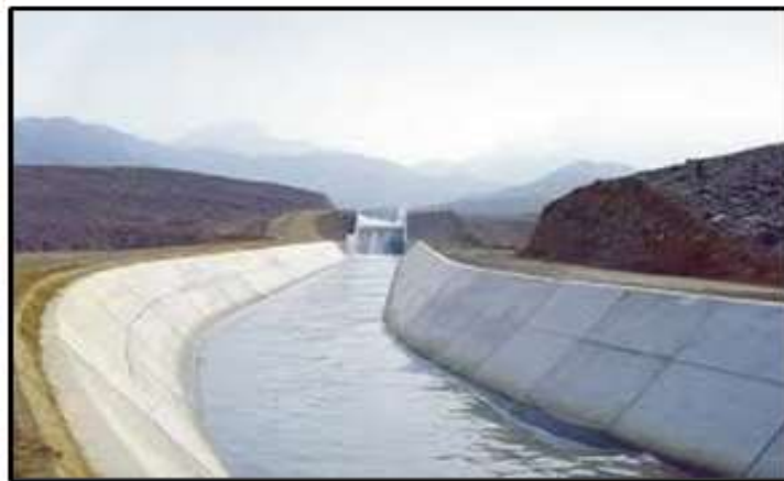
Imagen 06: Canal de sección trapezoidal.
