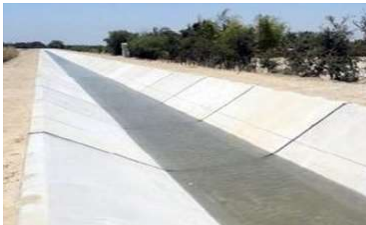
Imagen 01: Canal revestido de concreto.
