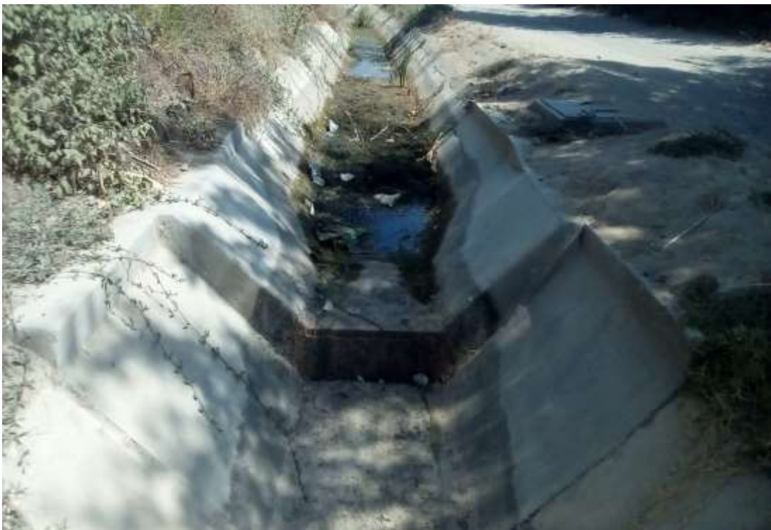
Imagen 29. Sedimentación presente en fondo del canal sub lateral 9+265
