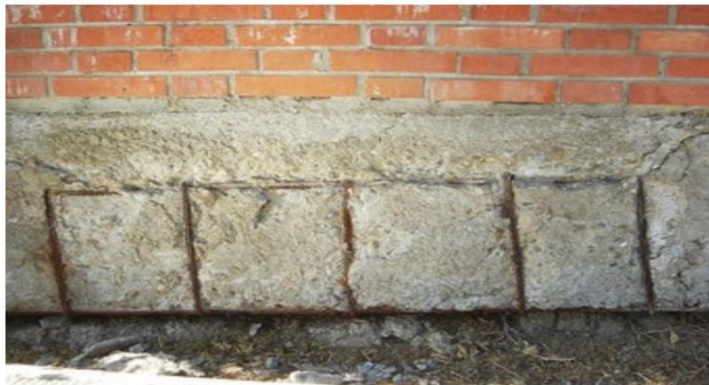
**Figura 17:** Corrosión en un muro albañilería.
