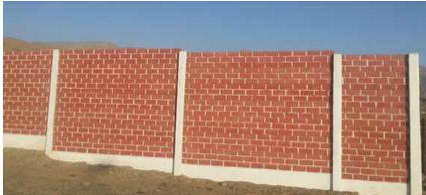
**Figura 8:** Muro no portante o tabique.
