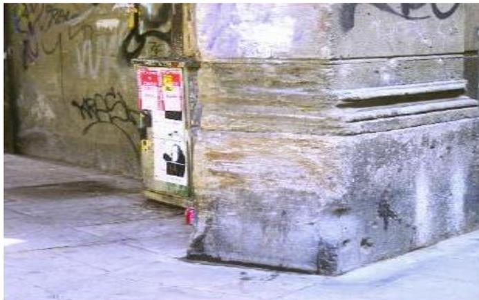
**Figura 15:** Erosión mecánica.
