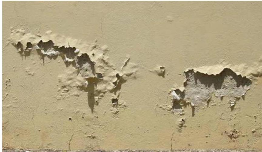
**Figura 18:** Eflorescencia en muros de Albañilería.
