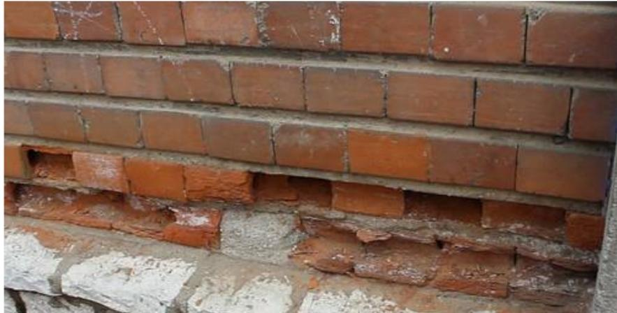
**Figura 12:** Erosión física en muro de albañilería.
