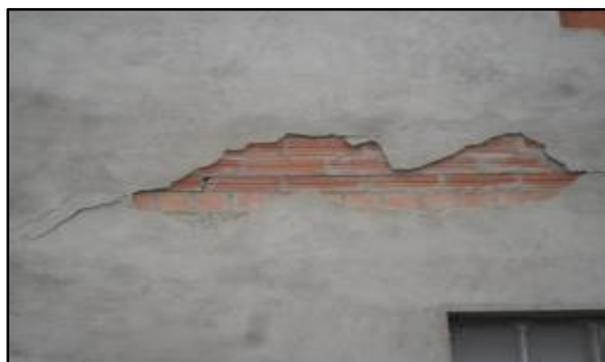
**Figura 13:** Muro de albañilería, con patología desprendimiento.
