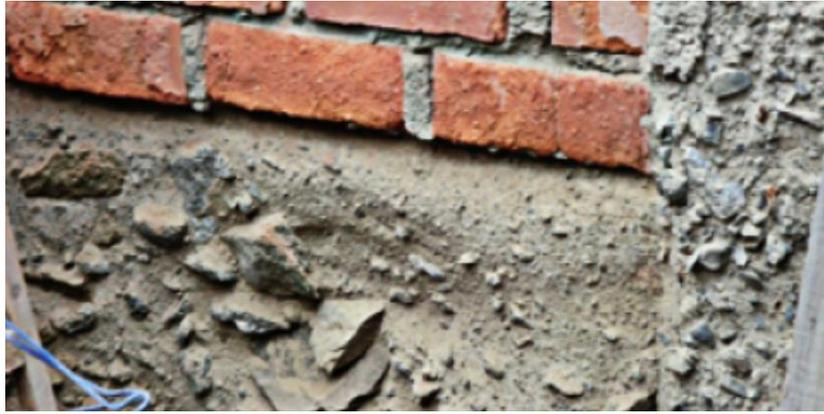
**Figura 16:** Desprendimiento en sobrecimiento, muro y viga.
