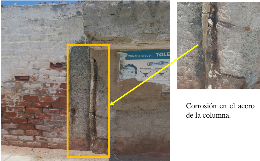
Fotografía 03: Corrosión en acero de columnas del cerco perimétrico del centro de producción ubicado en el pueblo joven Villa María.
