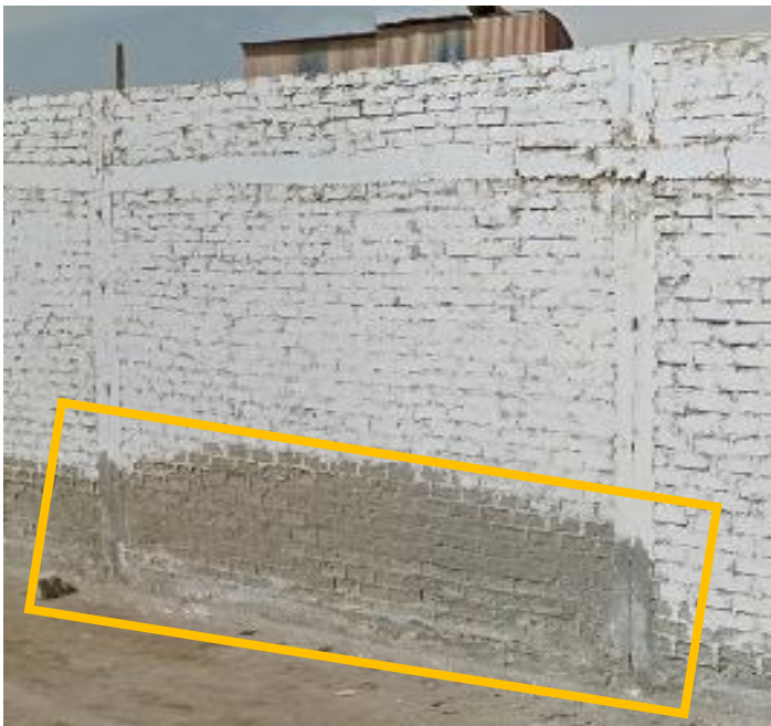
Fotografía 06: Erosión en muros y columnas en el cerco perimétrico del centro de producción ubicado en el pueblo joven Villa María.
