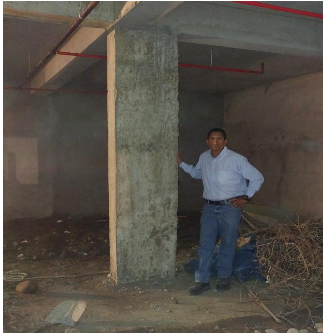
Figura 05. Columna de concreto
