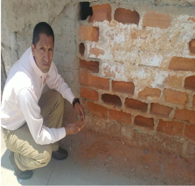
Fotografía 05: Desintegración del muro del cerco perimétrico del centro de producción ubicado en el pueblo joven Villa María.
