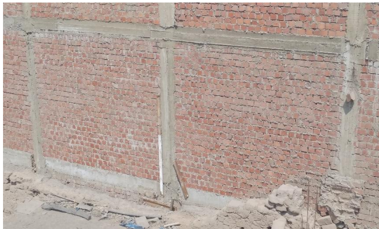
Figura 03. Estructura de albañilería confinada
