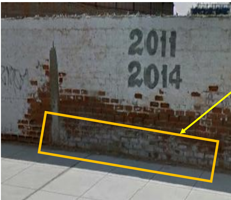
Fotografía 02: Se aprecia eflorescencia y erosión química en muros y columnas del cerco perimétrico del centro de producción ubicado en el pueblo joven Villa María.
