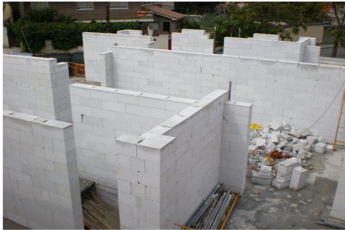
Figura 08: Muro no portante.
