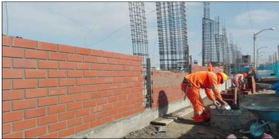
*Figura 8:* Cerco Perimétrico en Construcción.
