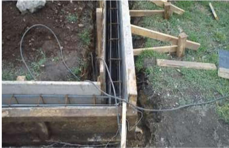
**Figura 20:** Proceso Constructivo de un Sobrecimiento.
