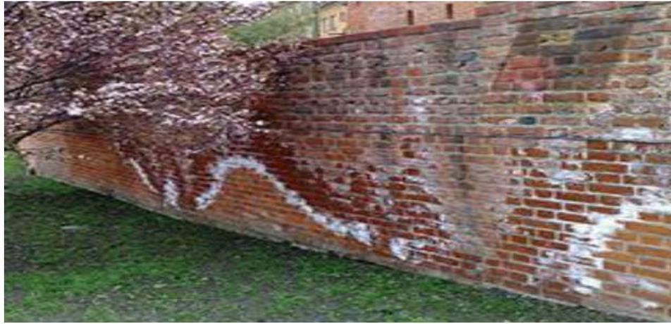
**Figura 29:** Eflorescencia presente en un Muro.
