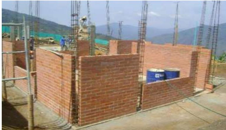
*Figura 23:* Proceso constructivo de un Muro de Albañilería.
