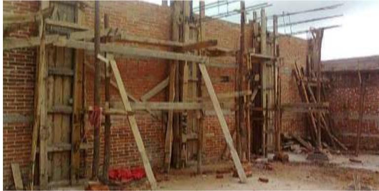
**Figura 21:** Encofrado de Columnas.
