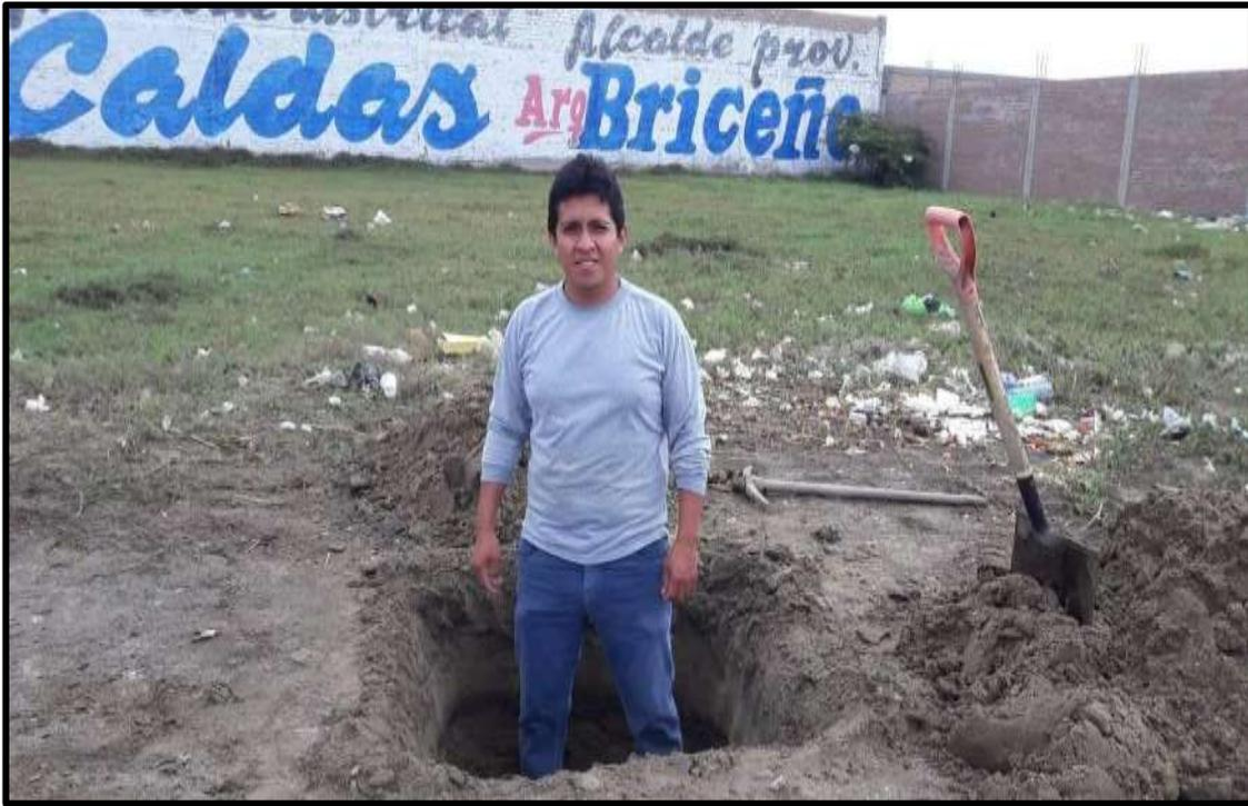
**Imagen 03:** Finalizada la excavación de la Calicata C-1 con medidas 1.20 m x 1.20 m.
