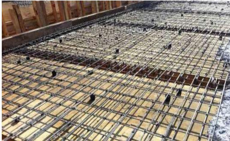
**Figura 16:** Platea de Cimentación con Acero de refuerzo.
