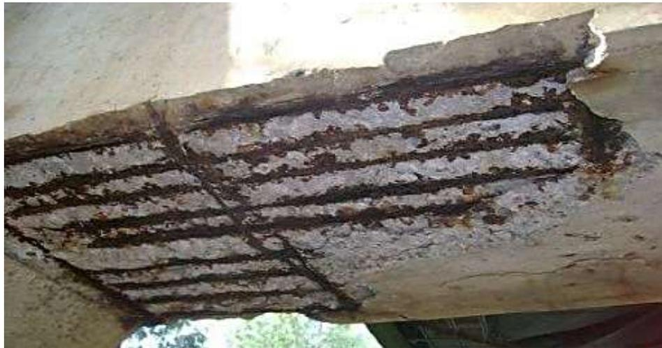
**Figura 28:** Corrosión presente en una viga.
