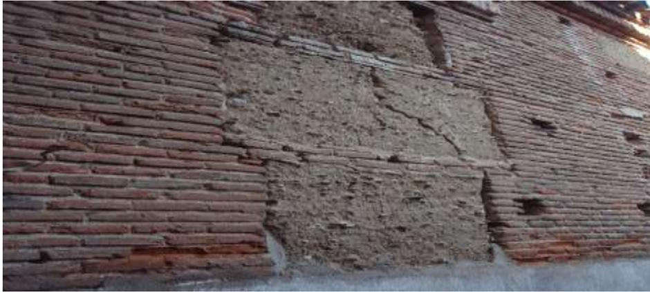
**Figura 24:** Diversas patologías en un Muro de Albañilería.
