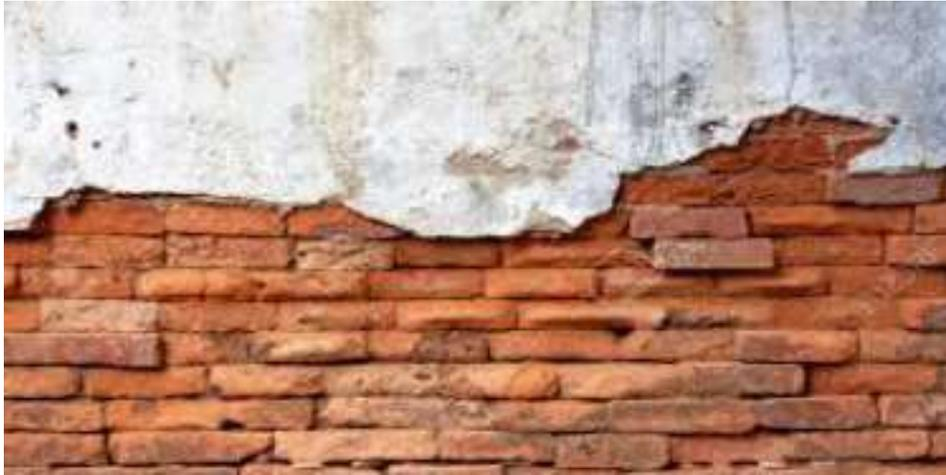
**Figura 30:** Erosión presente en un Muro.
