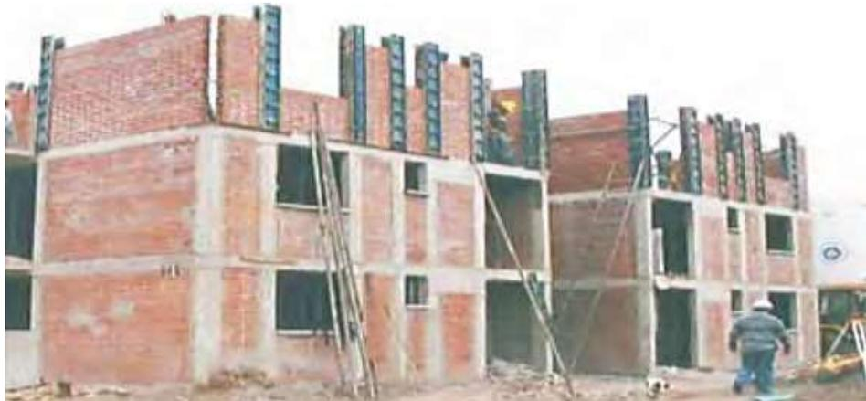
**Figura 14:** Proceso Constructivo de una vivienda de Albañilería Confinada.
