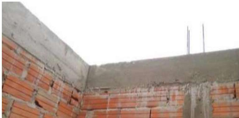
**Figura 22:** Desencofrado de Vigas Confinadas.
