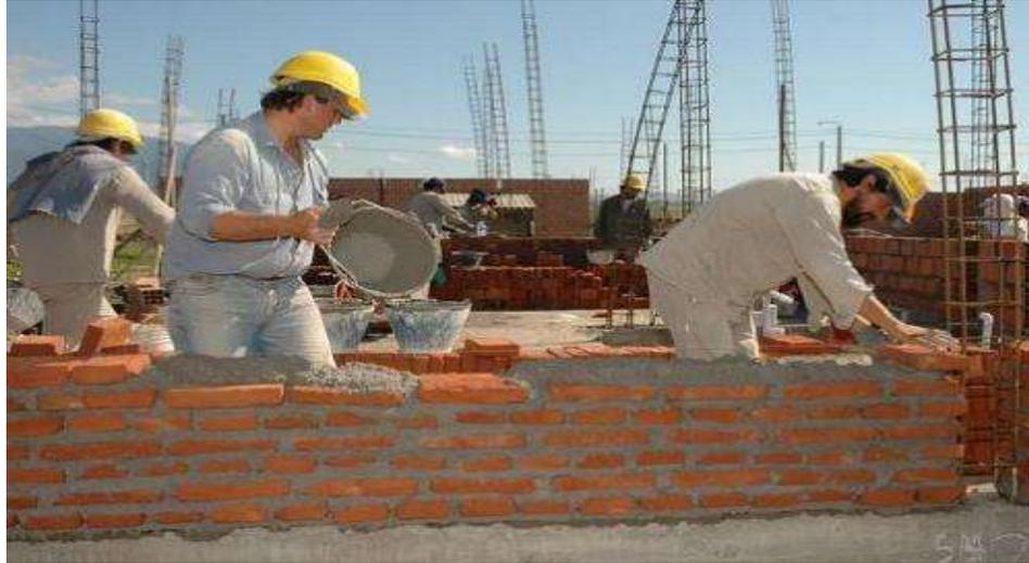
**Figura 9:** Construcción de una vivienda de albañilería en Perú.
