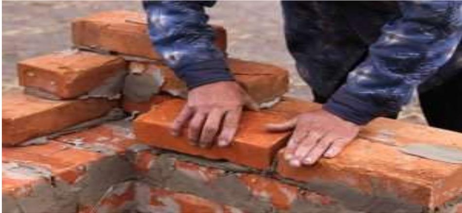
**Figura 11:** Construcción de Muro de Albañilería Simple.
