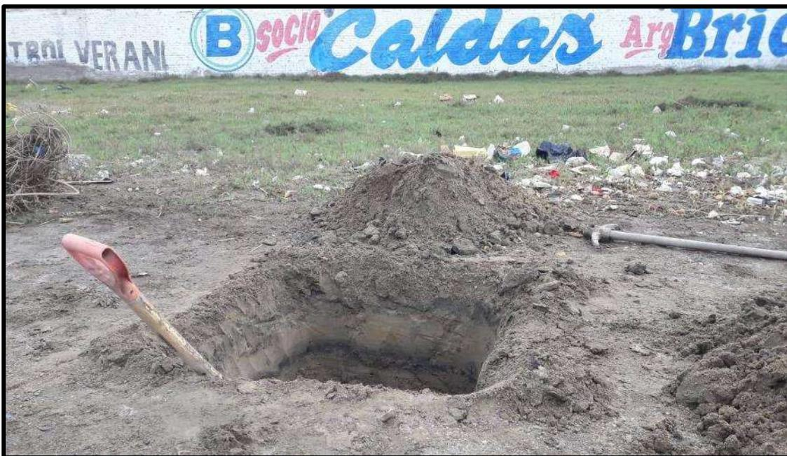
**Imagen 02:** Excavación de la Calicata C-1, la cual tuvo una forma cuadrada de medidas 1.20 m x 1.20 m.
