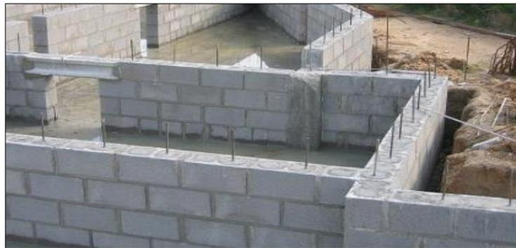
**Imagen 5:** Albañilería armada. – Fuente: Lizarzaburu M.<sup>26</sup>
