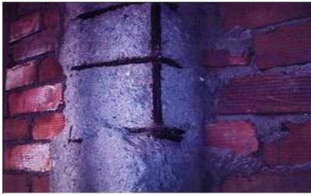
**Imagen 15:** Corrosión. – Fuente: Sepúlveda M.<sup>47</sup>
