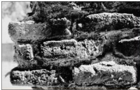
**Imagen 10:** Erosión. – Fuente: Broto C.<sup>42</sup>
