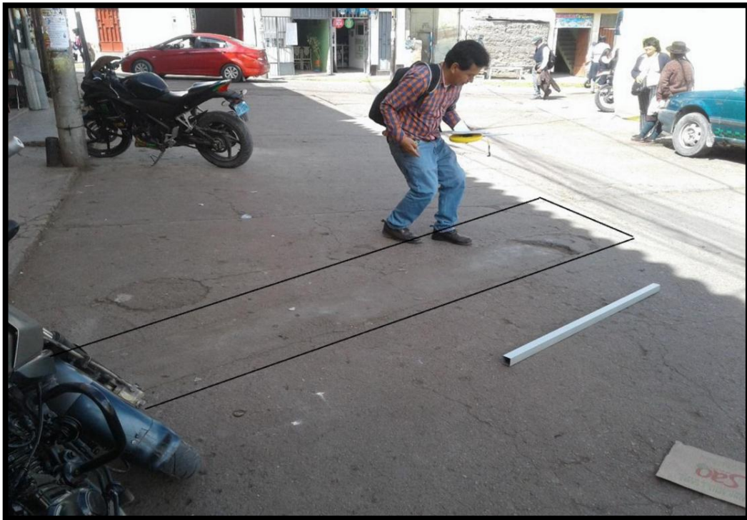
Figura 06: Patología tipo parche grande con severidad media ubicado en Jr. La Unión – Barrio Magdalena.
