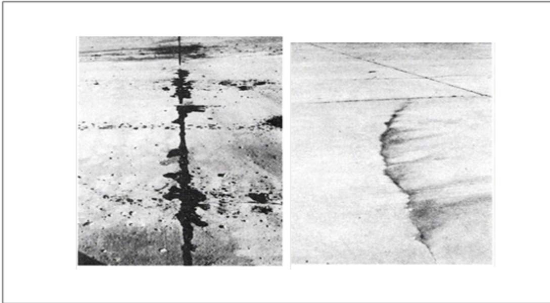
Figura 2.16: Bombeo. Fuente: Norma ASTM-D6433.
