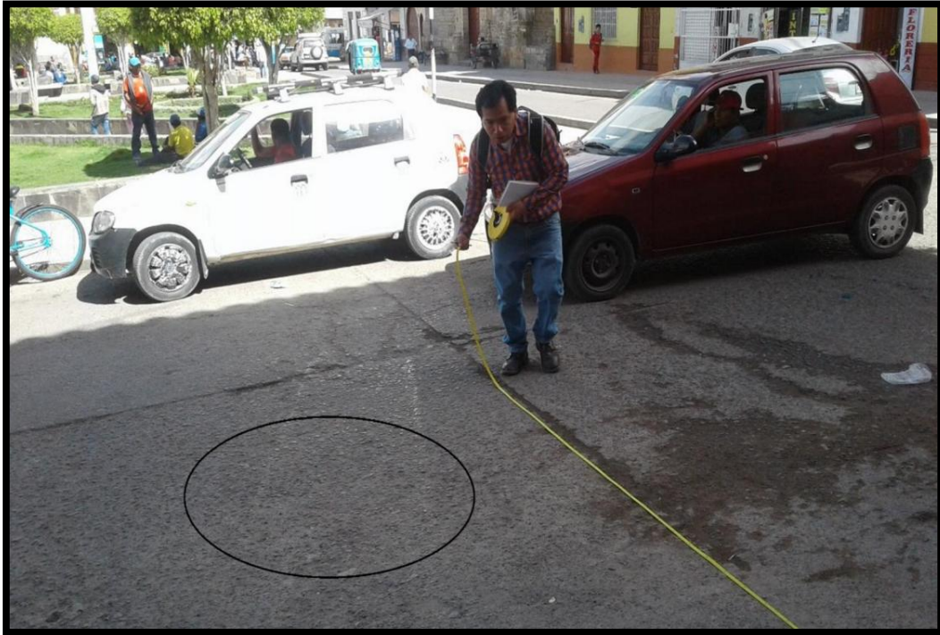
Figura 03: Patología tipo pulimiento de agregado de severidad media ubicado en el Jr. Unión.
