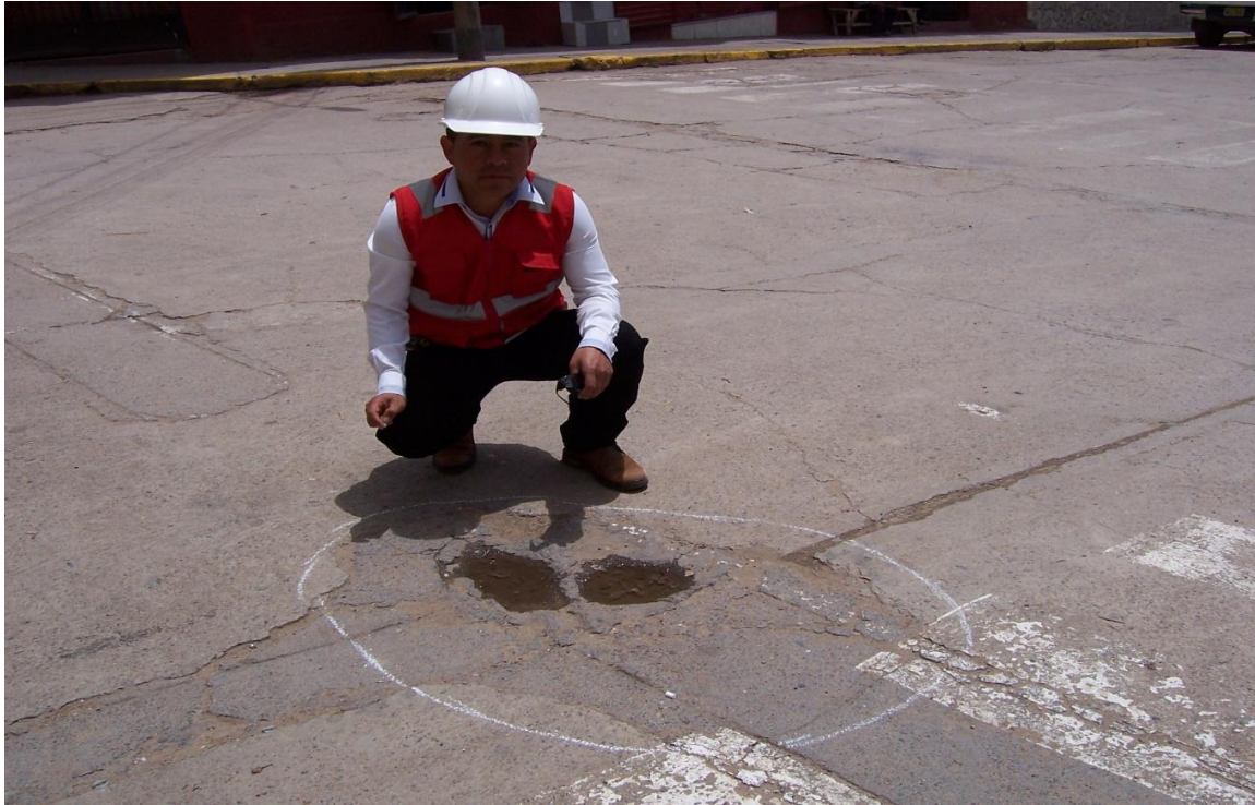
Figura 01: Vista de la captación N° 01 (3805 msnm).
