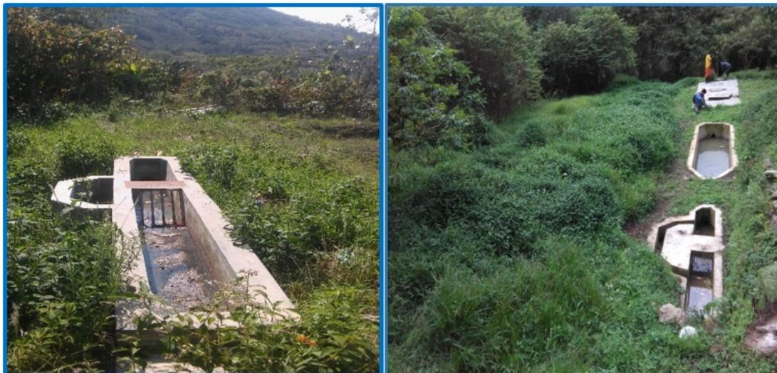
Figura 4.15: Situación en la recepción de planta de tratamiento de aguas residuales.
