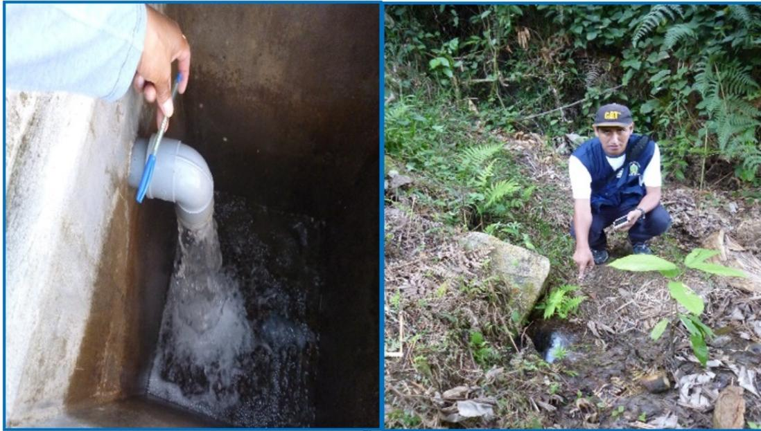
Figura 4.4: Caja rompe presión en la línea de Conducción existente en la comunidad de Ccollpa.
