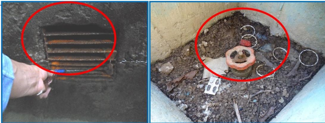
Figura 4.2: Infraestructura y accesorios en mal estado de la captación de Agua existente.
