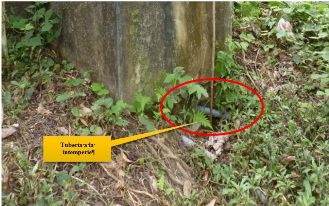
Figura 4.3: Tubería superficial con riesgo de que sufra ruptura, y teniendo contacto con los rayos solares que terminan dañando la tubería.
