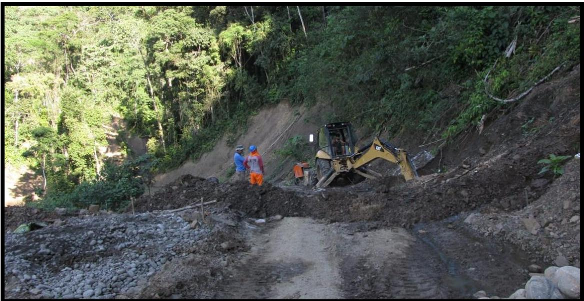
**Foto 04: Excavación para las tuberías de la línea de conducción.**
