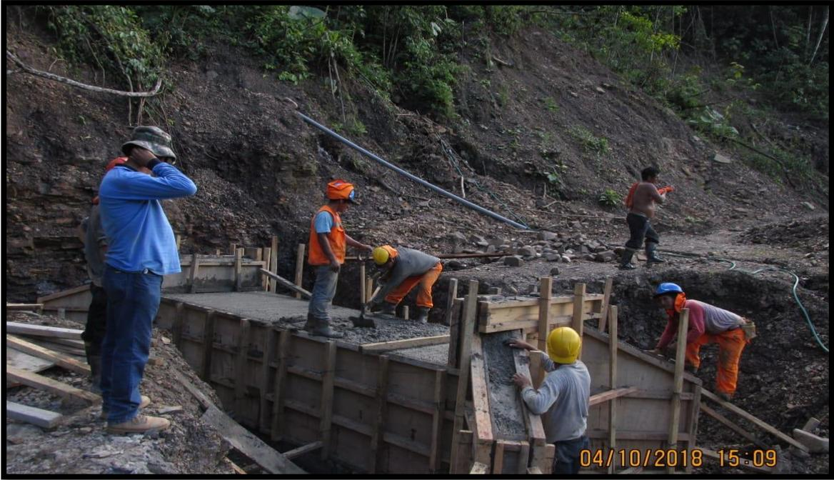
**Foto 05: Construcción de la Cámara rompe presión.**
