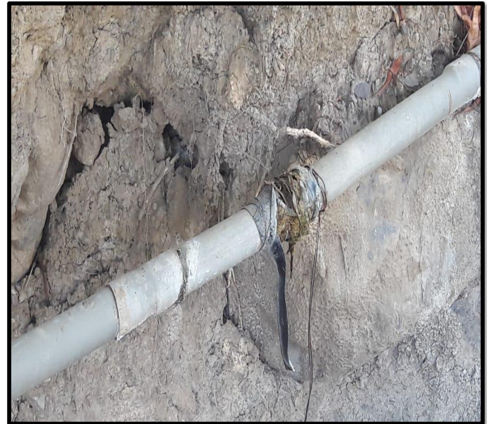
Figura 20 y Figura 21: : Fotografía, donde se observa tramos de la línea de conducción que fueron reparadas por los mismos pobladores.
