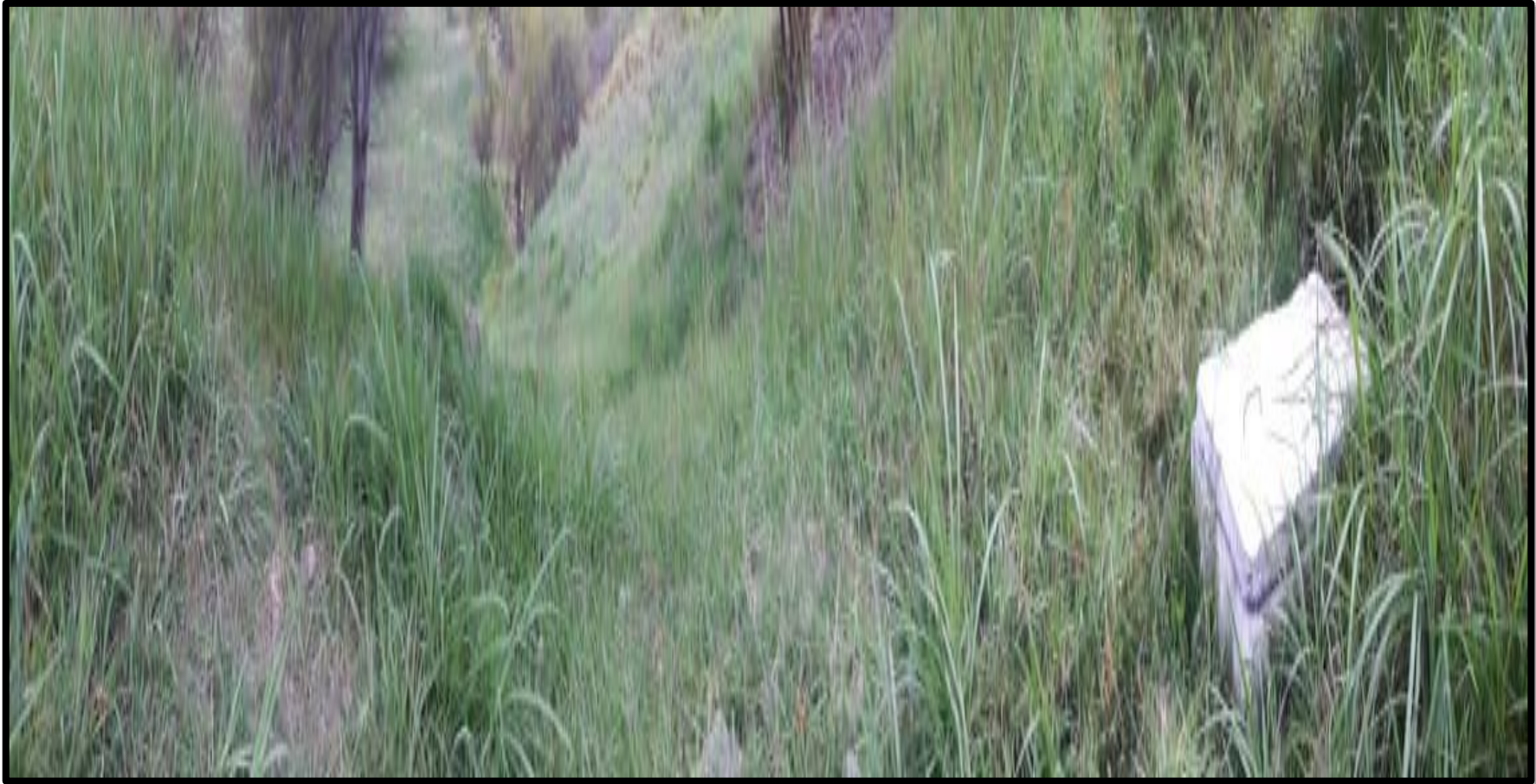
Figura 18: Fotografía, vista panorámica de la captación existente en el Caserío de Quihuay.
