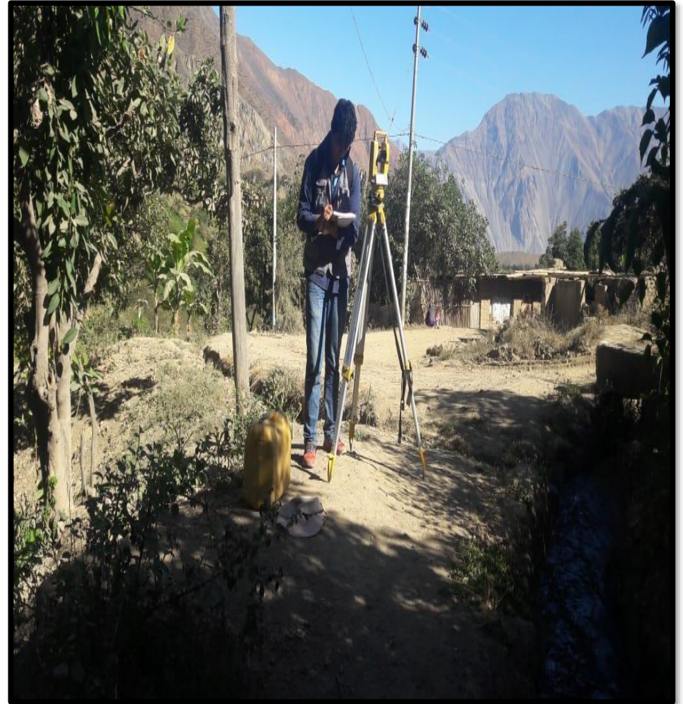
Figura 37 y 38: Fotografía Realizando el levantamiento topográfico donde se proyectó la línea de conducción
