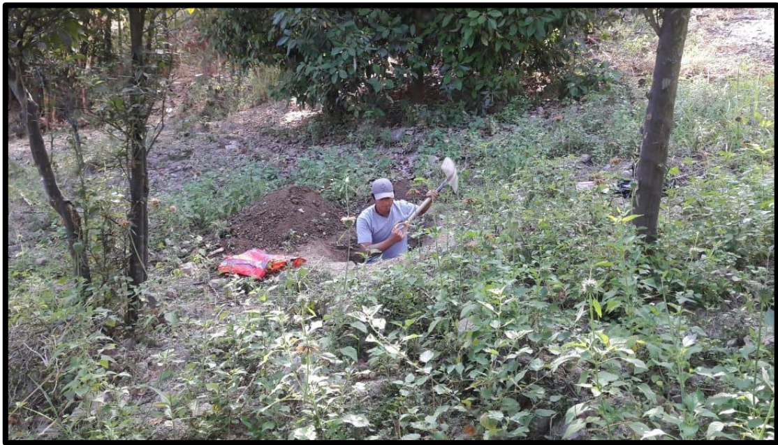
Figura 33: Fotografía Realizando calicata para el posterior estudio de suelos
