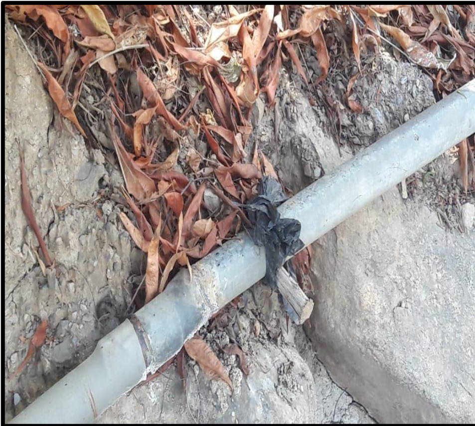
Figura 20 y Figura 21: : Fotografía, donde se observa tramos de la línea de conducción que fueron reparadas por los mismos pobladores.
