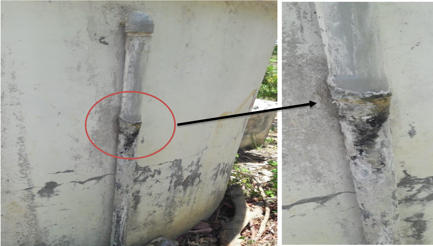
Figura 25 y 26: Fotografía, de la tubería del reservorio que los pobladores de Quihuay, repararon quemándola Fuente: Elaboración propia (2017)
