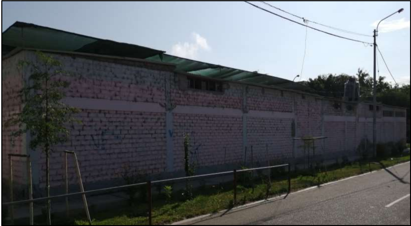
Fotografía 3: Vista del tramo 3 – 4 del cerco de la Institución Educativa Inicial 1563 Cristo Rey Amigo de los Niños, Distrito de Nuevo Chimbote, provincia del Santa, región Áncash.
