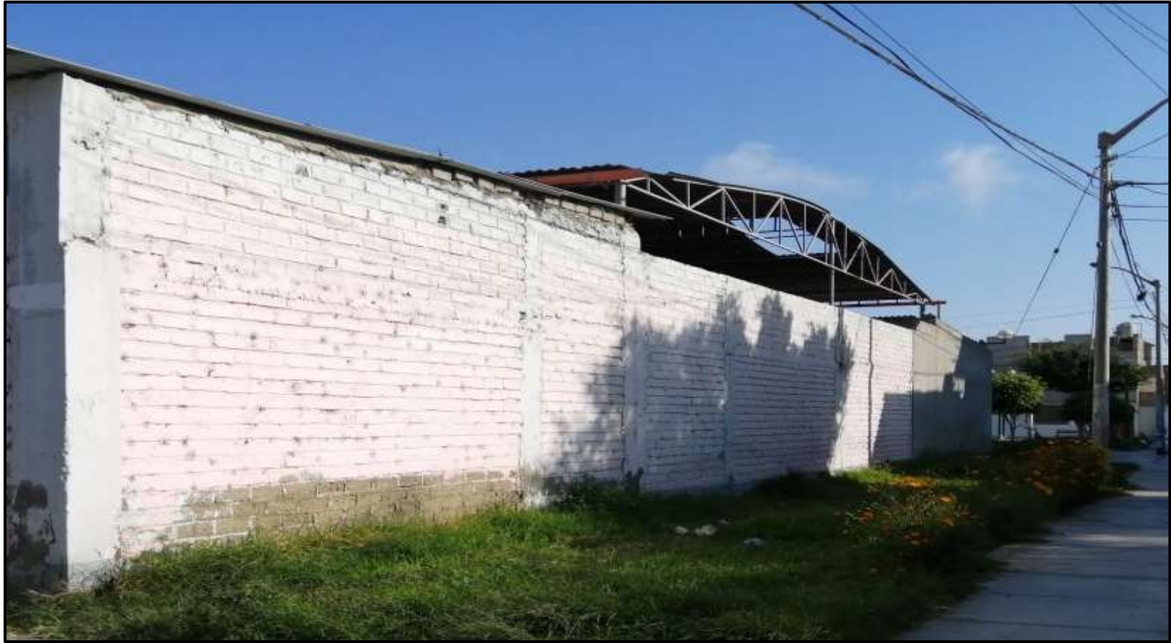
Fotografía 4: Vista del tramo 5 – 6 del cerco de la Institución Educativa Inicial 1563 Cristo Rey Amigo de los Niños, Distrito de Nuevo Chimbote, provincia del Santa, región Áncash.
