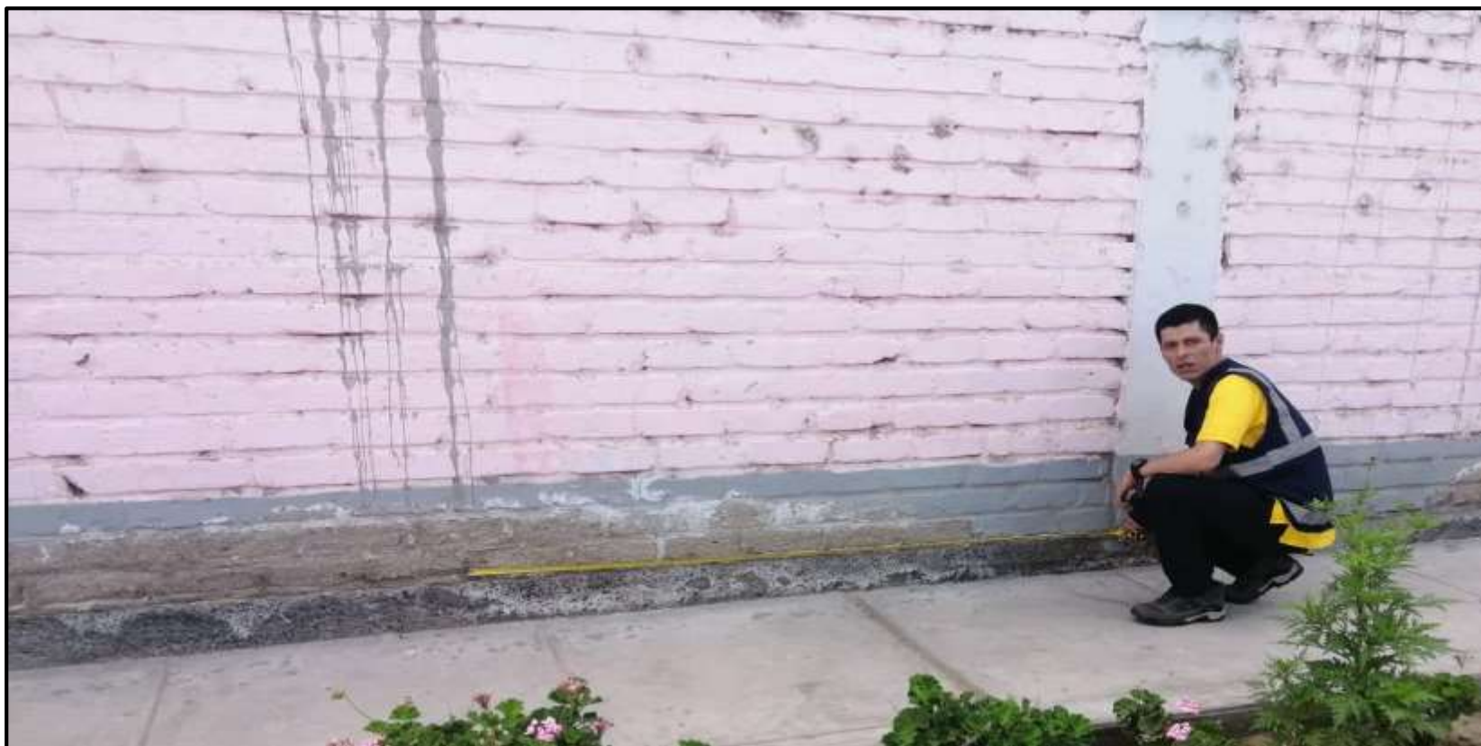
Fotografía 13: Medición de la Patología Eflorescencia en el Muro de la Institución Educativa Inicial 1563 Cristo Rey Amigo de los Niños en la Unidad Muestral 02.
