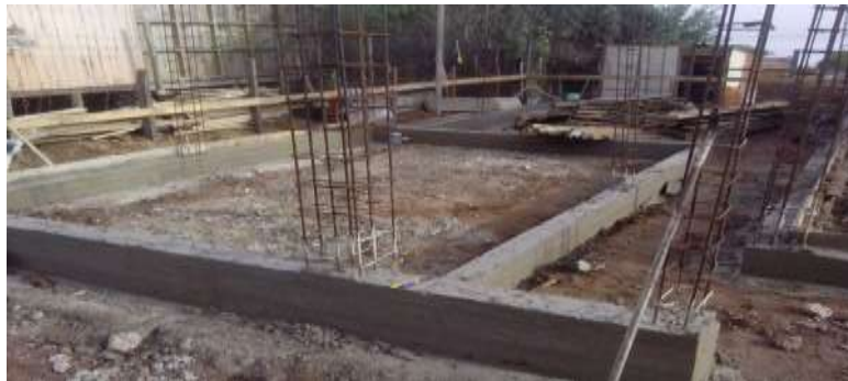
Figura 15: Construcción de un Sobrecimiento.
