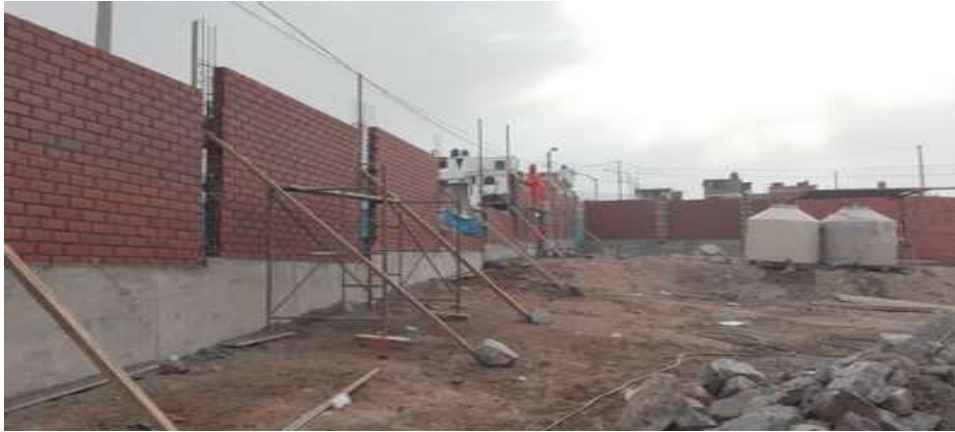
Figura 7: Proceso Constructivo de un Cerco Perimétrico.
