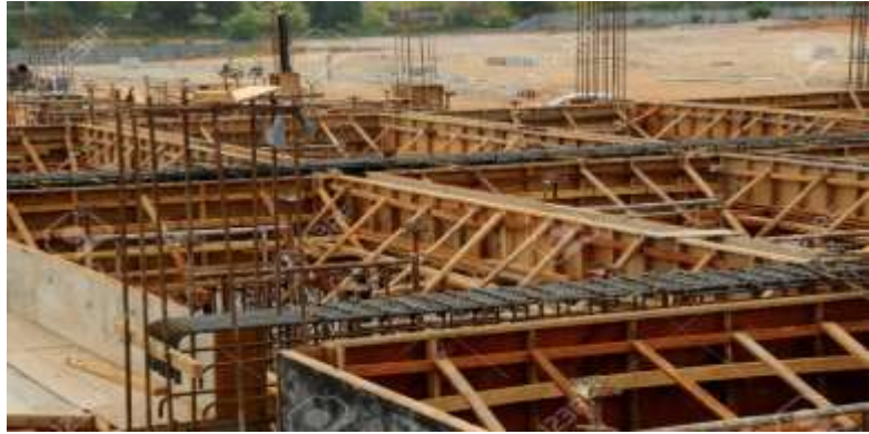
Figura 18: Encofrado de Vigas para construcción.
