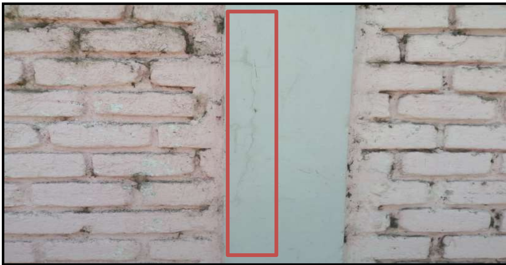
Fotografía 12: Patología Fisura presente en la Columna en la Institución Educativa Inicial 1563 Cristo Rey Amigo de los Niños en la Unidad Muestral 04.
