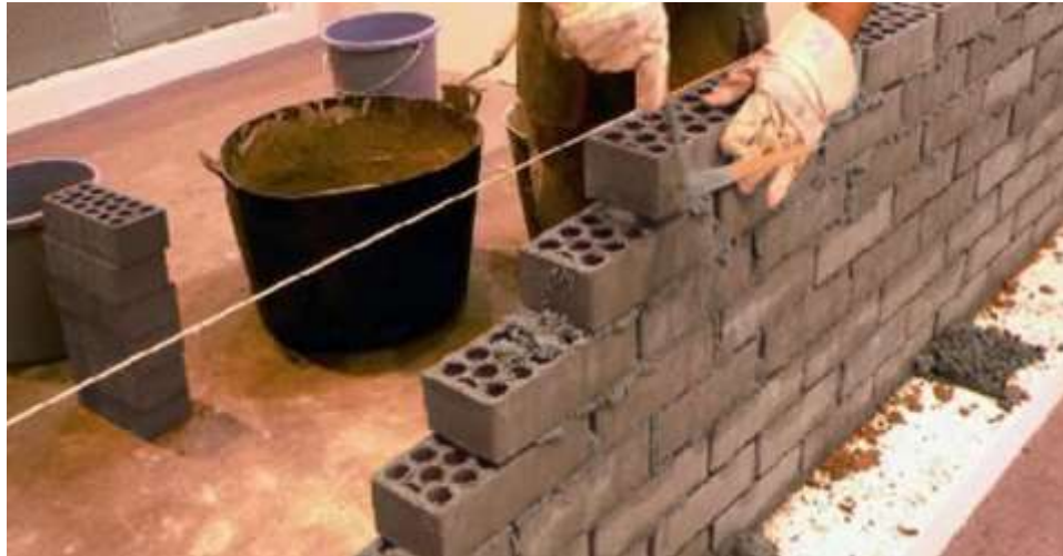
Figura 9: Albañilería en el Perú.
