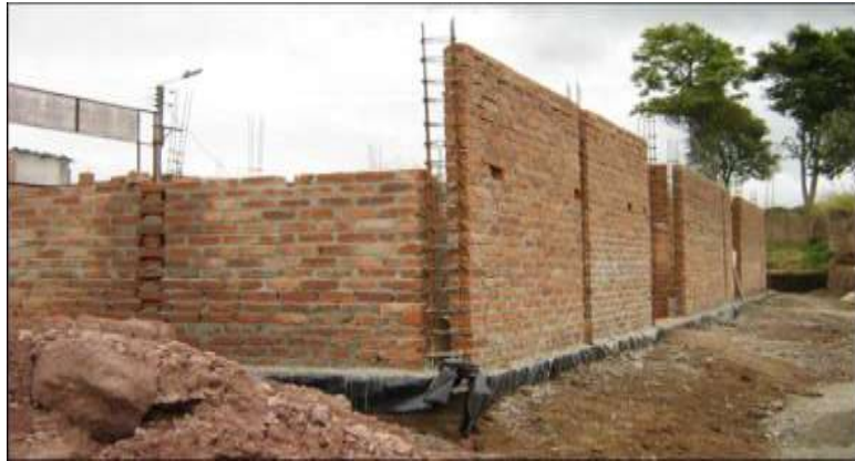
Figura 17: Muros en proceso constructivo.
