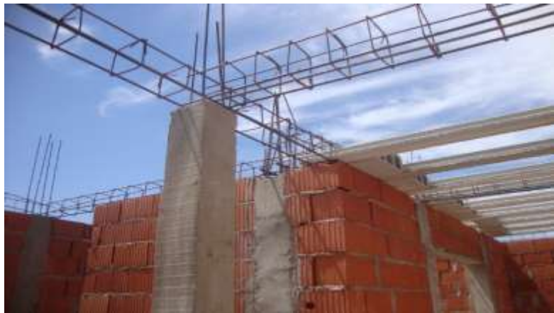
Figura 16: Columnas en Construcción.
