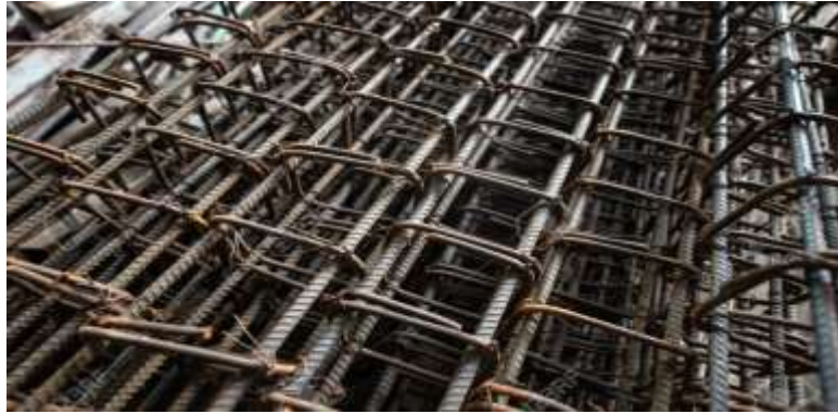
Figura 21: Acero de Refuerzo en Columnas.
