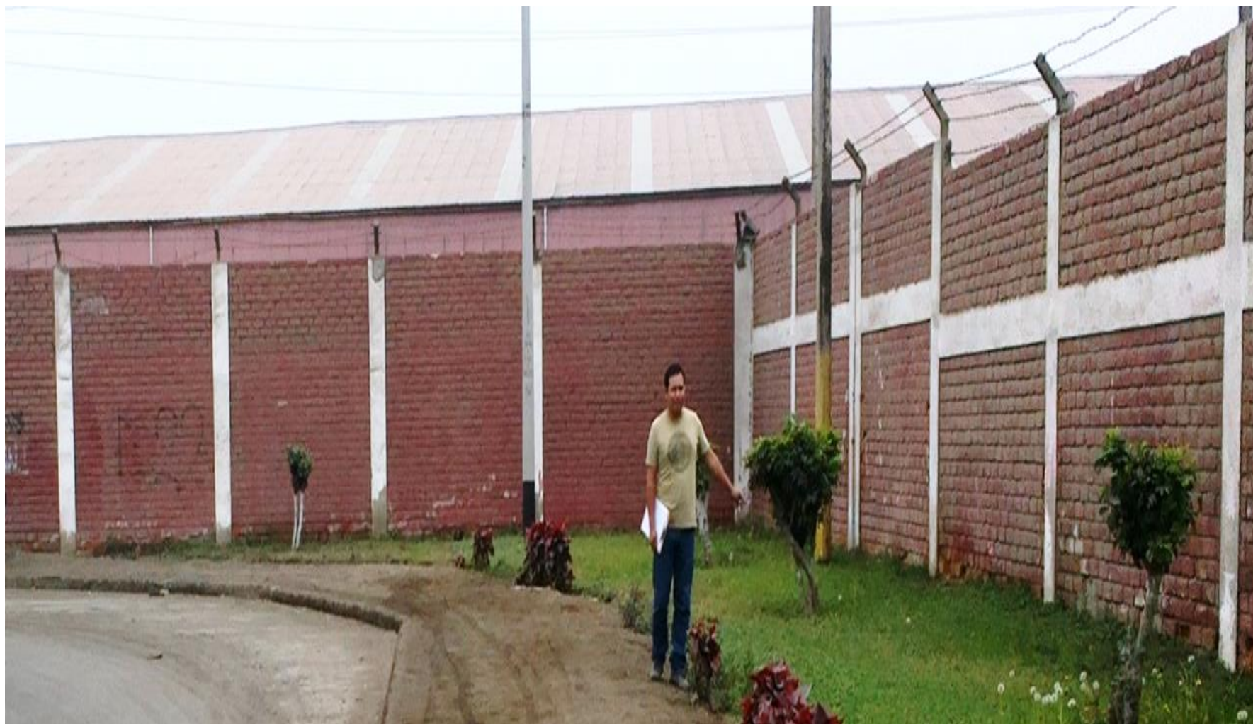
Figura 177. Cambio del tipo del cerco perimétrico en la avenida Micaela Bastidas.
