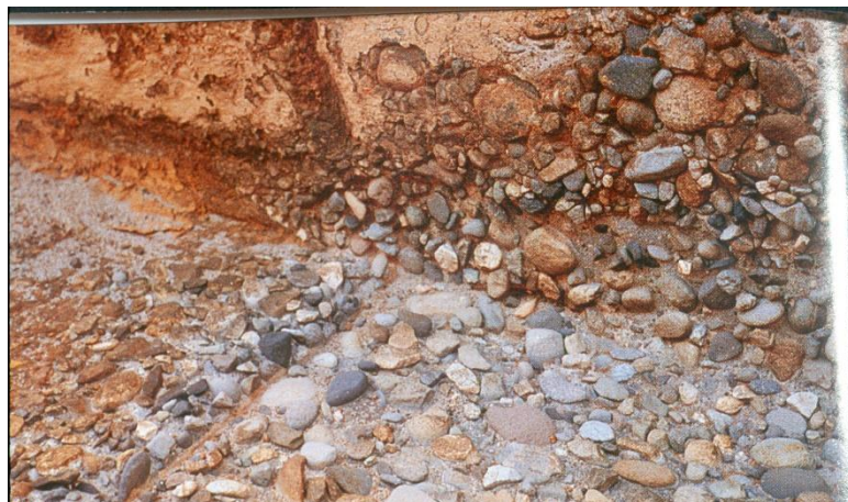
Figura 27. Estructura de concreto expuesto a la agresión química.
