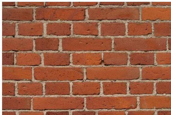
Figura 7. Unidades de albañilería adheridas entre sí con mortero de cemento.
