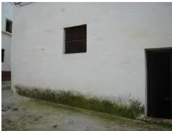
Figura 31. Ataque al concreto por hongos
