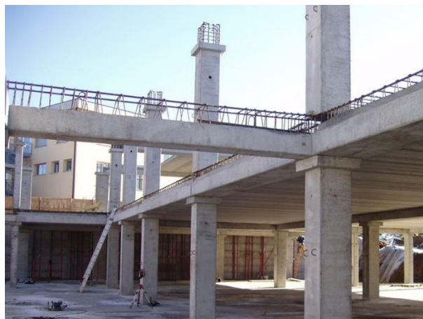
Figura 19. Vigas de concreto armado.
