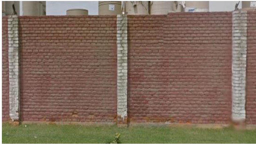
Figura 12. Muro de albañilería simple.
