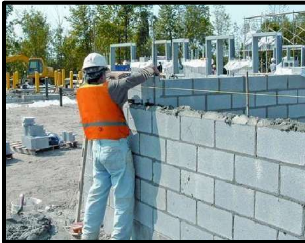
Gráfico 4: albañilería armada.
