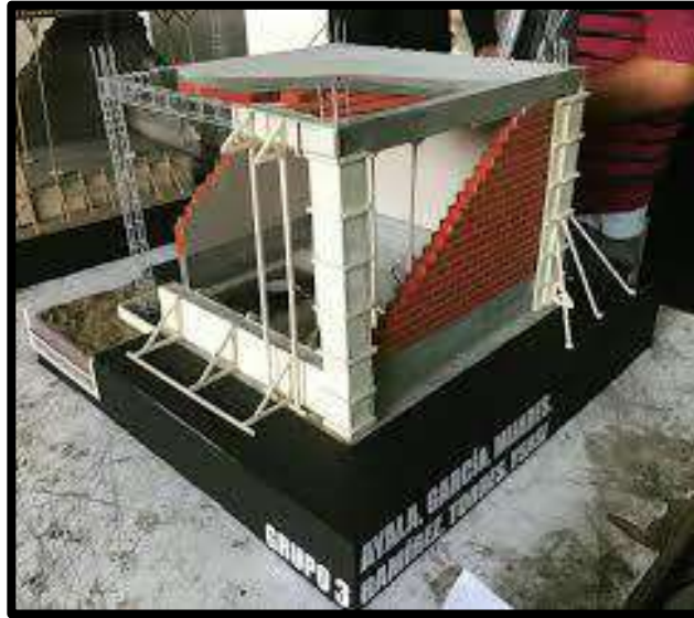
Gráfico 5: albañilería confinada.
