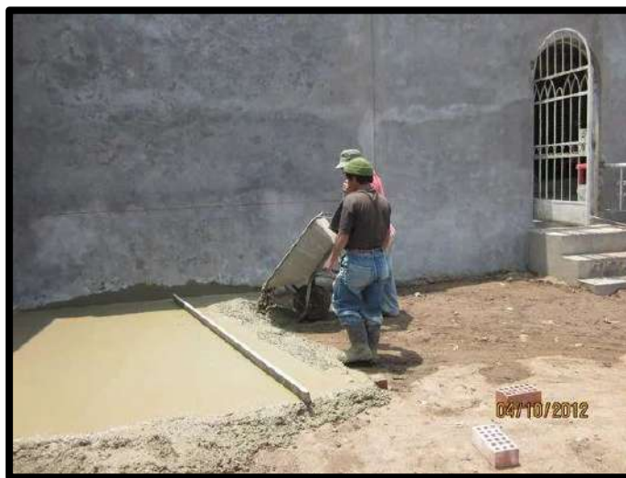
Gráfico 10: concreto simple en contrapiso. Fuente (Habitissimo) 10
