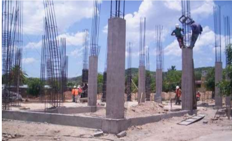
Figura 13: Columnas de Concreto.
