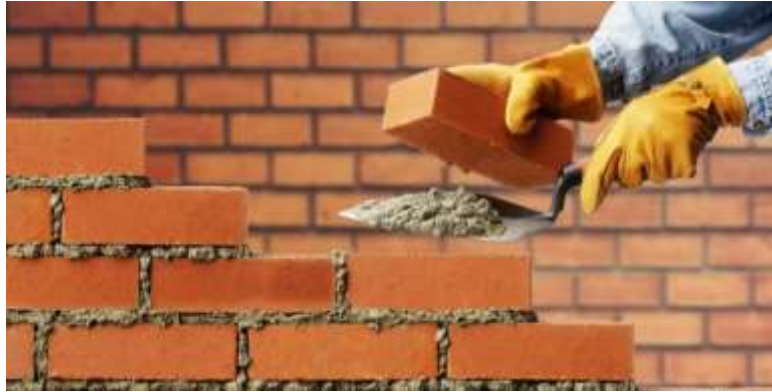
Figura 4: Muro de Albañilería Simple.
