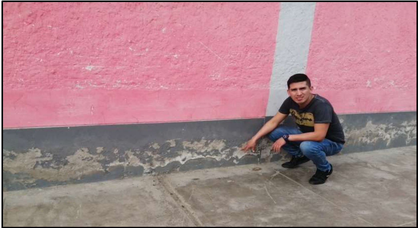
Imagen 5: Verificación de la Patología Eflorescencia presente en el Sobrecimiento de la Unidad Muestral 10 de la Institución Educativa N° 88016 José Gálvez Egúsquiza.
