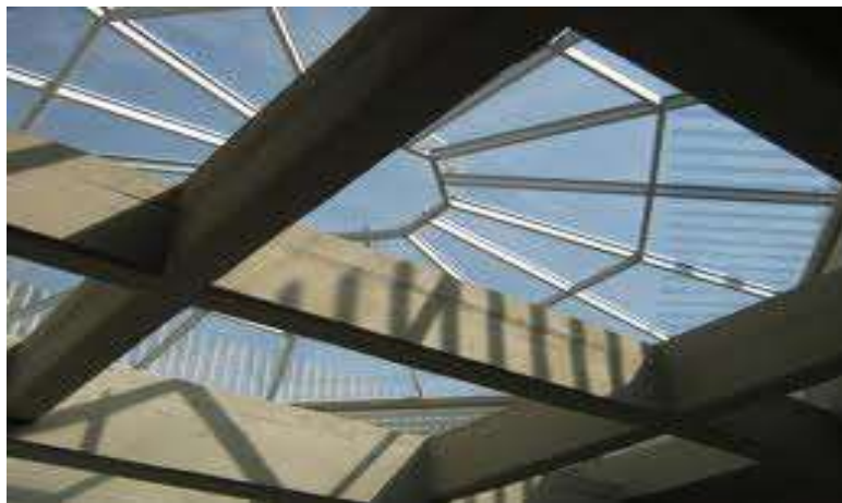
Figura 14: Vigas de Concreto.
