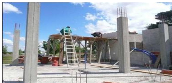
Imagen 07: Columnas en proceso constructivo.
