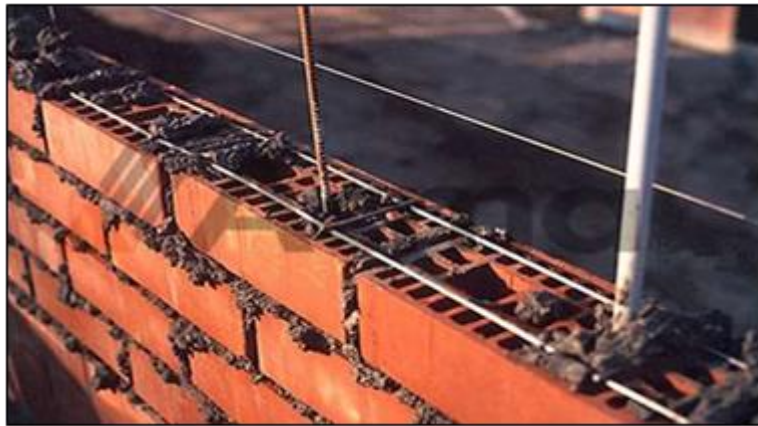
Imagen 03: Albañilería reforzada. Fuente: chile.Cubica. (2016)
