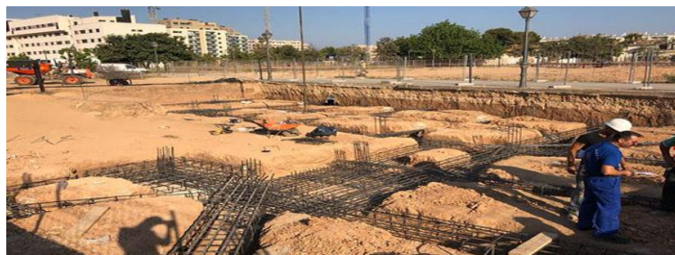
Imagen 05: Cimentación en proceso constructivo. Fuente: fmreflejos. (2010)
