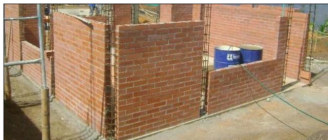
Imagen 09: Muros. Fuente: Ramírez M. (2011).
