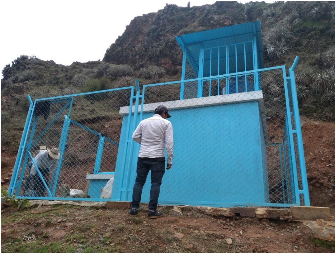
Foto 03. Se observa el reservorio rectangular, el cual se encuentra en condiciones óptimas, a diferencia de su sistema de cloración.
