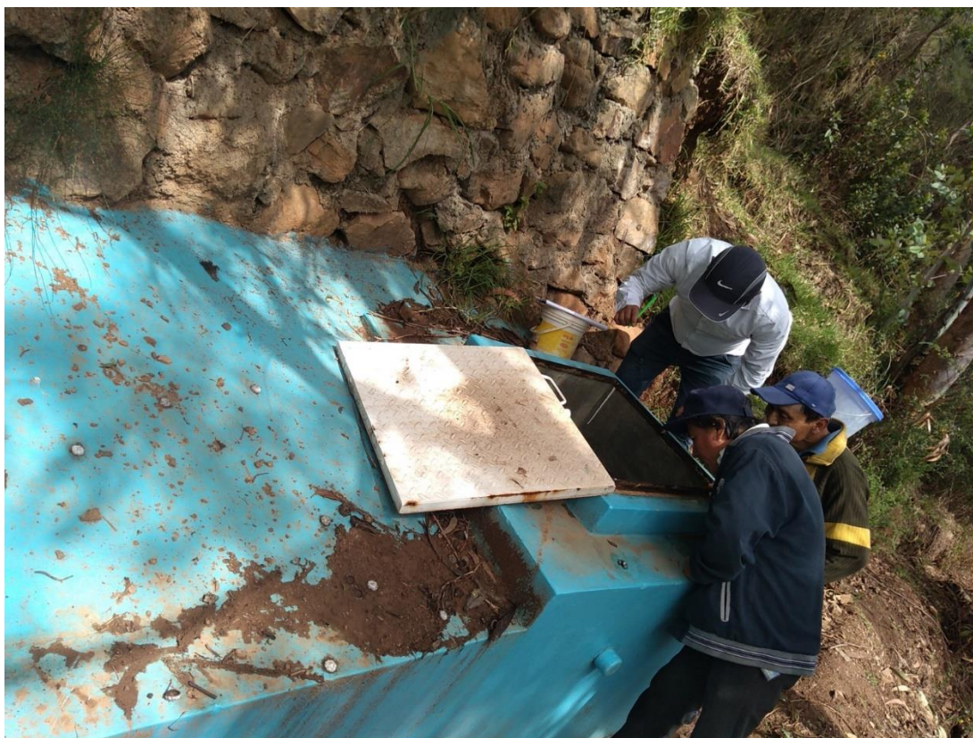
Foto 01. Se observa la captación del sistema de agua potable y no cuenta con un cerco perimétrico.
