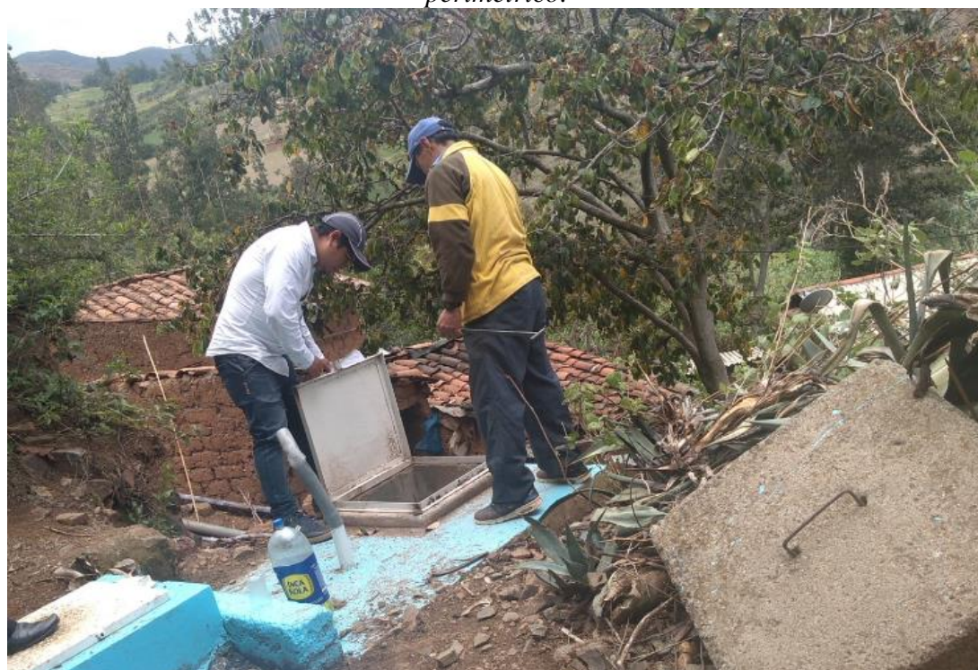
Foto 01. Se observa la captación del sistema de agua potable y no cuenta con un cerco perimétrico.
