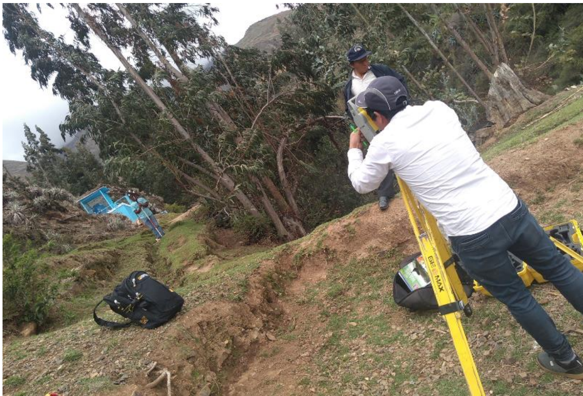
Foto 05. Realizando el levantamiento topográfico para el diseño del alcantarillado sanitario.
