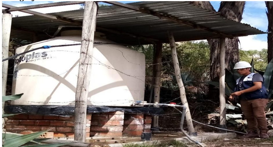
Fotografía N° 12. Conexión de la salida de la línea de distribución
