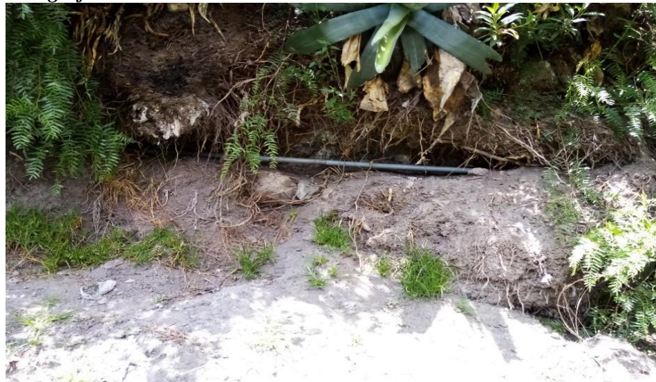
Fotografía N° 15. Línea de conducción.02
