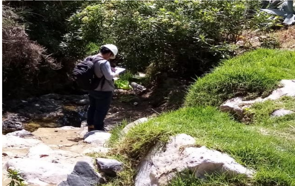
Fotografía N° 13. Captación en ladera
