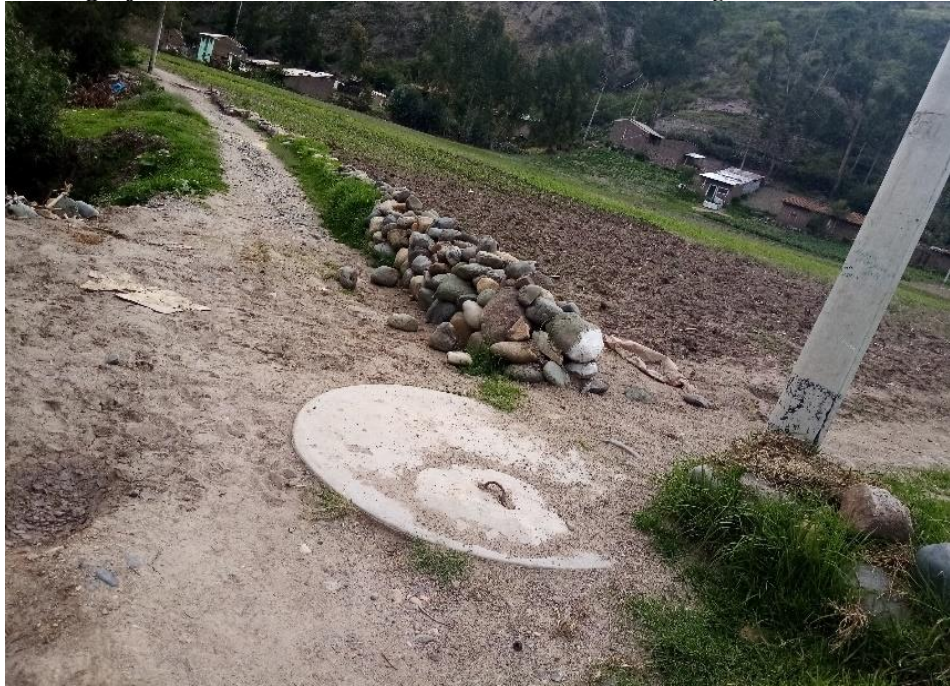
Fotografía N° 20. Líneas colectoras de la red de desague
