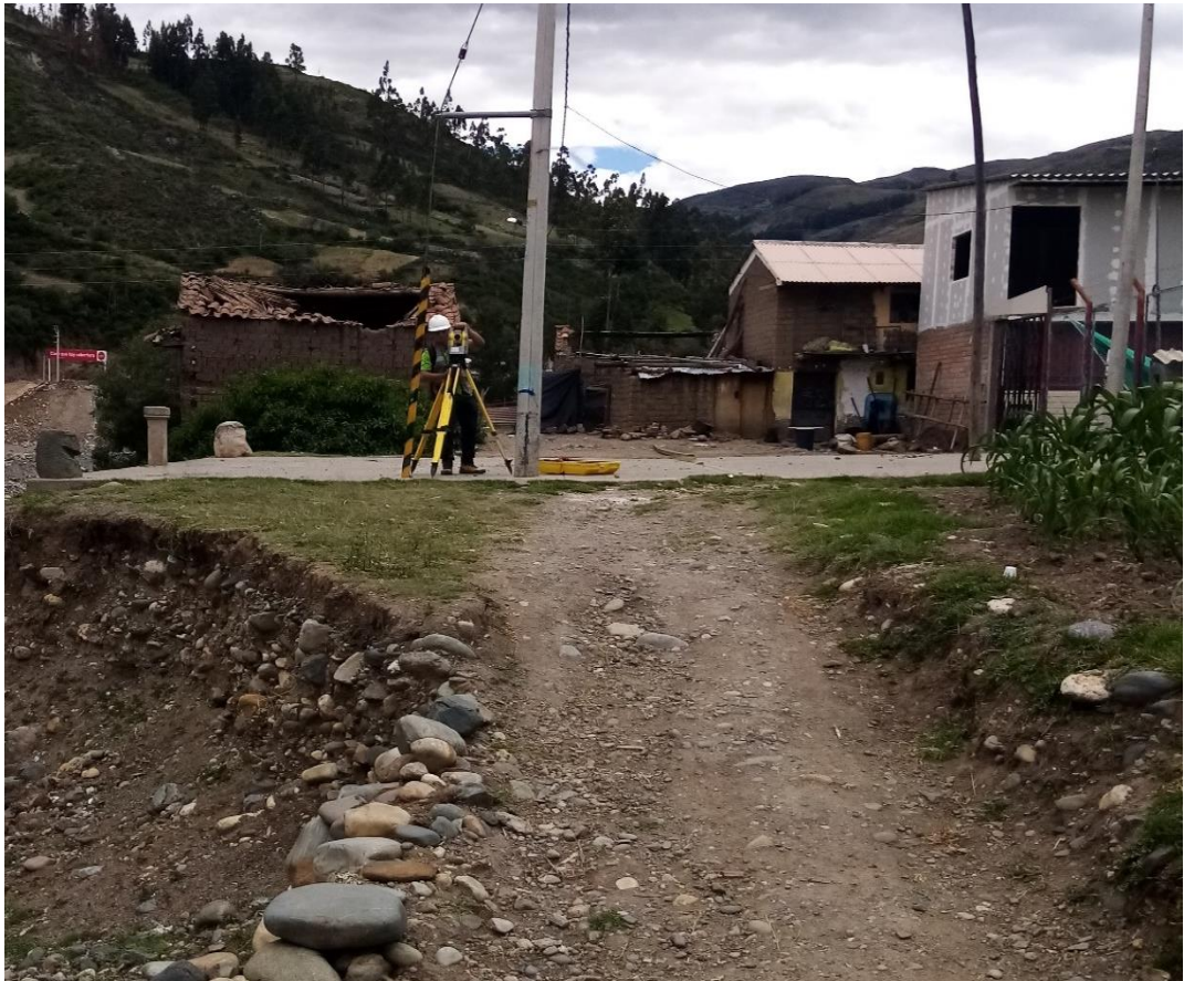
Fotografía N° 35. Levantamiento topográfico la línea de alcantarillado sanitario
