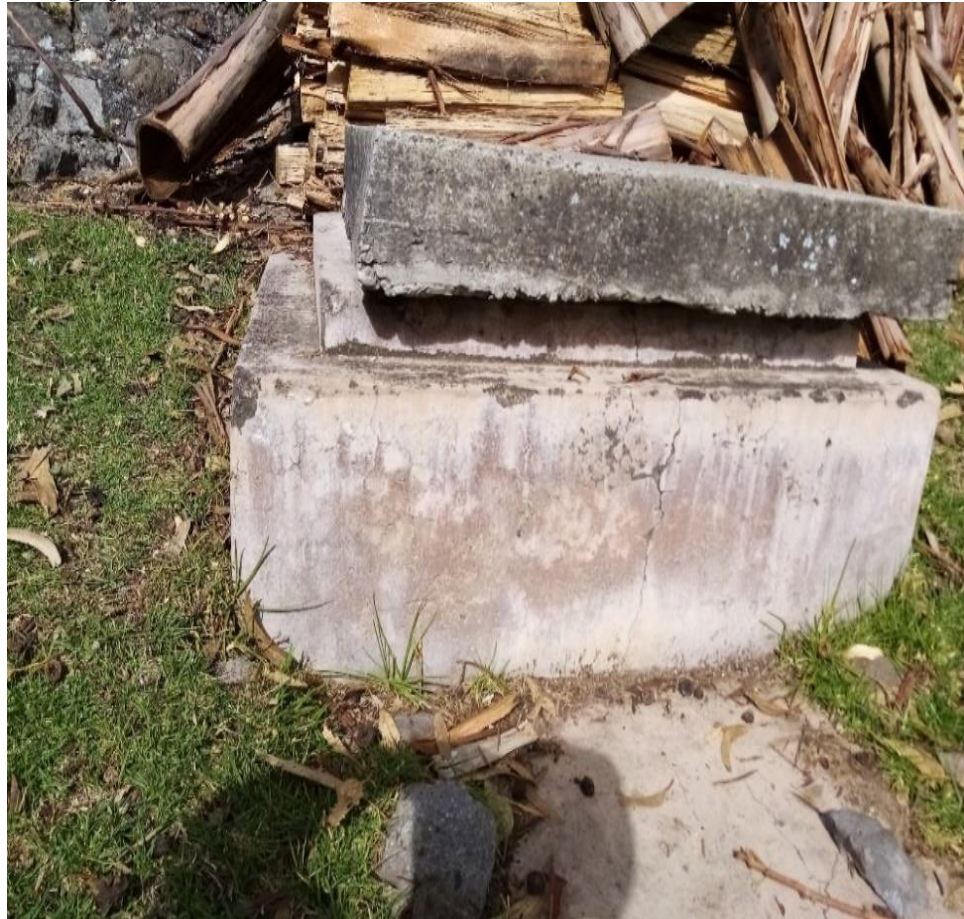
Fotografía N° 1. Captación en ladera
