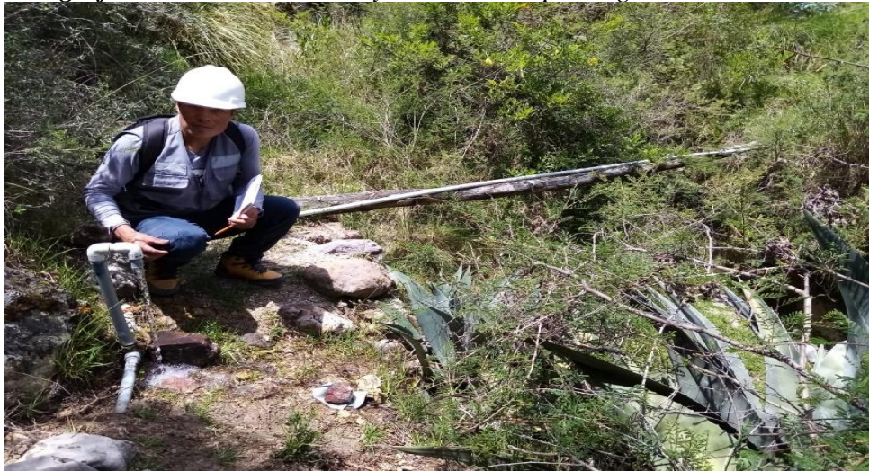
Fotografía N° 17. Pases aéreos y tubos de rompe carga
