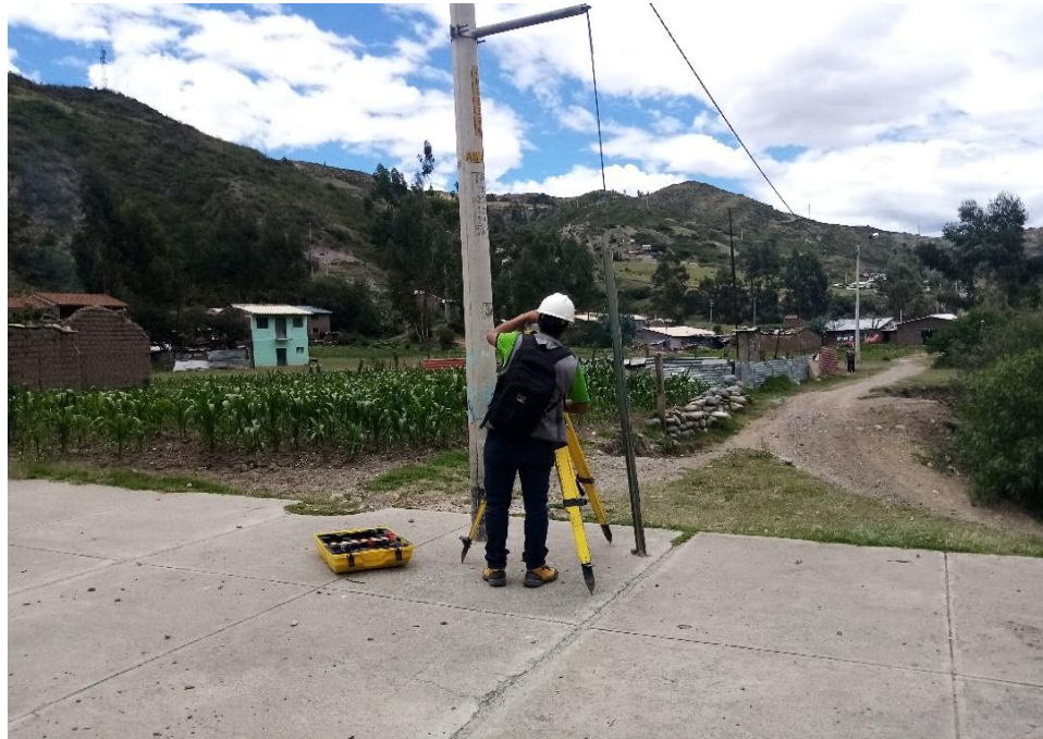
Fotografía N° 22. Levantamiento topográfico de la red de alcantarillado sanitario.
