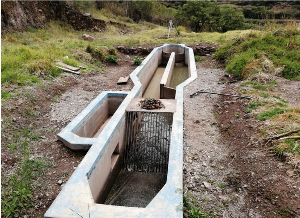
Figura 5.7: Cámara de rejas y desarenador con limpieza manual en la planta.
