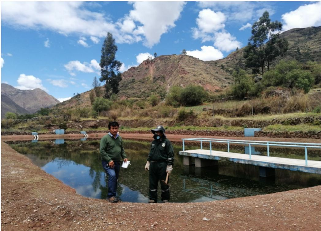
Figura 5.8: Segunda laguna de bio estabilización para tratamiento de aguas residuales.
