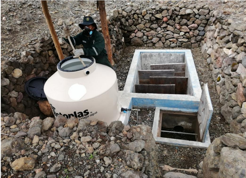
Figura 5.9: Salida de efluentes de la planta de tratamiento de aguas residuales en la que se le adiciona cloro para reducir la carga bacterial.
