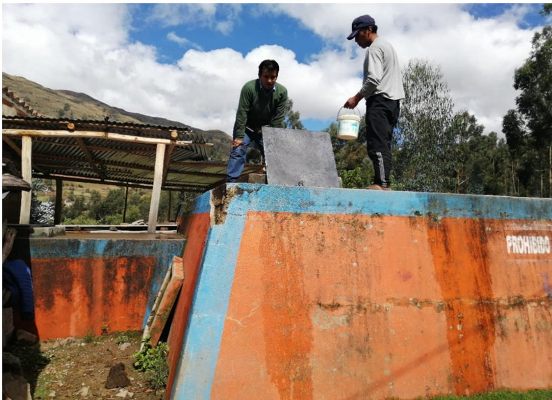
Figura 5.2: Cloración en el reservorio Belén mediante preparación diaria de solución de cloro de acuerdo a dosis indicada.
