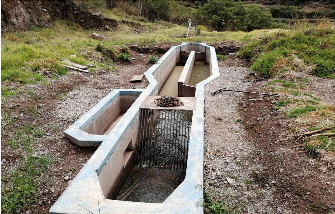
**Fotografía 05:** Cámara de rejillas para separación de sólidos.
