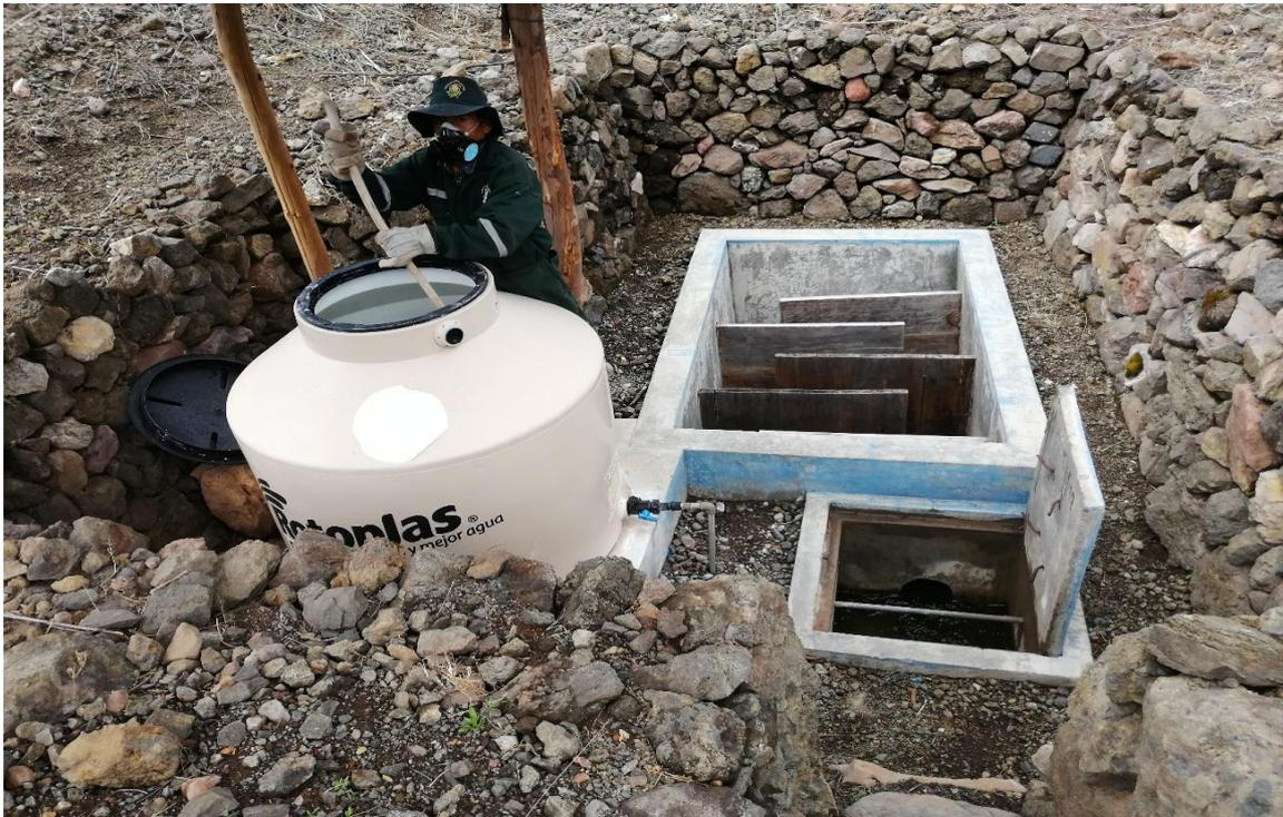
**Fotografía 06:** Adición de solución de cloro al efluente.
