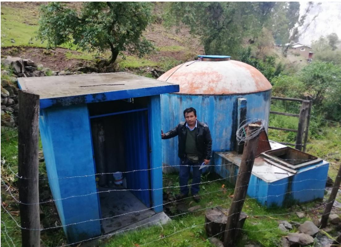
Figura 5.3: Reservorio Itana Huaycco y su caseta de cloración.
