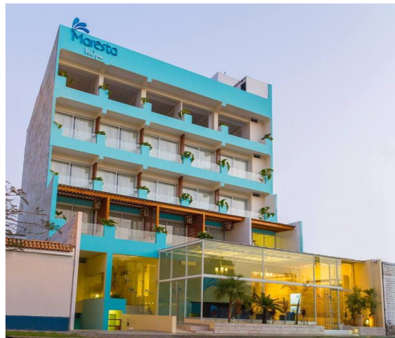
Fotografía 1: Fachada del lodge “Maresta” en donde se encuentra el restaurante “Mares”.
