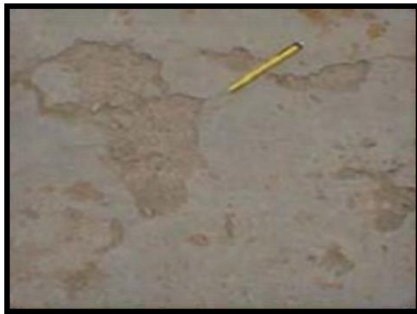
Imagen 3 Descascaramiento Fuente: Elaboración propia
