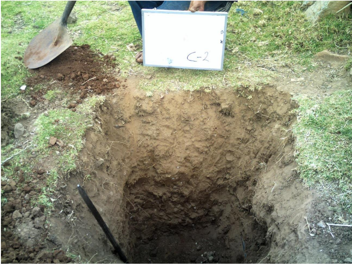
Foto 02. En la excavación de una de las calicatas del centro poblado Muña Alta.
