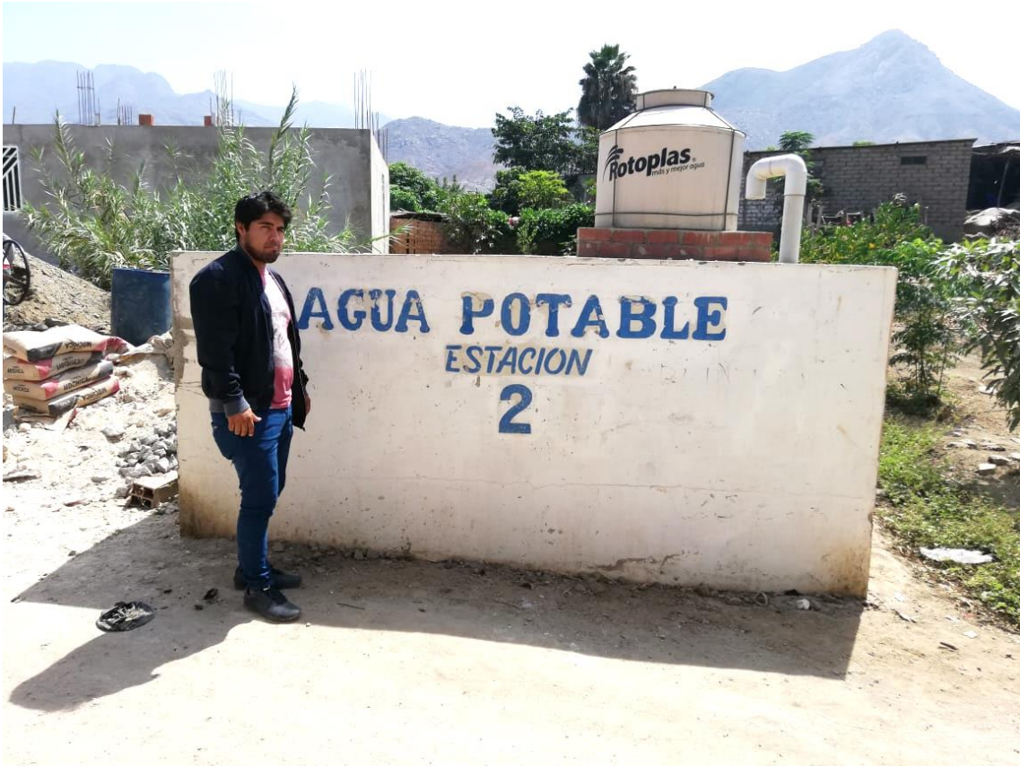
Foto 05. En el reservorio del centro poblado Cachipampa – Muña - Alta.
