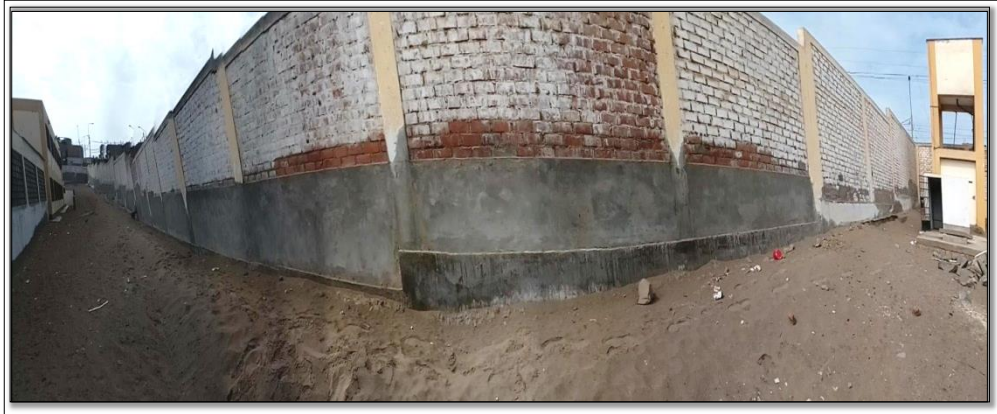
Figura 01. Cerco perimétrico de albañilería confinada.
