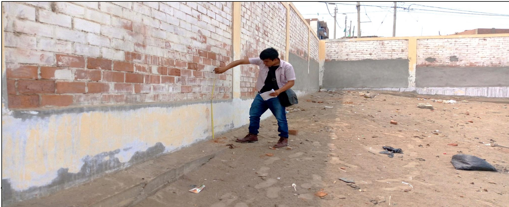
Imagen 2: vista de la parte interna del cerco perimétrico calle 4 (0602) midiendo el sobrecimiento de la institución educativa estatal San José de Manzanares, ubicado en el distrito de Huacho, provincia de Huaura, departamento de Lima.
