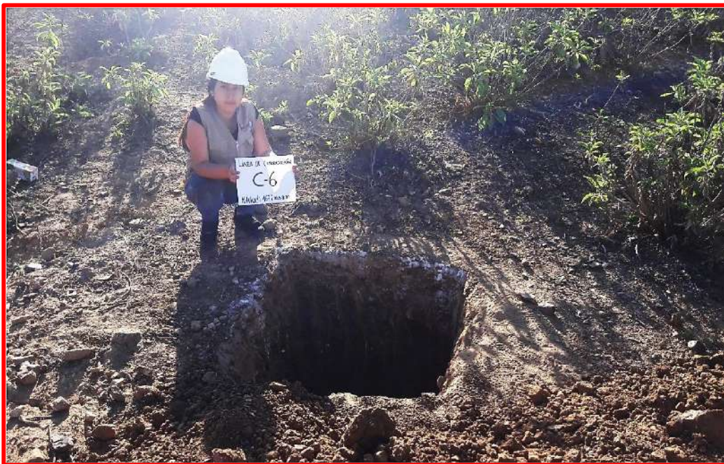
Imagen 13. Calicata N° 06 en la Línea de Conducción del caserío Miraflores.
