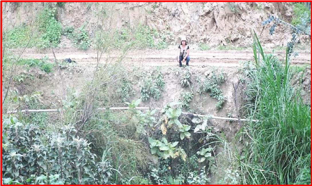
Imagen 6. Línea de Conducción del caserío Miraflores.
