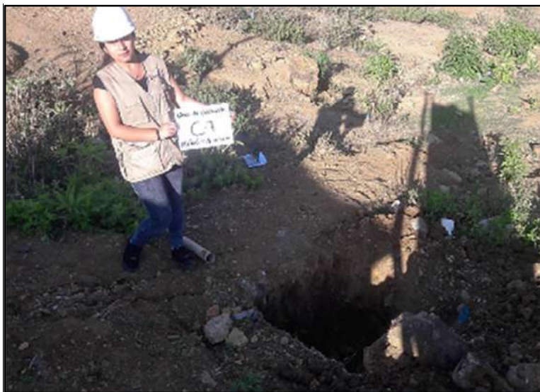
FOTO 07: SE OBSERVA LA EXCAVACIÓN CALICATA C-07.
