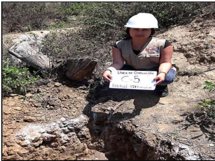
FOTO 05: SE OBSERVA LA EXCAVACIÓN CALICATA C-05.
