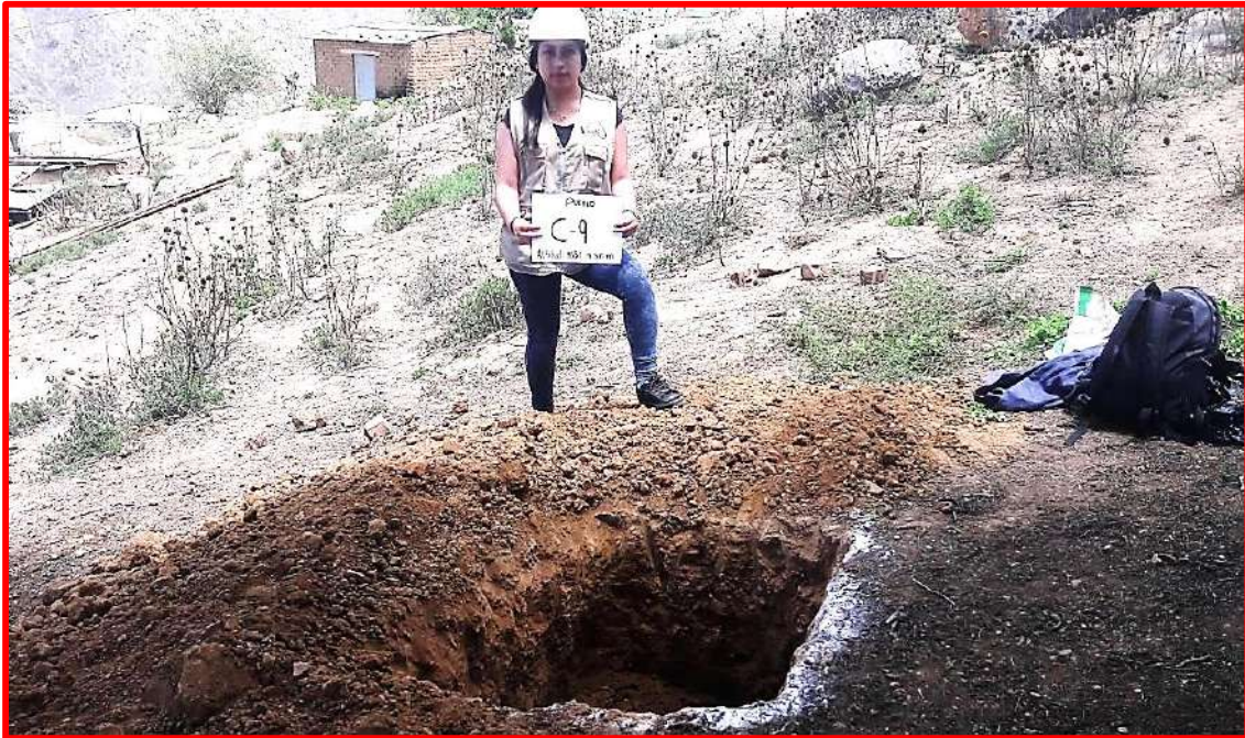
Imagen 14. Calicata N° 09 en el pueblo del caserío Miraflores.
