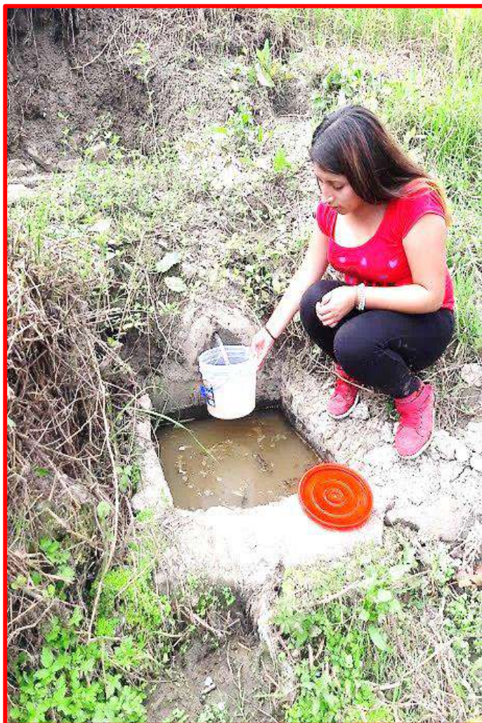
Imagen 1. Captación manantial de ladera - Yacu.
