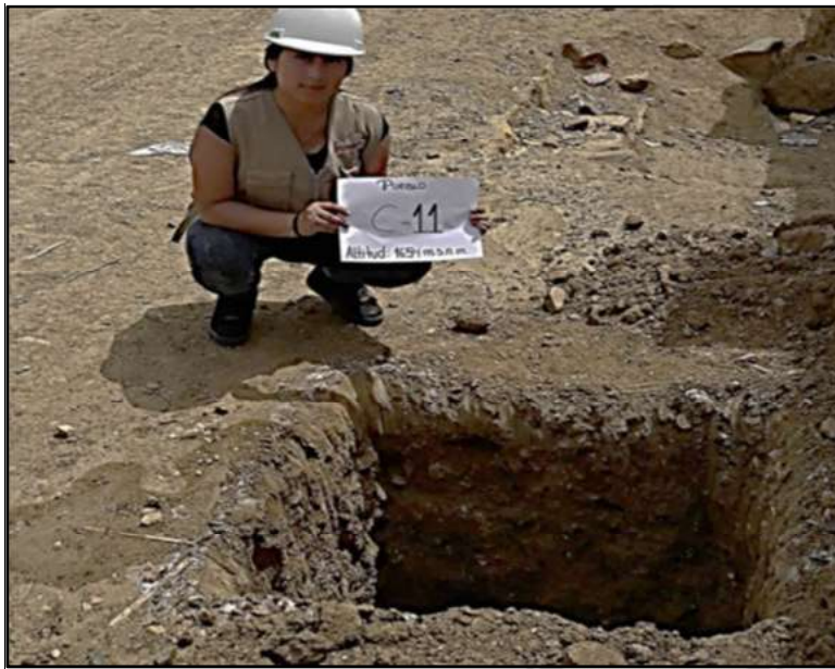
FOTO 11: SE OBSERVA LA EXCAVACIÓN CALICATA C-11.
