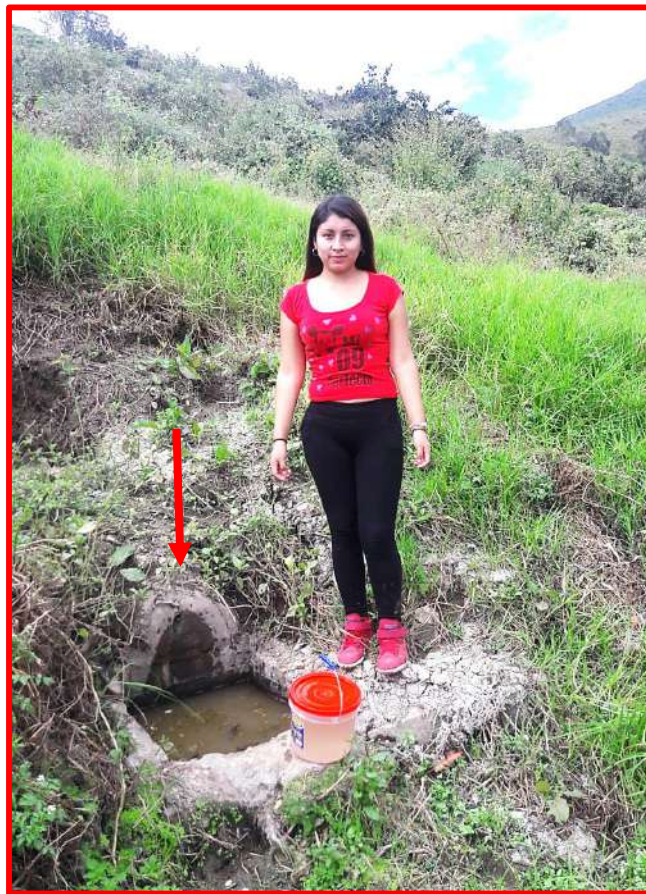
Imagen 7. Captación de ladera del caserío Miraflores.
