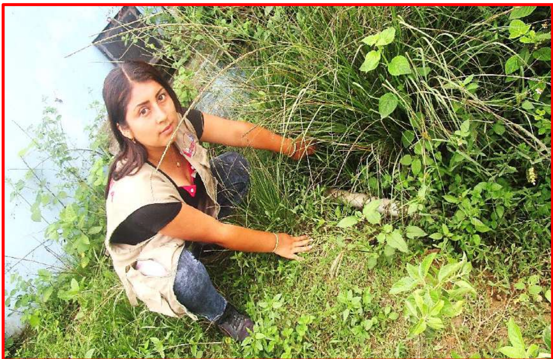
Imagen 9. Línea de Aducción del caserío Miraflores.
