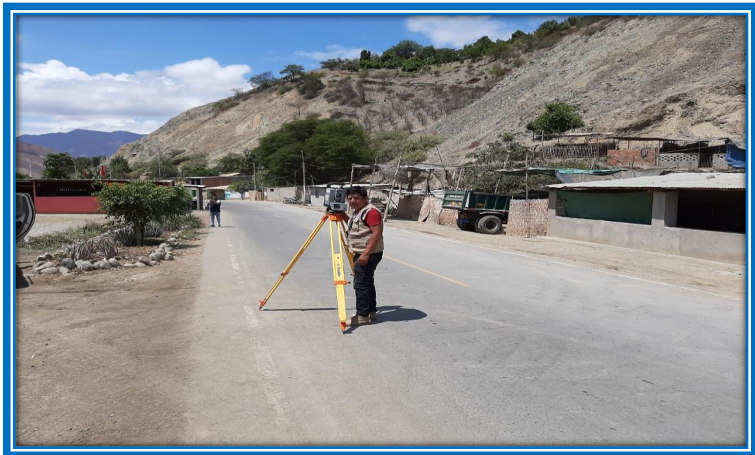
Foto N° 08.- Teniendo en cuenta según la evaluación del sistema de abastecimiento de agua se procedió a realizar el levantamiento topográfico de la red distribución.
