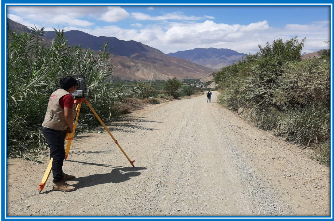
Foto N° 09.- Teniendo en cuenta según la evaluación del sistema de abastecimiento de agua se procedió a realizar el levantamiento topográfico la línea de conducción.
