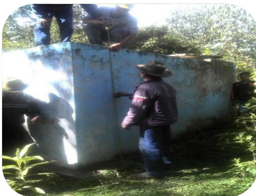
Imagen 17: vista de la inspección y medición del reservorio de 14 m 3 existente.
