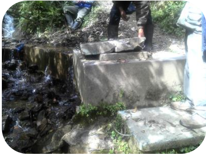
Imagen 9: Se observa la caja de captación “Manzanas”
