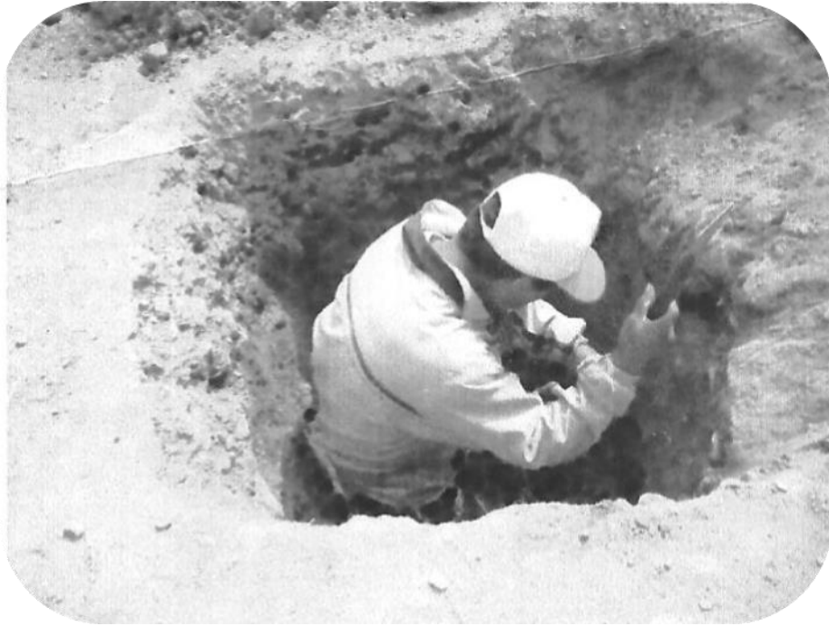
Imagen 07: Se observa realizando la calicata 1 de exploración subterránea en la localidad de Saucopata.
