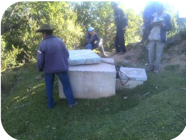
Imagen 15: vista de la 3ª cámara rompe presión CRP-6
