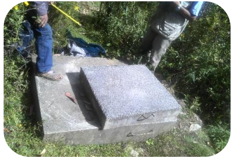
Imagen 12: vista exterior de la caja de reunión existente
