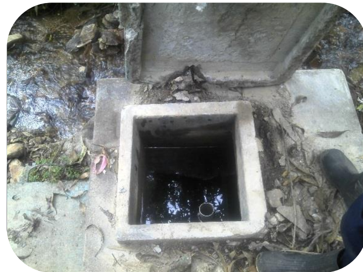
Imagen 010: Se observa la caja de captación “Chorro blanco”
