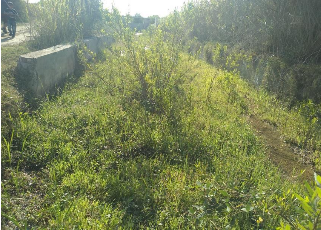
Fotografía 03: Vista desde el final de la toma de agua
