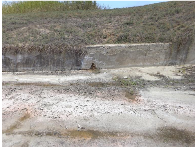
Imagen 8: Patología Socavación.
