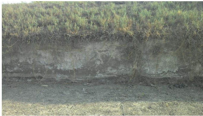
Imagen 4: Patología de Eflorescencia.
