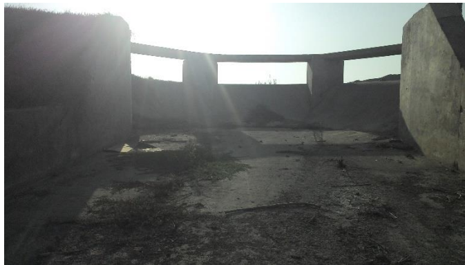
Imagen 1: Toma de agua. Fuente: Elaboración propia.
