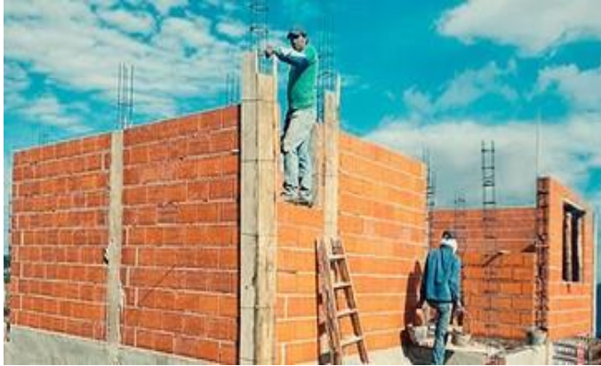
Gráfico 2: Albañilería confinada
