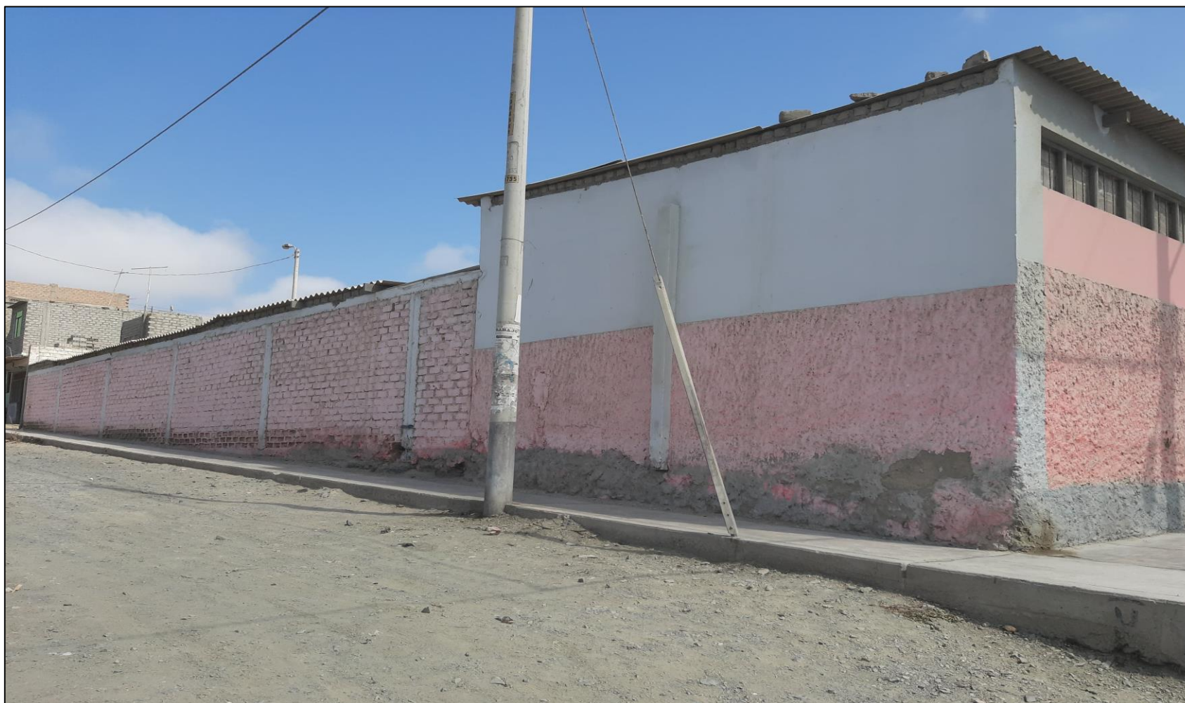
Fotografía 2: vista lateral derecha del cerco perimétrico de la institución educativa 1586 los pequeños traviesos del satélite.
