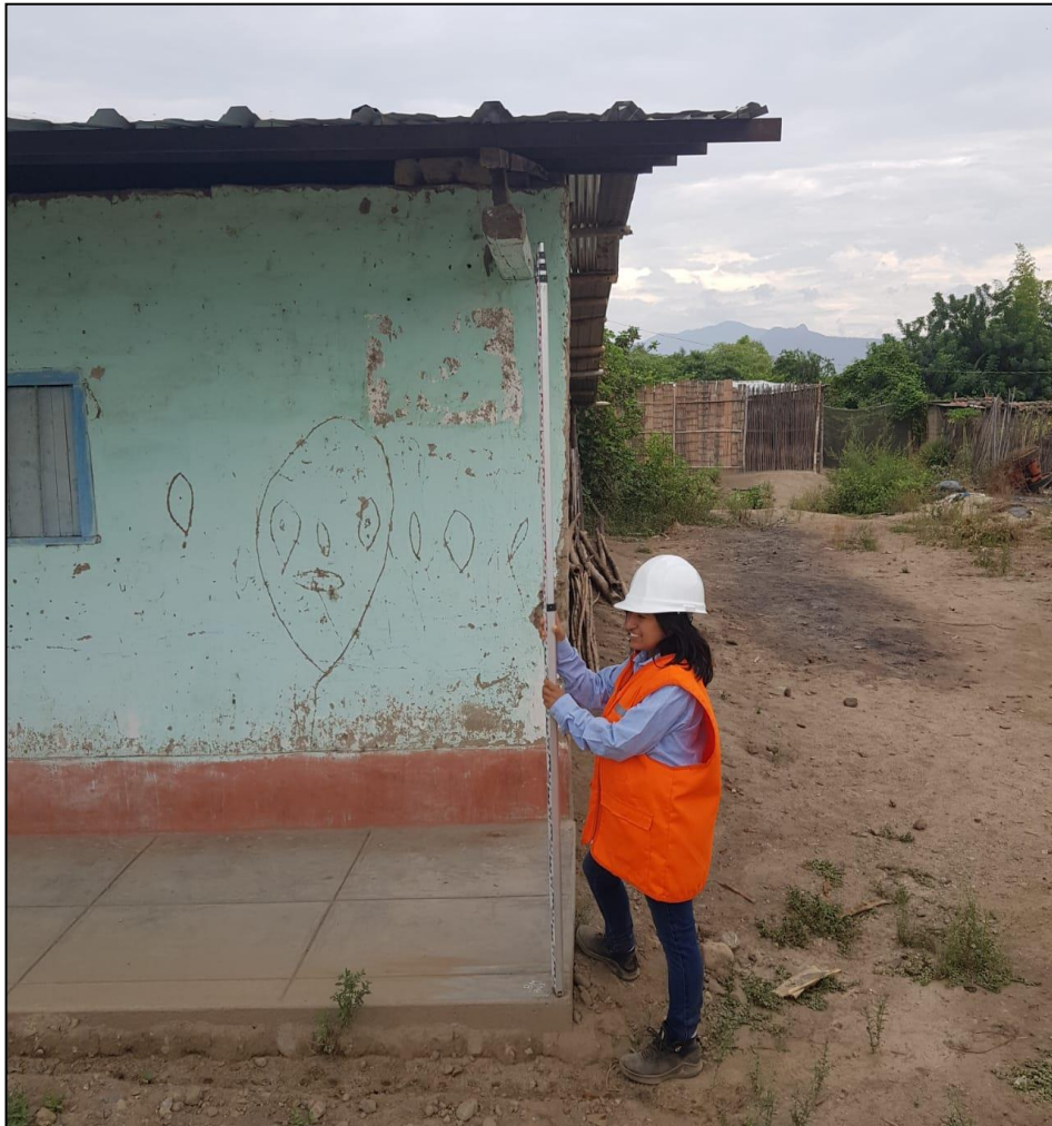
Figura 23: Levantamiento topográfico en calles del Caserío Polvazal Fuente: Elaboración propia (2020).
