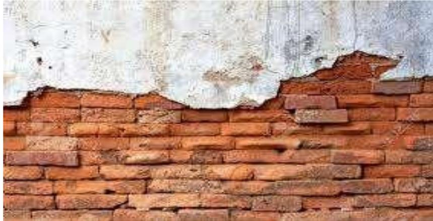
*Figura 17:* Erosión en un Muro.
