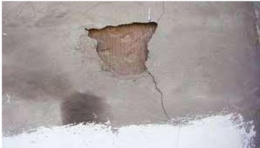
***Figura 20:*** Desprendimiento del Revestimiento en un Muro.
