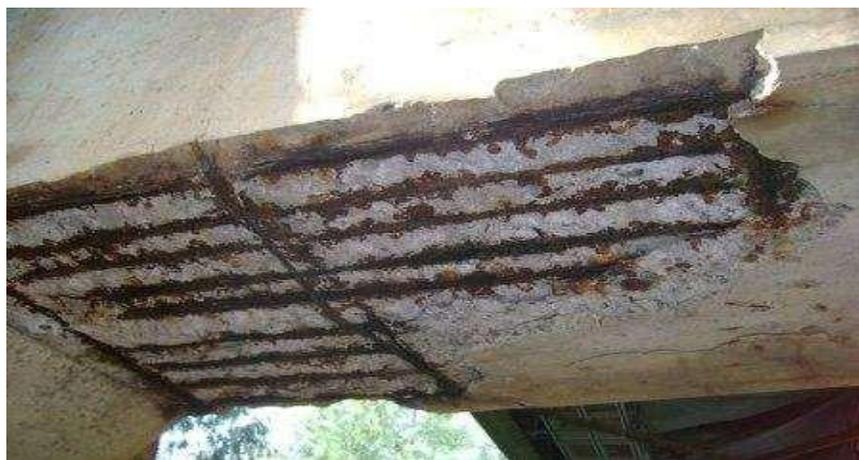
**Figura 16:** Corrosión de una viga.
