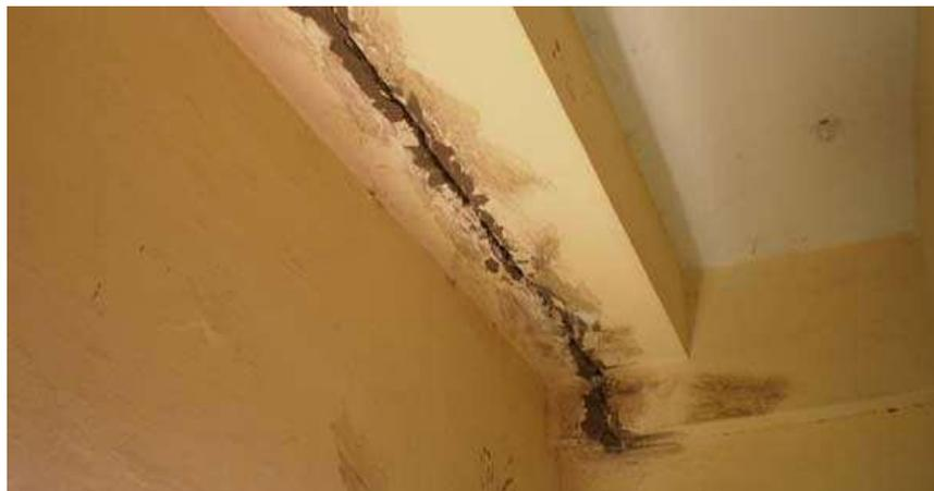
**Figura 15:** Grieta en una Viga.
