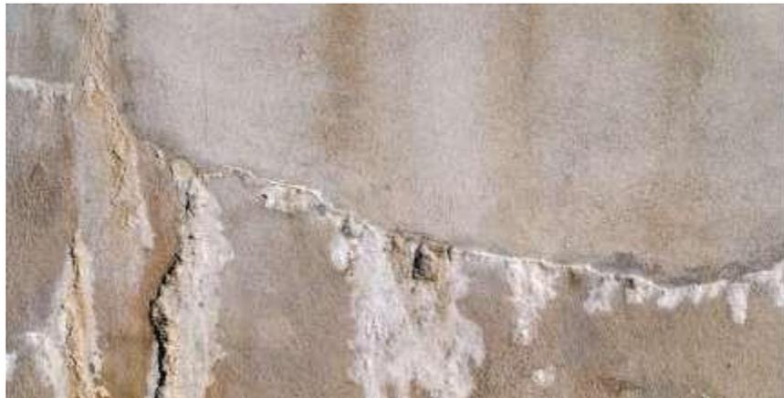
**Figura 19:** Eflorescencia en un Muro.
