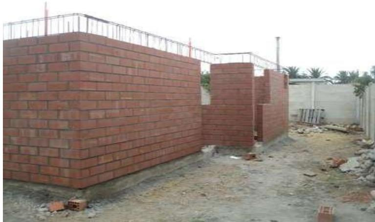
**Figura 4:** Albañilería Simple.
