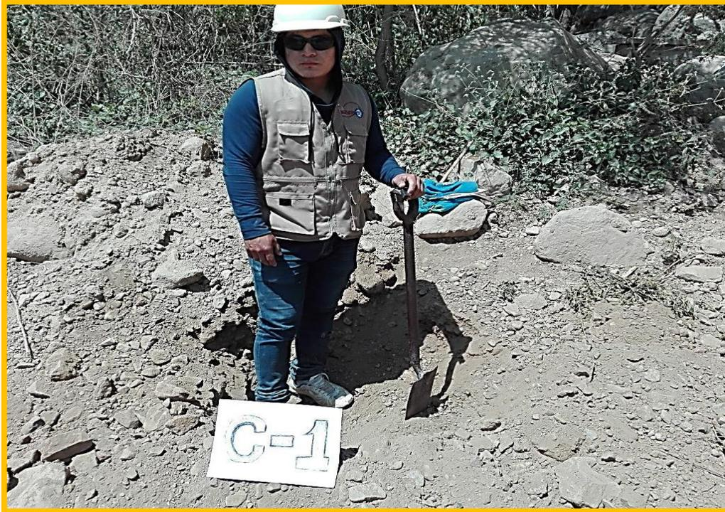
**Imagen N° 08:** Se puede apreciar realizando la calicata 1 en línea de conducción para el estudio de mecánica de suelos.
