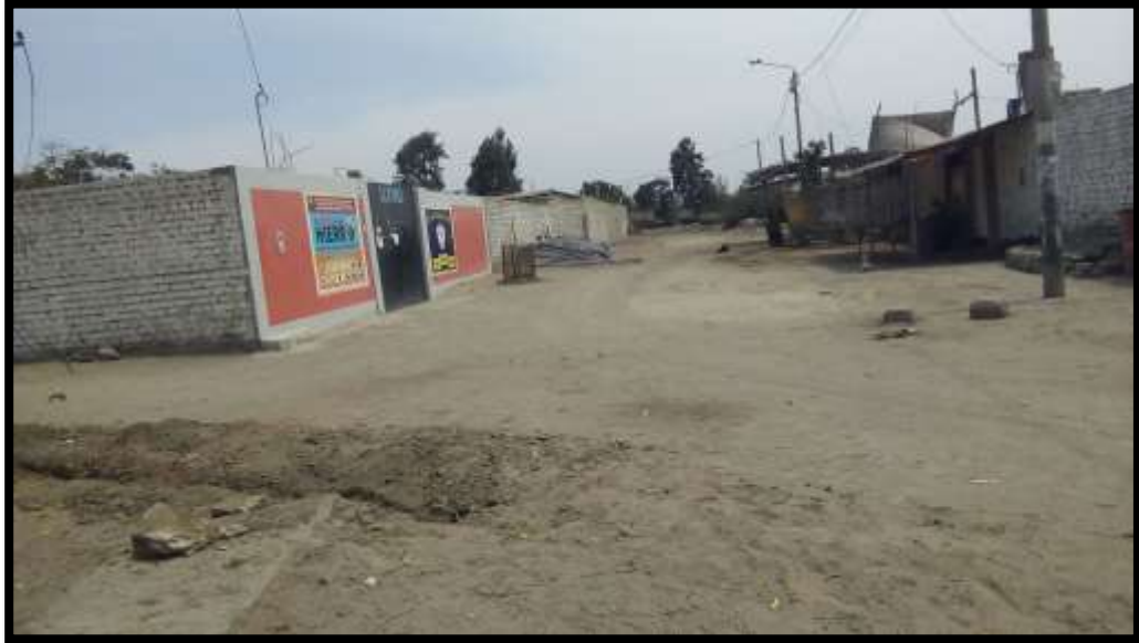
Imagen 7. Inicio del sistema de alcantarillado.
