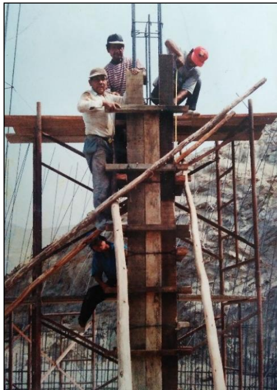
Gráfico 08: Encofrado de una columna. Nota. Fuente: Elaboración propia. (2019)
