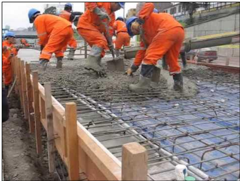
Gráfico 14: Vaciado de Concreto.
