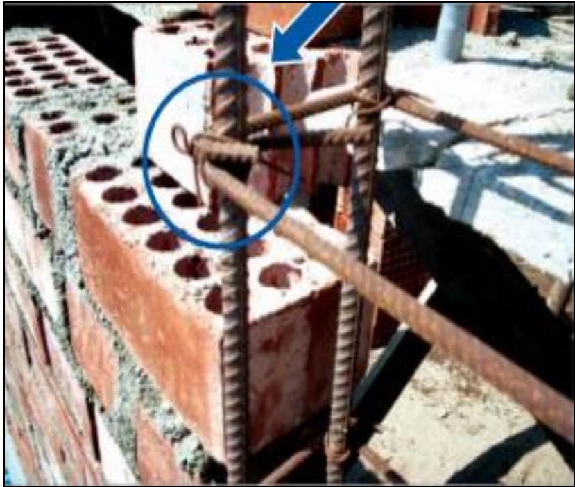
Gráfico 13: Acero mal trabajado. Nota. Fuente: Medina R. (2016)
