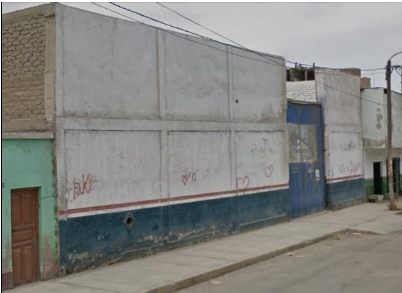
Fotografía 02: Vista panorámica de la estructura de albañilería confinada, de la ex fábrica pesquera, Pesqueras Unidas S.A.C, Distrito de Chimbote, Provincia del Santa, Región de Ancash, Octubre – 2019.
